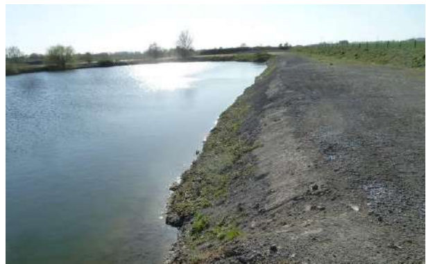
10 - Berge nord du petit étang après travaux d'évacuation du remblai (photo G.Lemoine)
