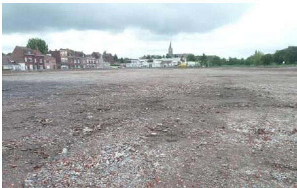
2- État du site (et des « sols ») de l'ancienne filature Saint-Liévin (Wattrelos-59) après déconstruction des usines (septembre 2015)
