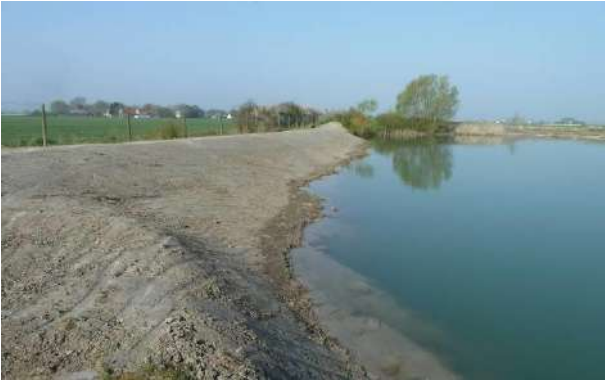
3 - La quasi-totalité des berges fut retravaillée pour créer des pentes douces (photo G.Lemoine)
