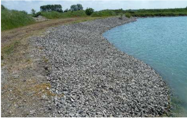
11 - Création d'une plage de galets (diversification des habitats et défense de berge) (photo G.Lemoine)
