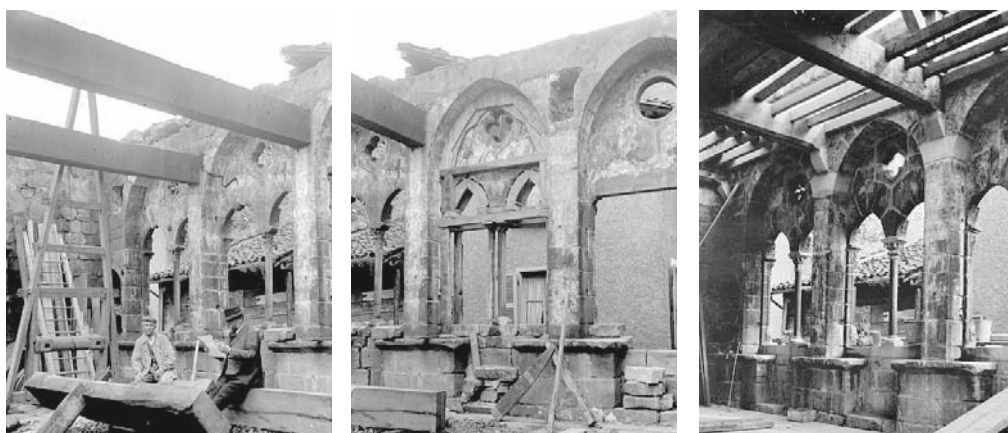
FIG. 7. « MAISON DE LA MONNAIE », intérieur de la salle sud en cours de travaux, avant et après la réfection du plafond. Clichés Chaine n° 36756, 36760 et 36773, Bibliothèque de l'architecture et du patrimoine.
