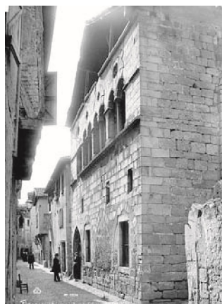
FIG. 5. « MAISON DE LA MONNAIE », façade sud sur la rue Orthabadiel, photographie avant travaux. Cliché Mieusement n° 1204, Bibliothèque de l'architecture et du patrimoine.
