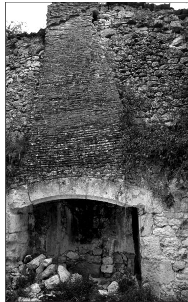
FIG. 10. CHEMINÉE de la pièce 1-2. Cliché Ch. Darles.
