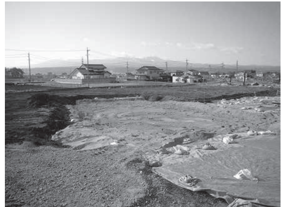
大型住居跡の盛土保存作業2（砂による被覆）
