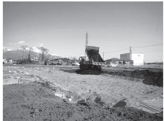
大型住居跡の盛土保存作業4（保護土による被覆）
