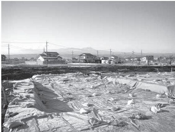
大型住居跡の盛土保存作業1（シートの被覆）
