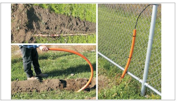
Figure 57 Solid wall conduit
