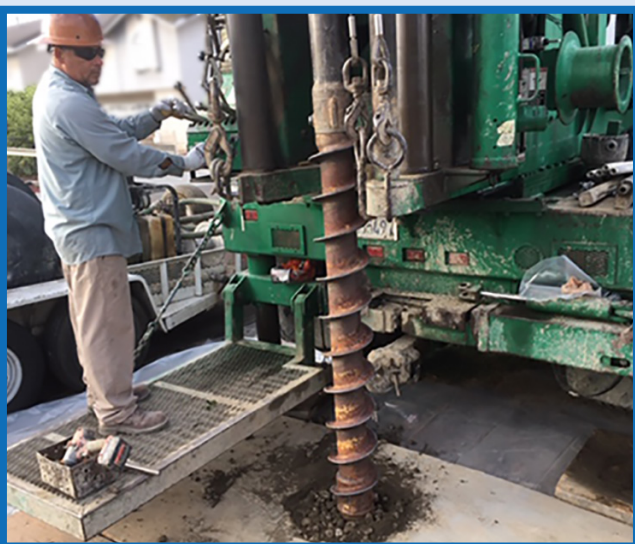
Perforación de pozos de monitoreo en la OU South El Monte.
