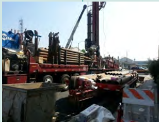
Perforación de pozo
