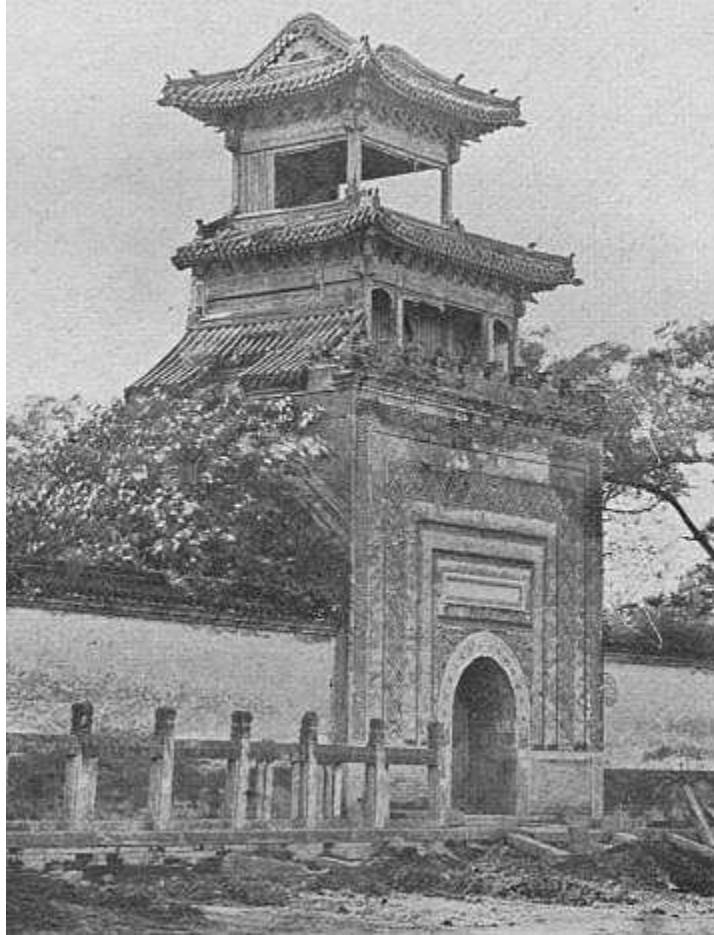
Fig. 43. Porte voûtée de mosquée en ruines Cité impériale. Pékin. XVIIIe siècle
