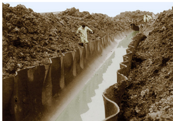
Рис. 8 Разрушение труб при полигонных испытаниях
