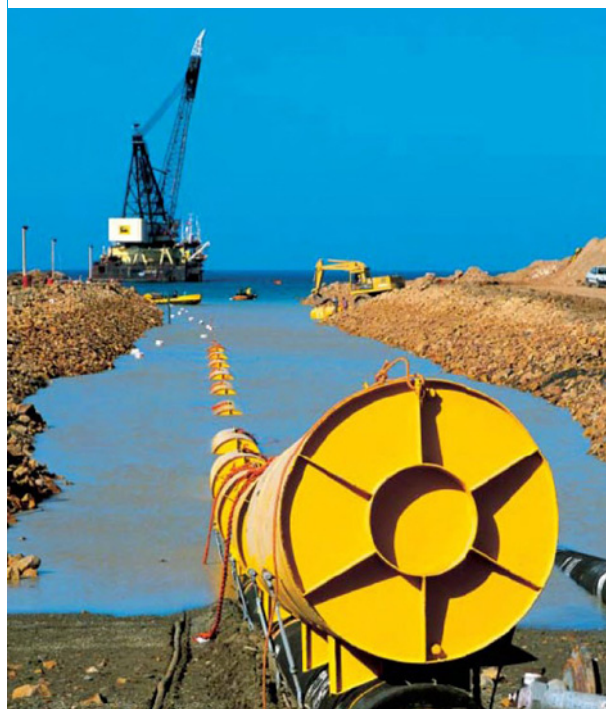
Рис. 3 Укладка трубопровода в подготовленную траншею
