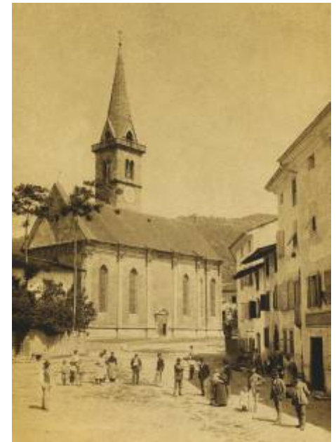
Chiesa di / Iglesia de Civezzano (s. XIX)
