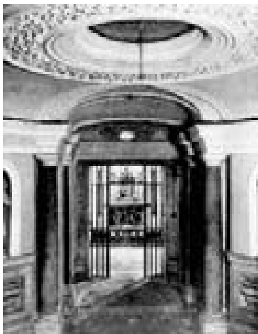
Fig.24 – Ss. Luca e Martina: chiesa inferiore, sala ottagonale al di sotto della cupola
