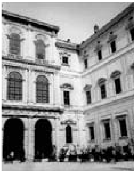
Fig.6 – Palazzo Barberini: facciata, dettaglio. Si noti la soluzione dell'innesto con l'avancorpo
