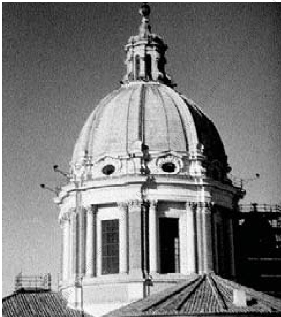
Fig.5 – Ss. Ambrogio e Carlo al Corso: cupola
