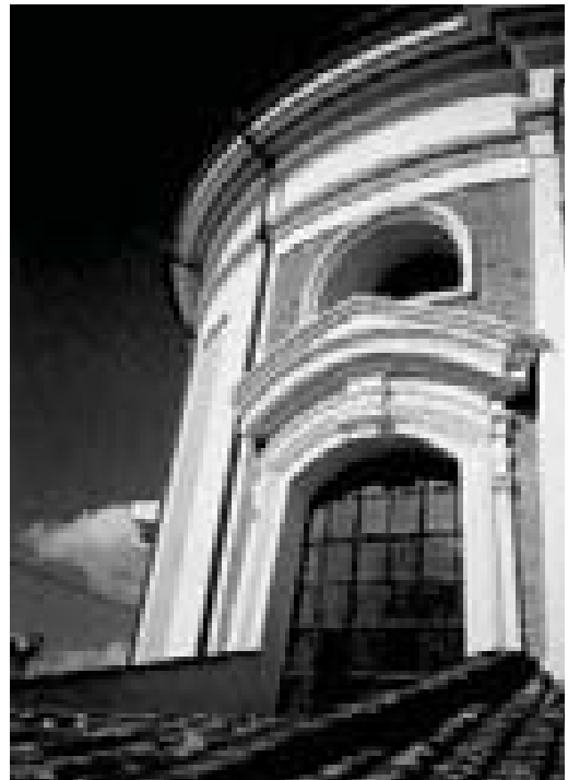
Fig.6 – Ss. Ambrogio e Carlo al Corso: tribuna, finestrone esterno (1668)
