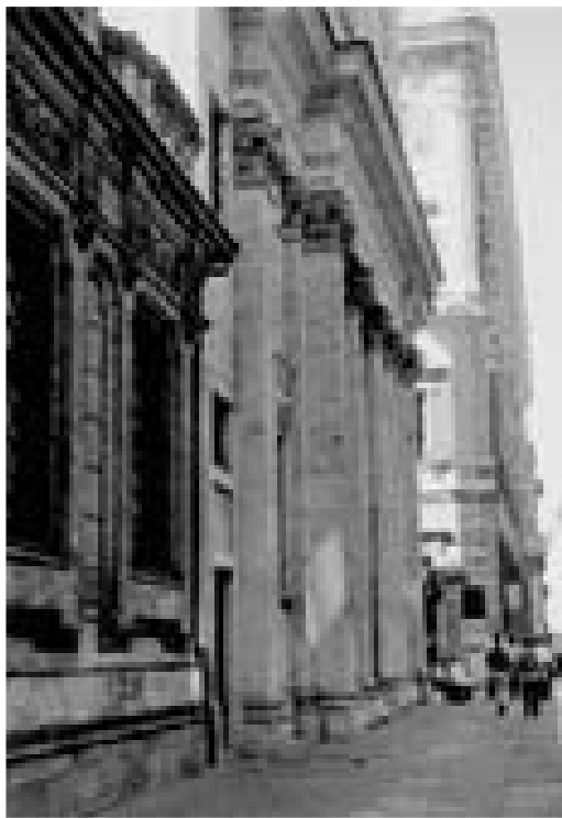
Fig.9 – S. Maria in Via Lata: facciata, dettaglio dell'ordine inferiore (veduta di scorcio)
