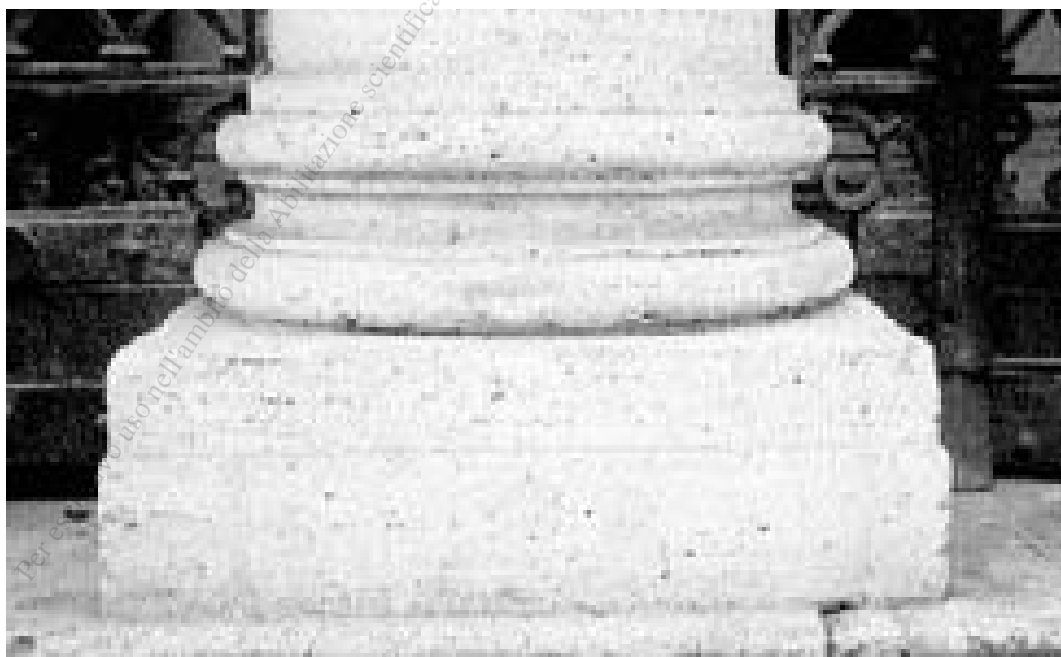
Fig.10 – S. Maria in Via Lata: facciata, dettaglio della base attica dell'ordine corinzio
