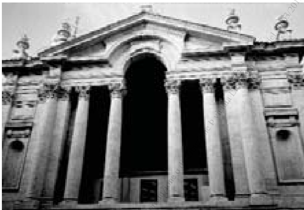
Fig.11 – S. Maria in Via Lata: facciata, ordine superiore, al termine del restauro (1998)
