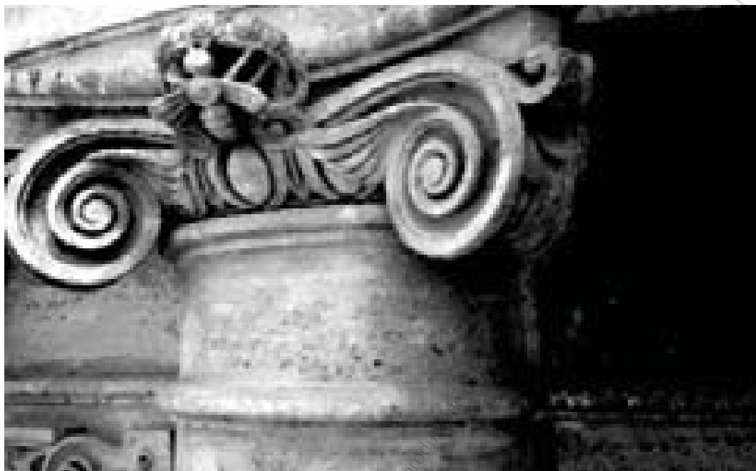
Fig.9 – Ss. Luca e Martina: facciata, dettaglio del capitello dell'ordine ionico. Dal modello michelangeloesco del palazzo dei Conservatori – accuratamente rilevato, tra gli altri, da Francesco Villamena (1619) – sono ripresi il collarino e le volute diagonali, mentre risulta assente il festone. In corrispondenza del flos abaci, al posto della maschera buonarrotiana, è visibile l'ape: un esplicito richiamo araldico ai Barberini e, in particolare, al cardinale Francesco (1597-1679), principale finanziatore della chiesa
