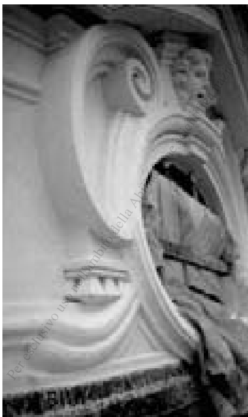
Fig.14 – Ss. Ambrogio e Carlo al Corso: cupola, dettaglio del tamburo. A differenza di quanto realizzato nel corso del recente restauro, sia i pilastri in cortina che le colonne in tevolozza presentavano originariamente un'uniforme tinteggiatura a finto travertino (AALR, Liber Instrumentorum..., 57, ff.39v-42r)
