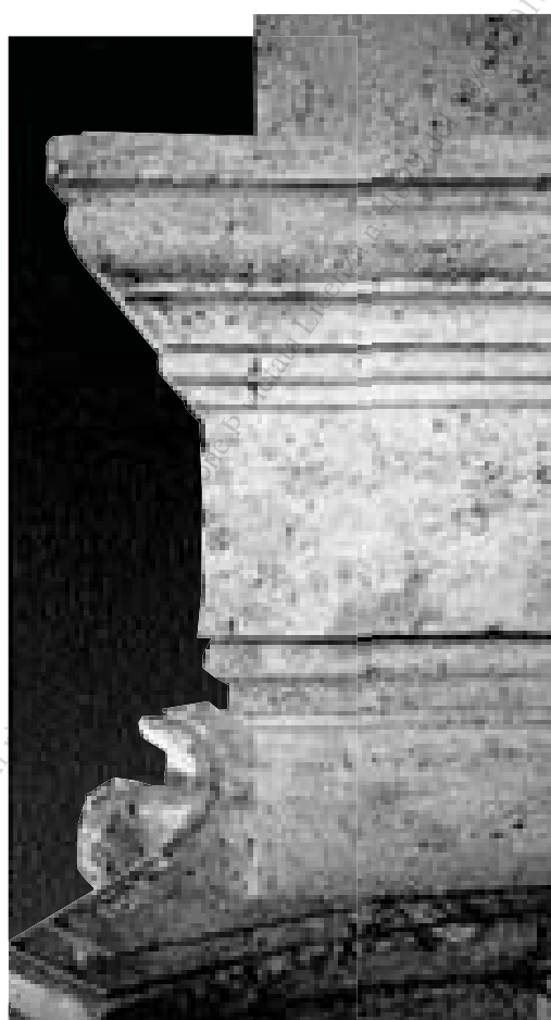
Fig. 13 – S. Maria in Via Lata, facciata: trabeazione dell'ordine corinzio, dettaglio dell'architrave
