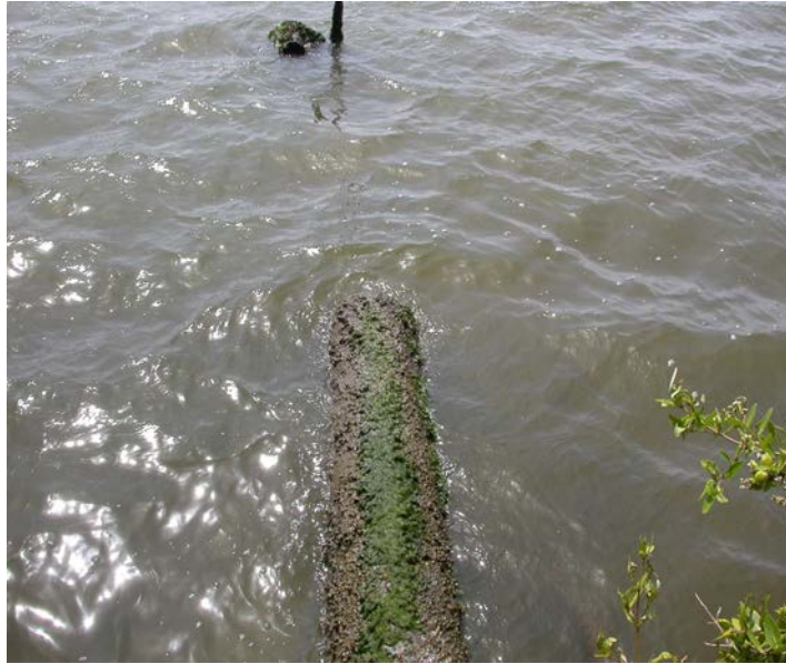
Figure 61 : Tuyau de rejet de la station d'épuration du Quartier d'Orléans dans l'Etang aux Poissons, Photo P. Araminthe
