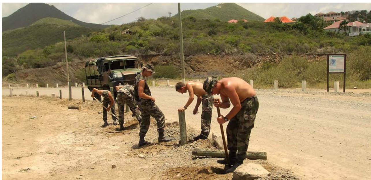
Figure 72 : Pose de barrières plots dans le secteur des Salines d'Orient par le personnel du Service Militaire Adapté de Guadeloupe et de Martinique. Photo N. Maslach
