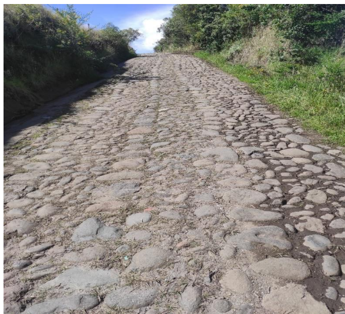
Gráfico 24. Estado de la vía.
