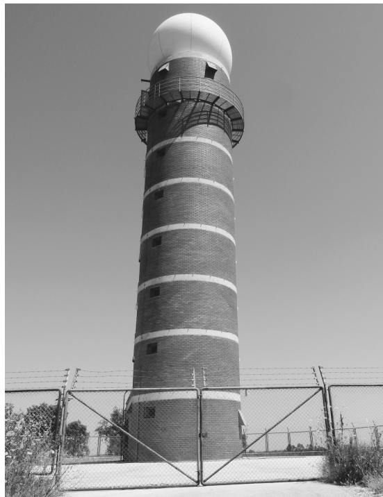
Fig.2.22 – Fotografia do RADAR meteorológico do IM, I.P. instalado em Loulé na Serra do Caldeirão. (Autor: Sandra Correia)
