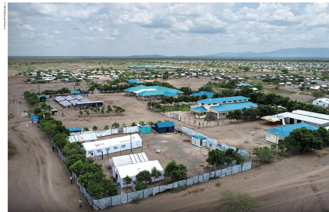
Installation d'isolement et de traitement COVID-19 pour les réfugiés et les membres de la communauté d'accueil au centre de santé de Nalemsokon dans le camp de Kalobeyei, Kenya.
