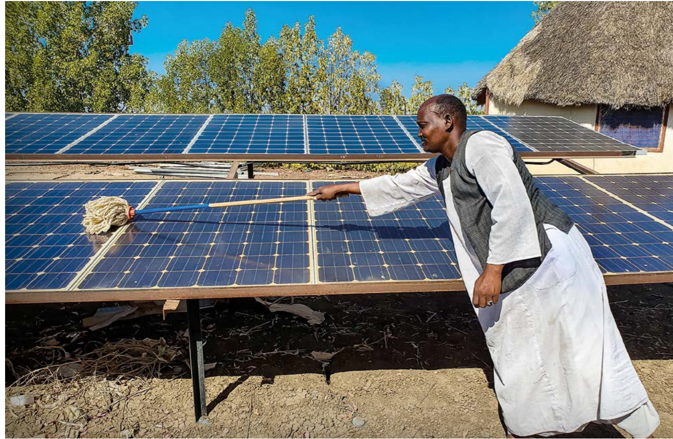
Un réfugié opérateur de pompe nettoie les cellules qui alimentent la pompe solaire dans le camp d'Um Gargour, au Soudan.
