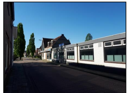
Figuur 8. Bebouwing aan oostzijde projectlocatie.
