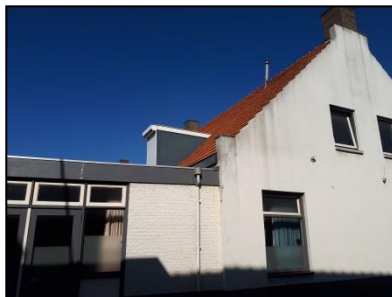
Figuur 7. Bebouwing aan oostzijde projectlocatie.
