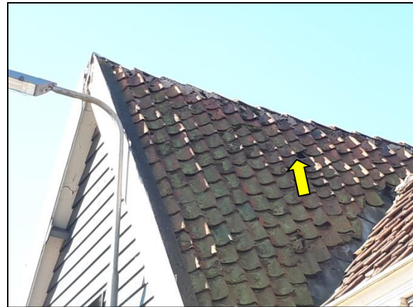
Figuur 14. Ruimte tussen dakpannen geschikt voor vleermuizen.
