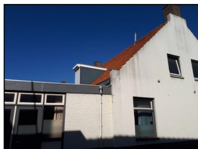
Figuur 7. Bebouwing aan oostzijde projectlocatie.
