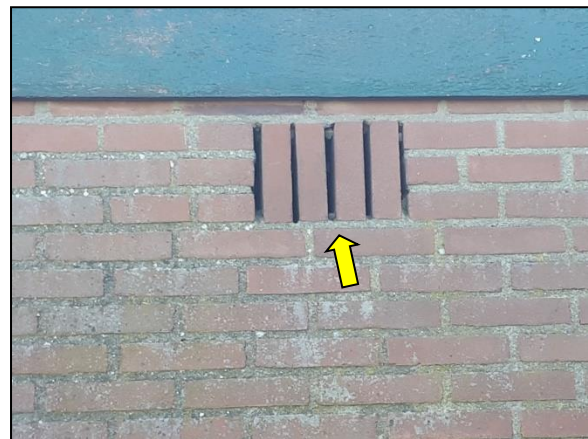
Figuur 12. Stootvoegen die een geschikte opening voor vleermuizen vormen.
