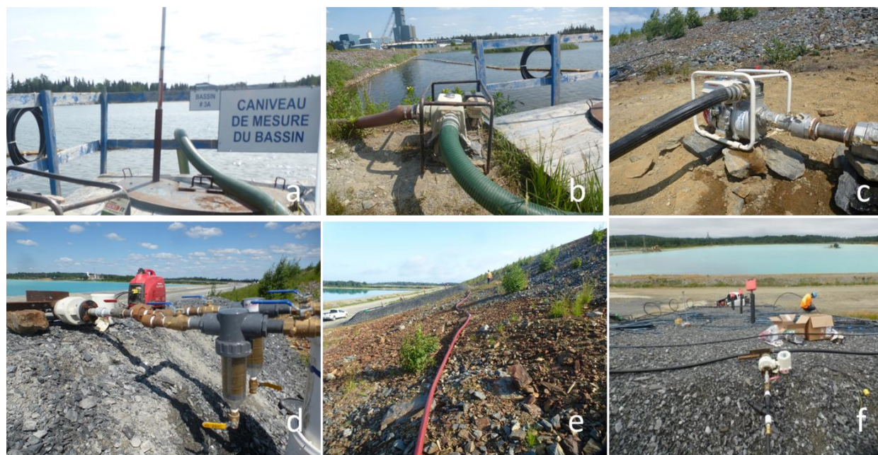
Figure 3.10 Installation du système d'irrigation
