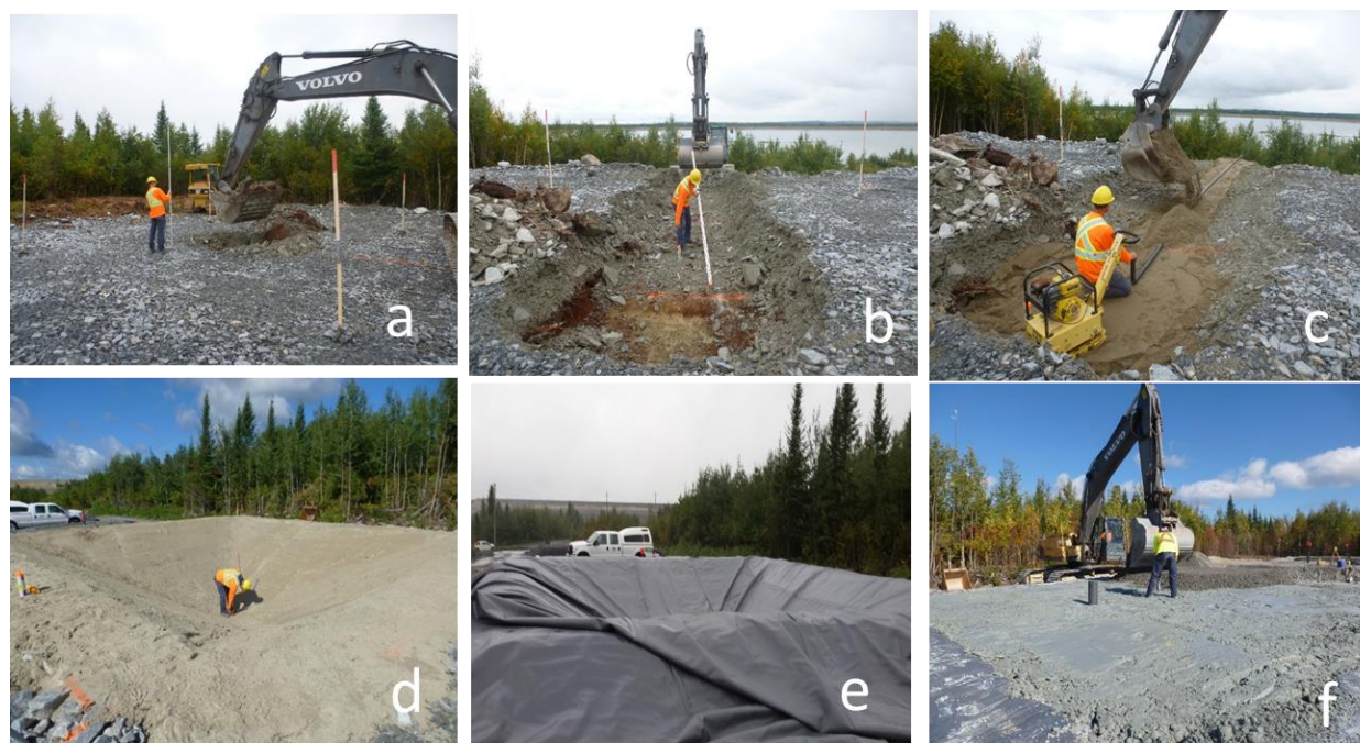
Figure 3.3 Photos de construction de cellules horizontales et creuses
