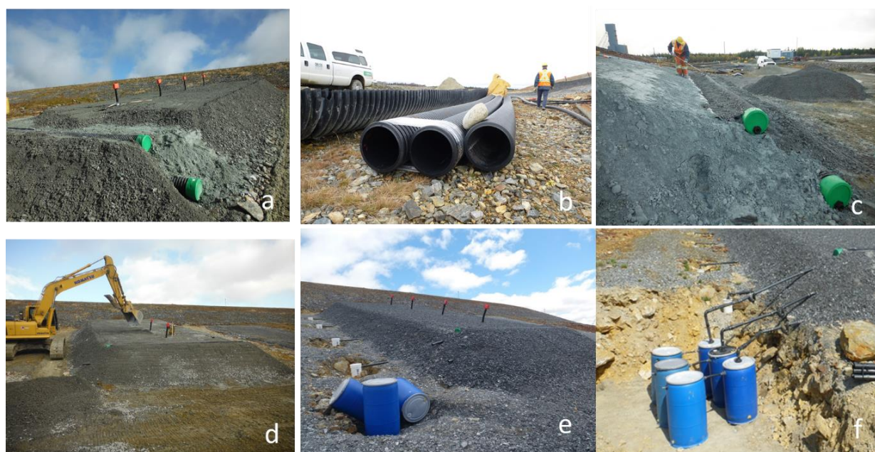
Figure 3.7 Photos de construction de la cellule expérimentale inclinée (suite)
