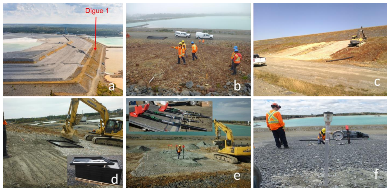
Figure 3.6 Photos de construction de la cellule expérimentale inclinée
