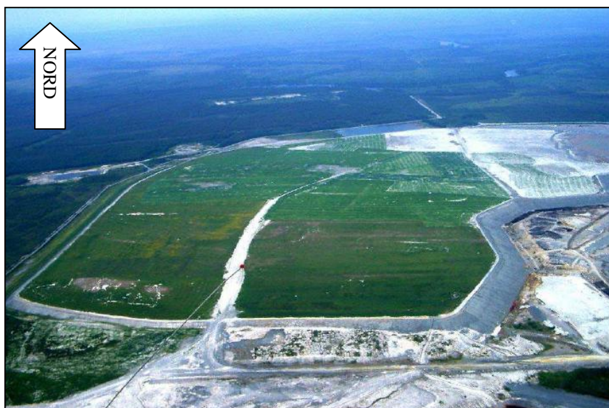
Figure 4-41 : Vue aérienne du parc à résidus de Selbaie (Caron et al., 2005)
