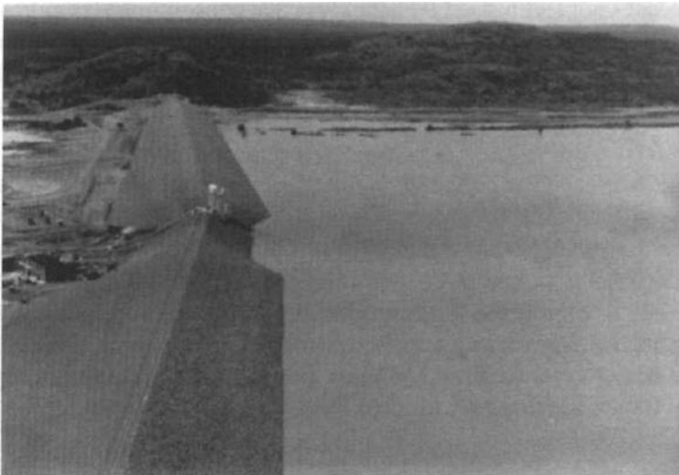
FIG. 4.11 L'évacuateur de crue du barrage de Bagré (Burkina Faso). Source: Sonabel, Burkina Faso.
