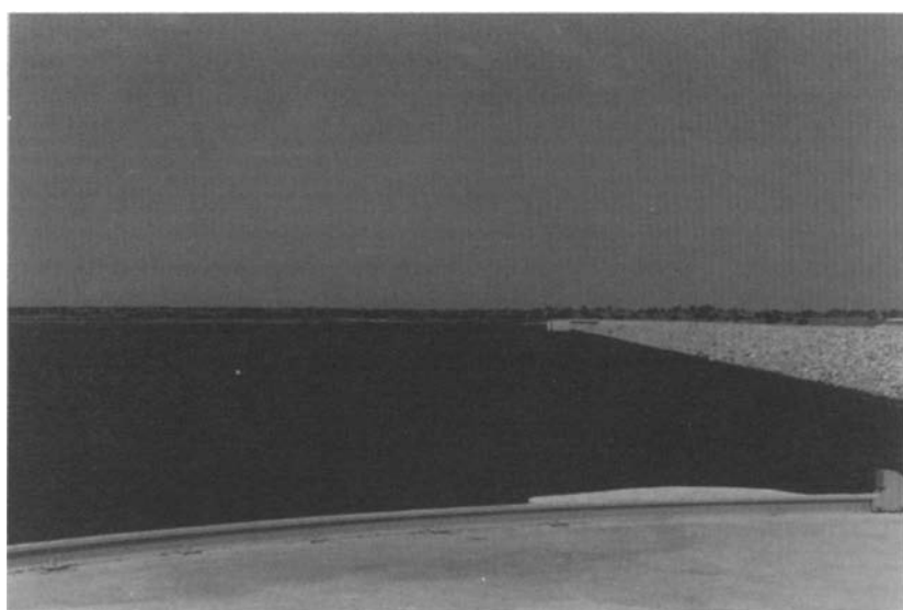
FIG. 4.9 Barrage hydroélectrique de la Kompienga (Burkina Faso).
