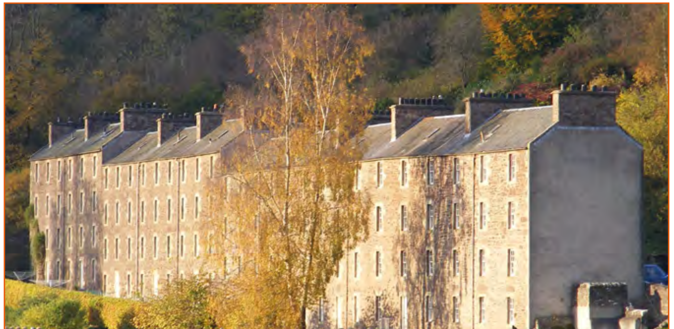
New Lanark : Braxfield Row. Maisons bâties entre 1790 et 1795 sur la pente. En 1903, 36 logements avec lavoir et caves. En 1975-1980, rénovation en dix logements
