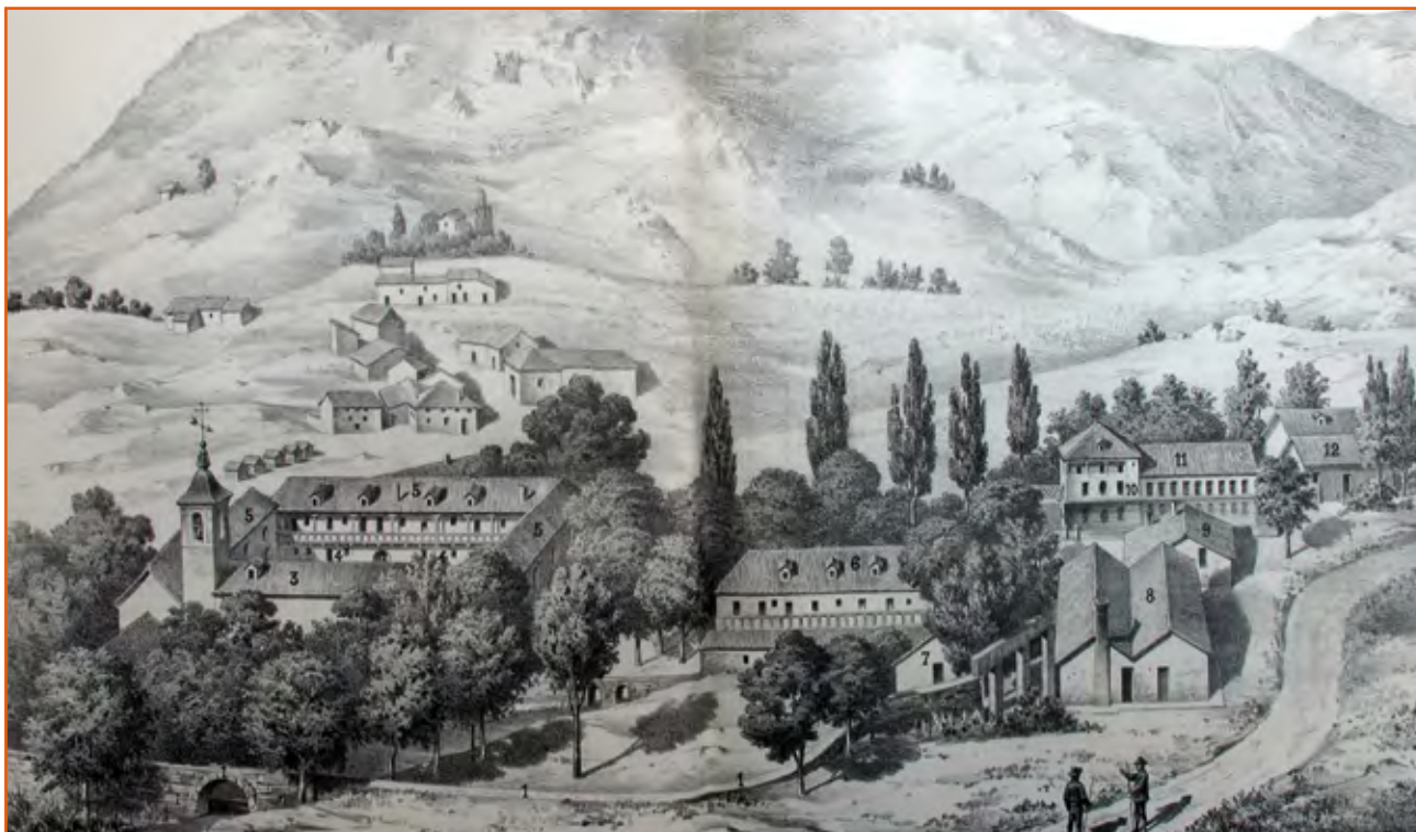
Édifice de direction, ateliers et logements de Saint Vincent, halles de San Pablo et quartier de Saint Charles. Catalogue de la Compagnie métallurgique de San Juan de Alcaraz, 1879
