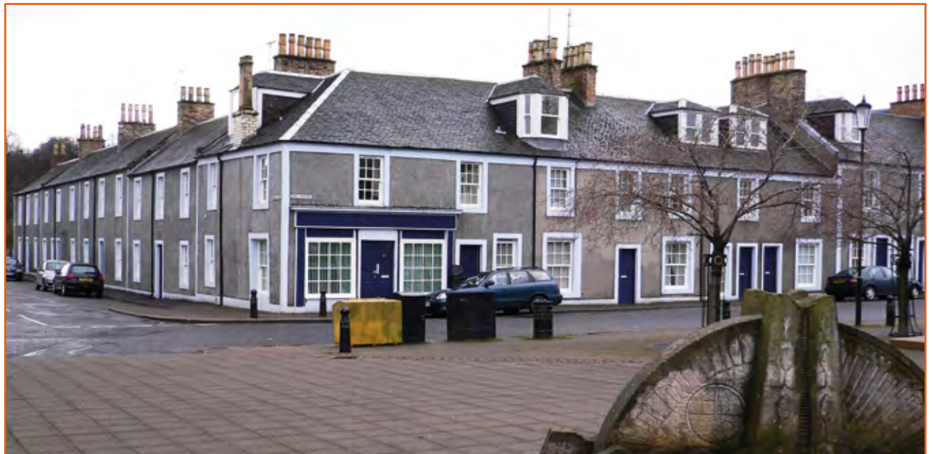
Catrine : Maisons des années 1785-1820 situées sur la place du village où se dressait la filature. Rénovés, les logements comptent moins de portes d'entrée qu'à l'origine
