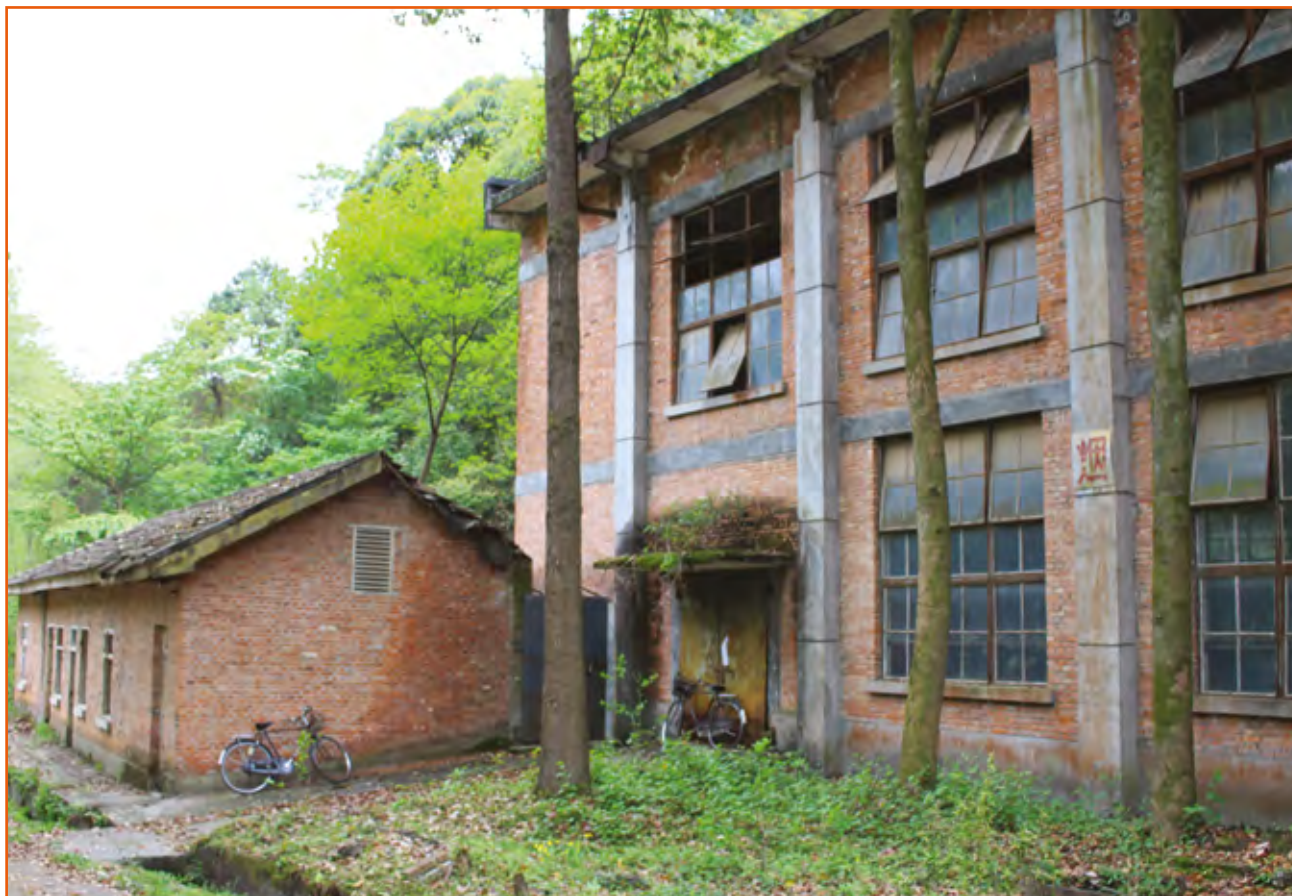
Les vestiges de l'usine 857
