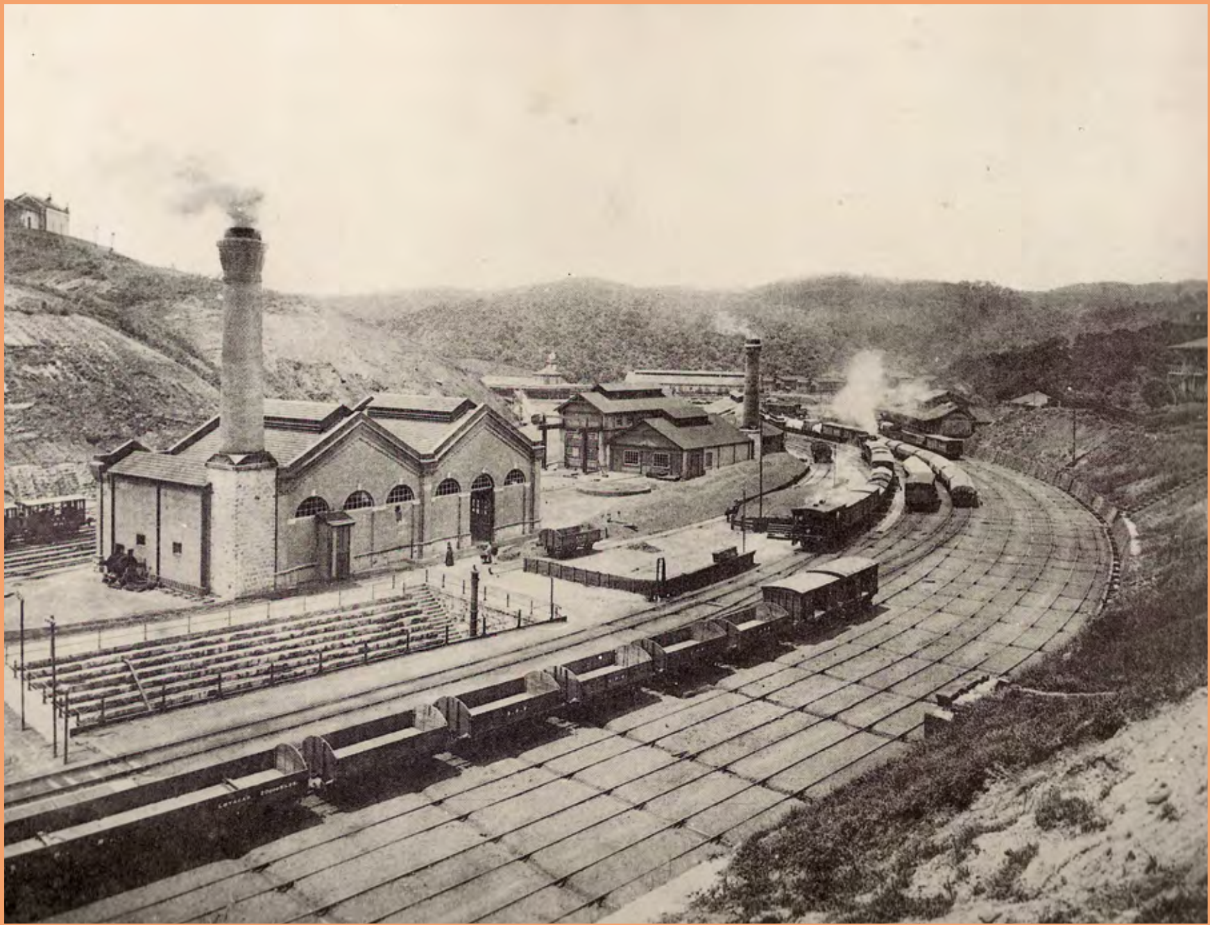
La plate-forme ferroviaire de Paranapiacaba, 1900
