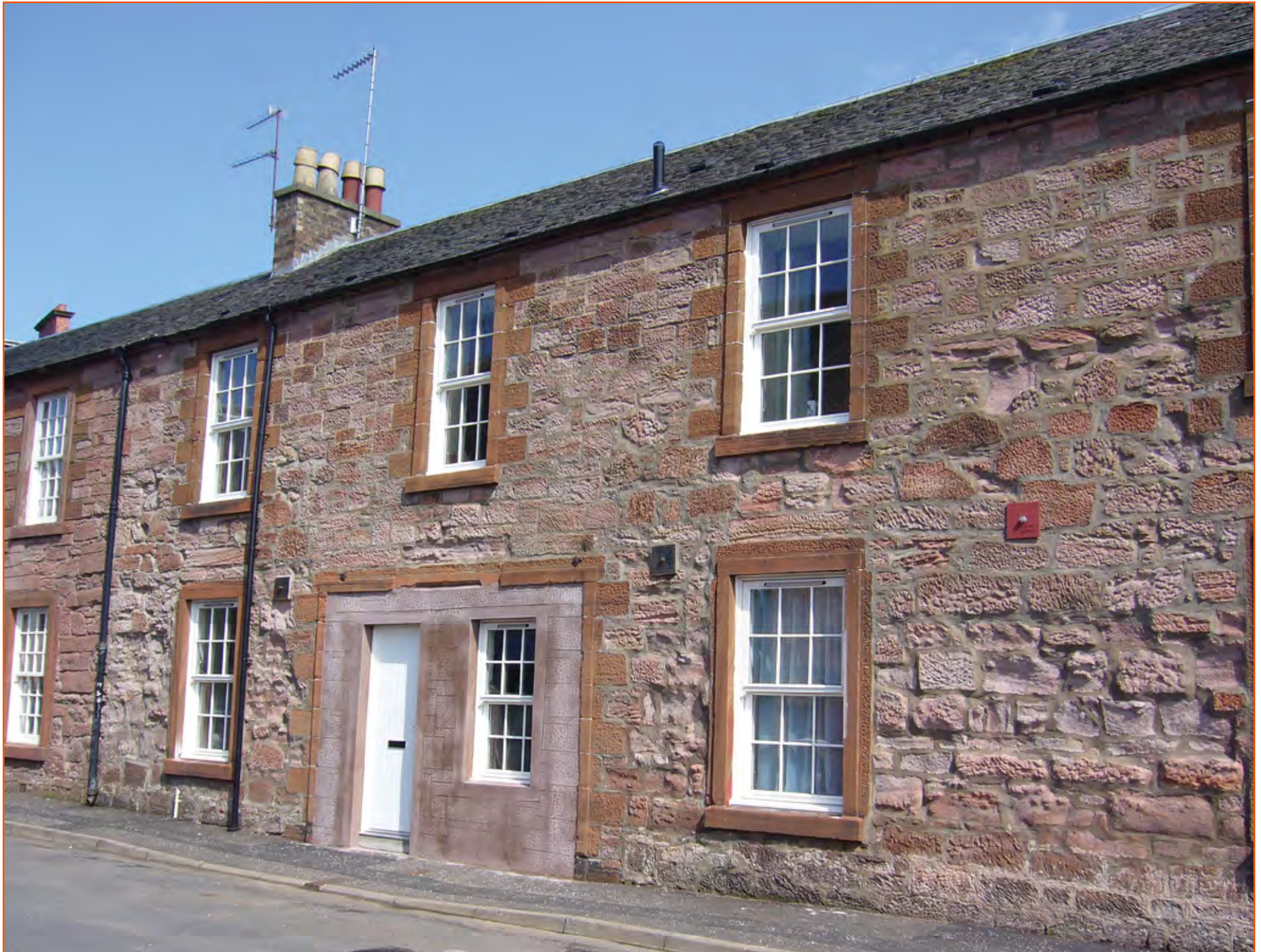
Catrine : maisons ouvrières rénovées, une porte d'entrée a disparu
