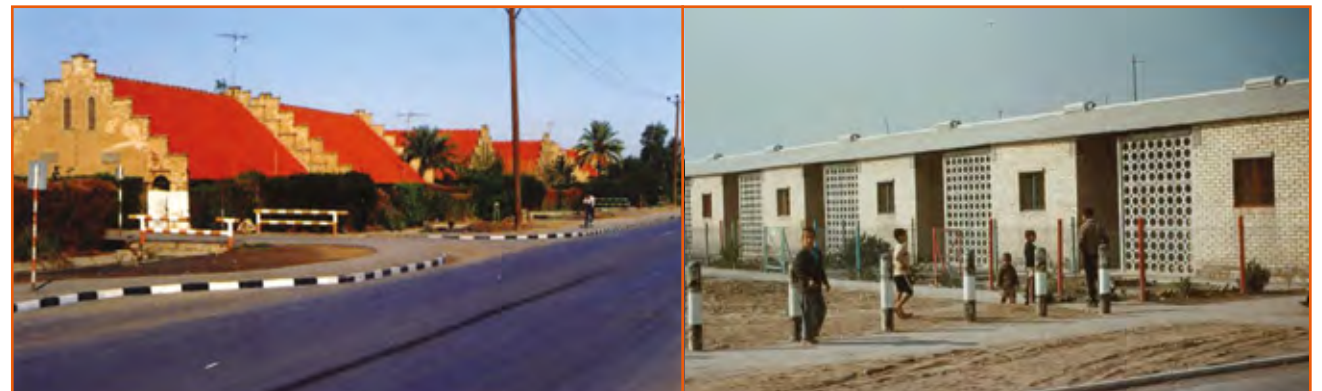
A gauche : maisons de contremaîtres à Bashamshir. À droite : habitat ouvrier de Pirooz
