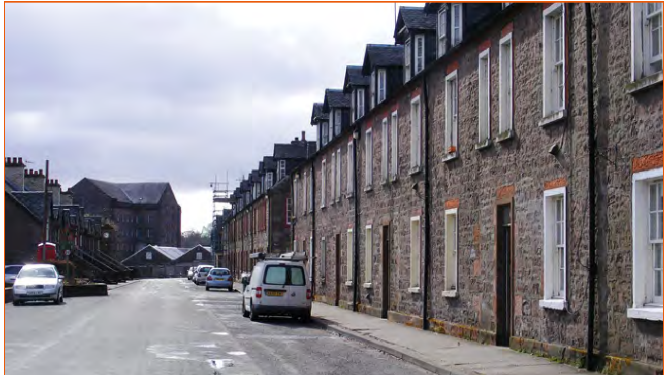
Le déversoir de Deanston et des maisons d'ouvriers. Rénovés, les logements comptent moins de portes d'entrée qu'à l'origine
