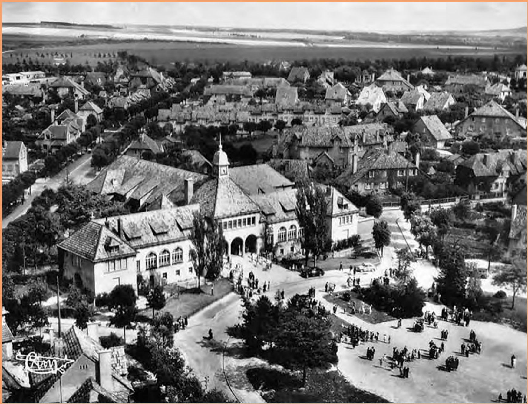
Vue sur la Maison Commune du Chemin Vert à la fin des années 1920
