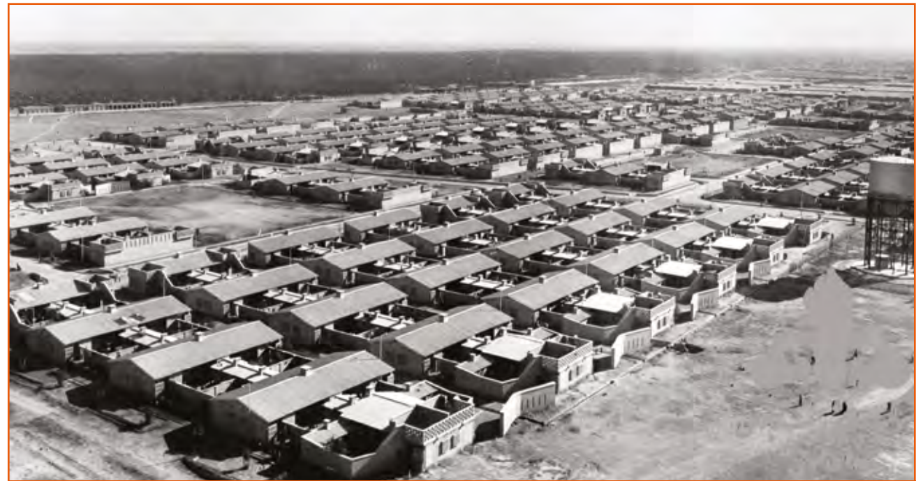
Quartier ouvrier de Pirooz dans les années 1960 : ce quartier construit pour la main-d'œuvre subalterne présente un exemple parlant d'identité culturelle. À droite, un château d'eau dont on trouve des exemples dans chacun des quartiers
