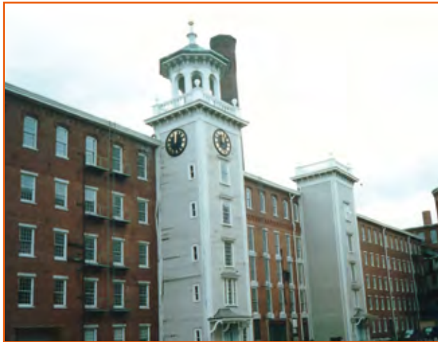
Lowell (1875), Façade de l'usine n° 8
