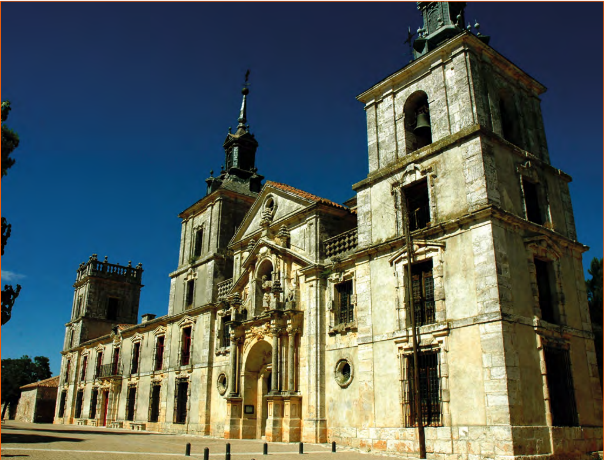
L'église et la maison de direction Nuevo Baztán
