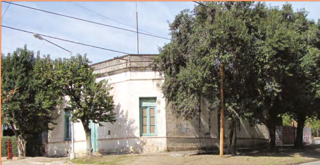
Une maison d'angle
