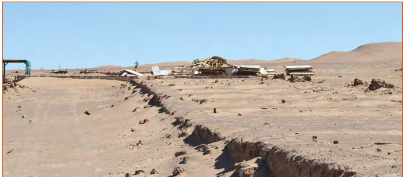
Campamento Don Guillermo : ruines des logements en enfilade (la surélévation correspond à aux entrées)
