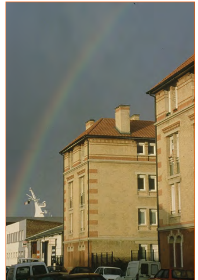
Le Foyer Belge-résidence Jean Walter – façades rue – Le Havre
