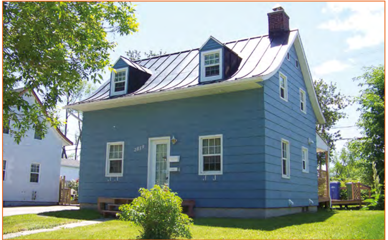
Telle qu'elle était représentée dès 1927 dans le catalogue des immeubles d'Arvida tenu par l'entreprise, l'une des maisons « canadiennes-françaises » de la première phase de construction d'Arvida, caractérisée non seulement par son architecture extérieure et sa silhouette, mais aussi par son intérieur, qui reprend la traditionnelle « salle de famille »
