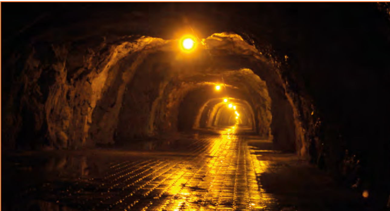
Le tunnel d'Ogarrio
