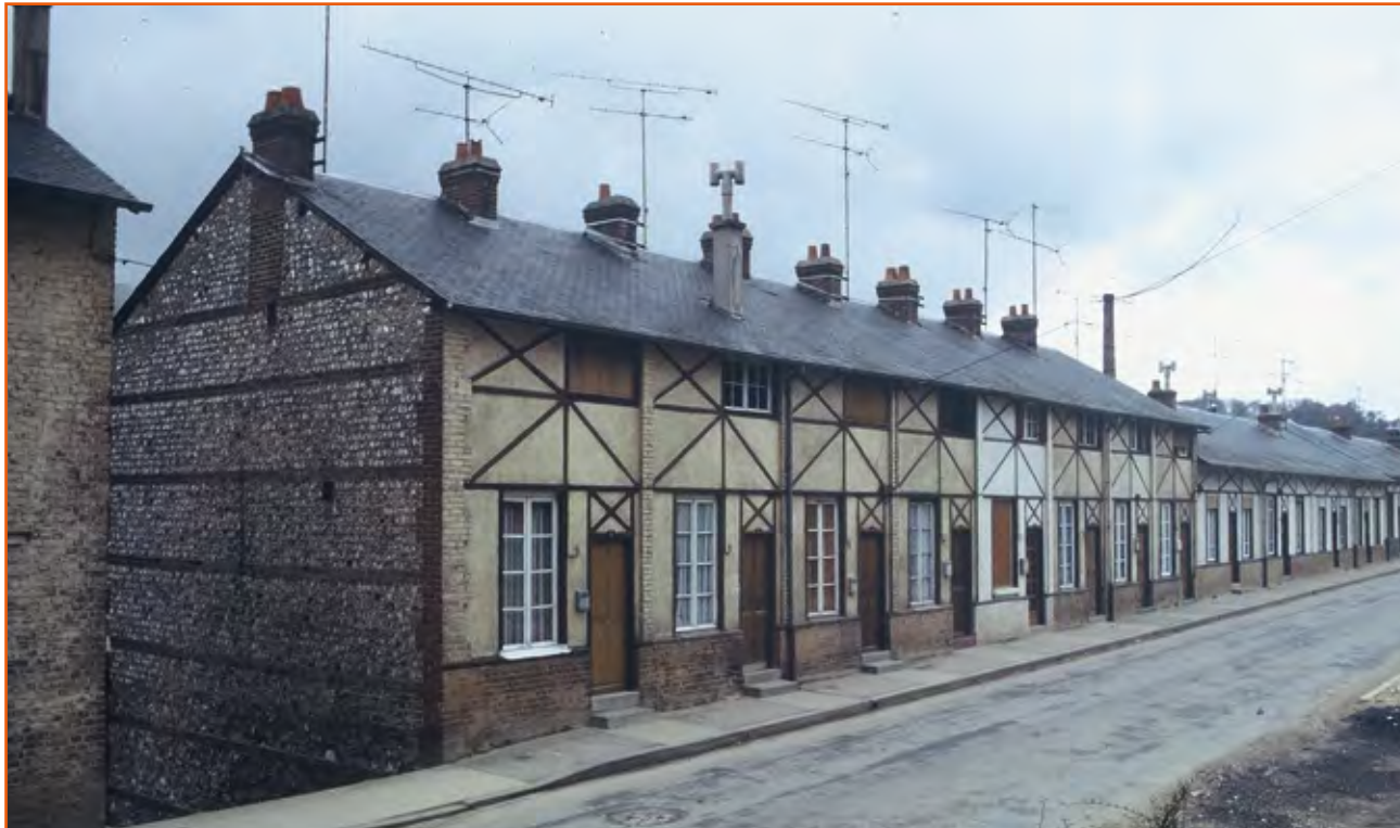
Maisons dos-à dos à Barentin
