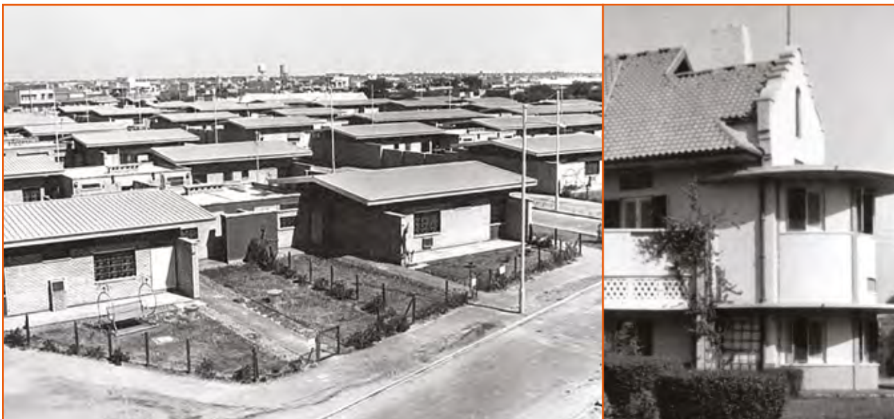
A gauche : maisons de Bawarda dans les années 1960. À droite : on ne construisit pas les toitures à deux versants pour raison climatique mais en vertu de l'aspect pratique de la structure et de la rapidité de la construction. Toutes les maisons ont une cour d'entrée et une arrière-cour pour les services
