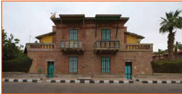
Logements pour ouvriers européens, type B3 assemblés par deux, Port-Tawfiq, 1924, Paul Albert, architecte
