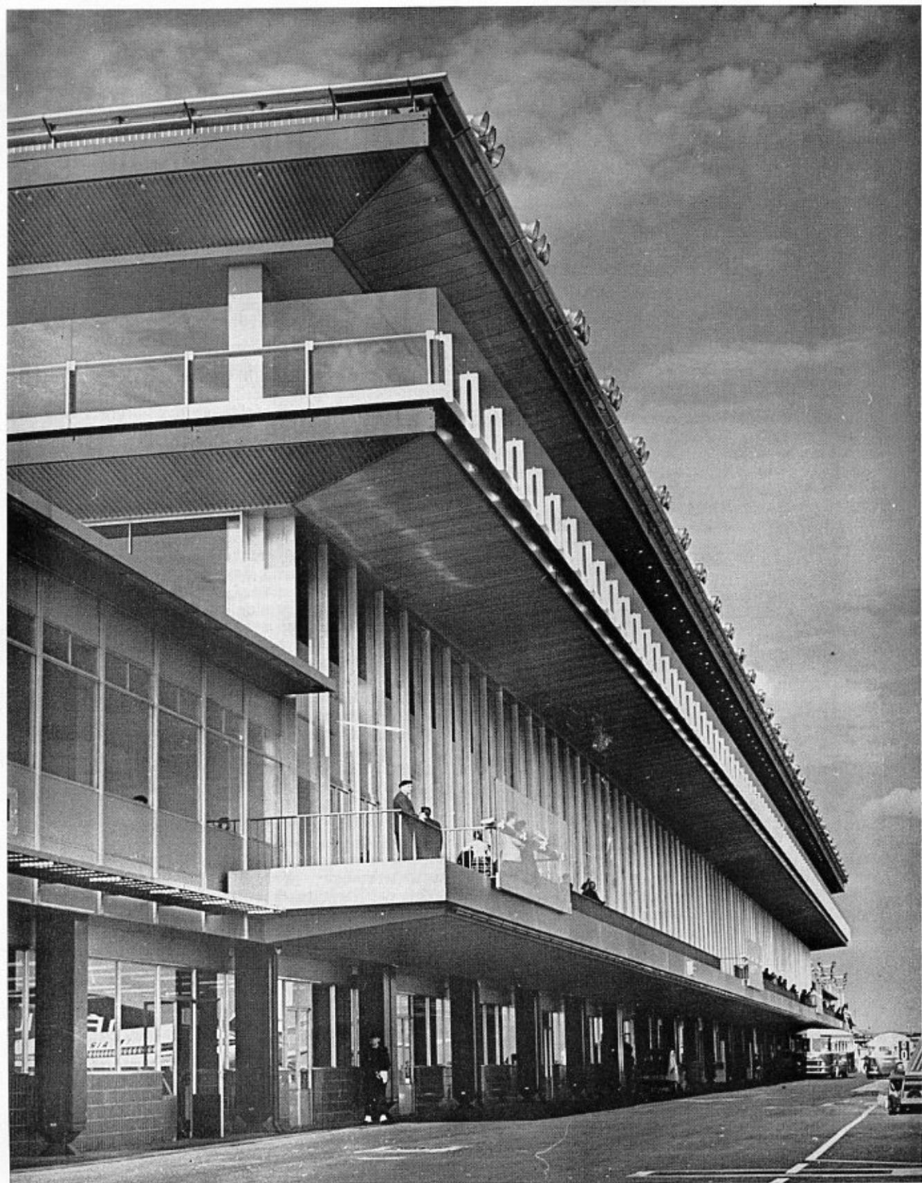
Balcons, auvents et menuiseries en aluminium du bâtiment central de la façade Sud de l'aérogare d'Orly.
