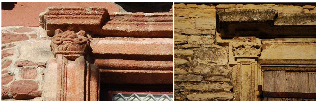
Fig. 28 : Façade sud-est, 1 er étage, 3 e travée, détail de la croisée. À droite, maison de Gradels à Valady, élévation sud, 2 e étage, détail de la croisée (cliché Julie Lourgant, 2009).
