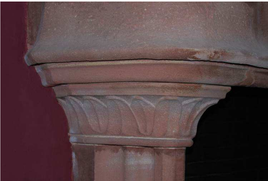
Fig. 64 : Salle du rez-de-chaussée surélevé, cheminée, détail d'un piédroit.
