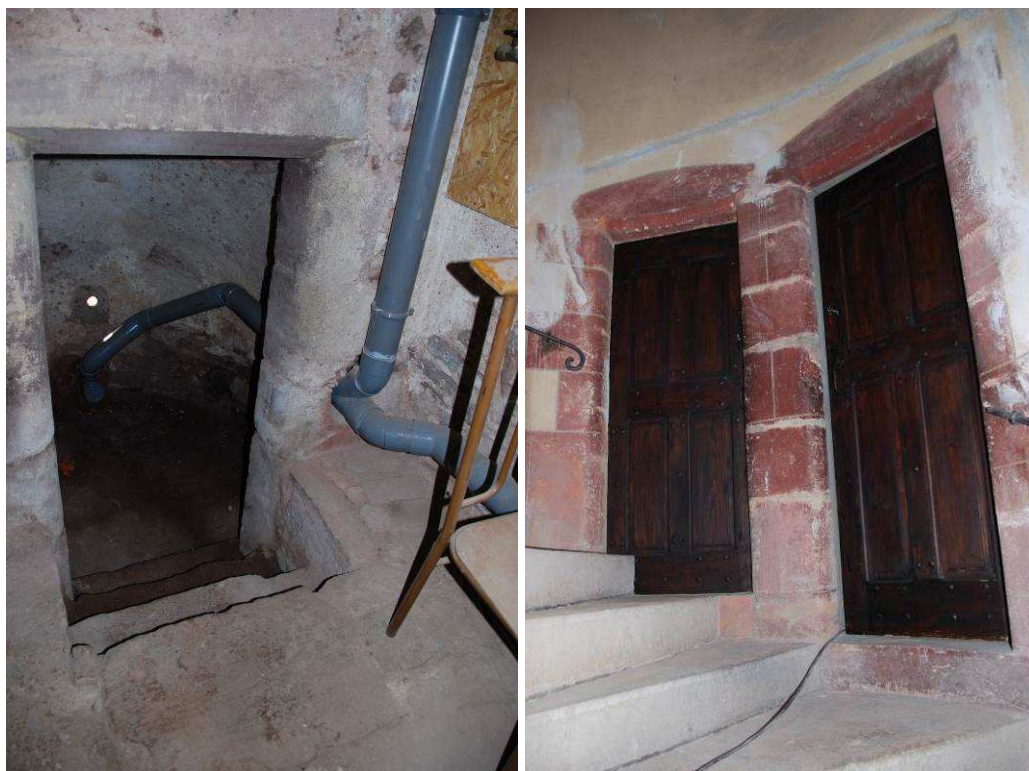
Fig. 57 : Sous-sol, pièce D, accès à la casemate ; Fig. 58 : Portes d'accès au rez-de-chaussée surélevé, depuis l'escalier.
