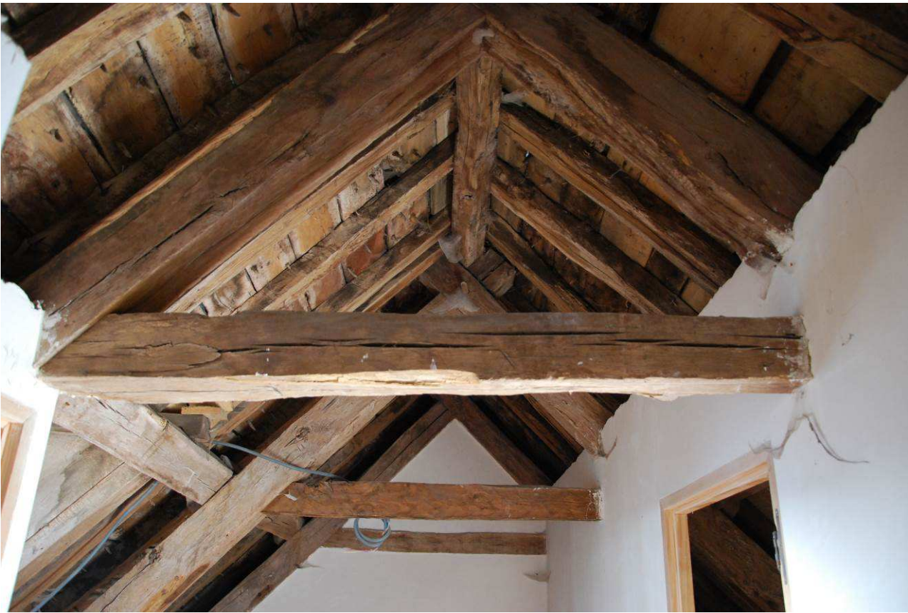
Fig. 77 : Comble, charpente de toiture du noyau initial.
