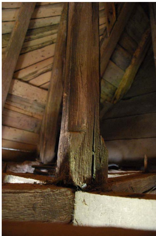
Fig. 81 : Charpente de l'échauguette sud, poinçon et enrayure ; Fig. 82 : Charpente de l'échauguette ouest, détail du poinçon.
