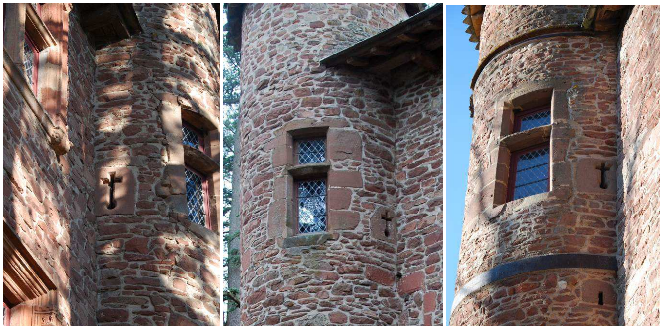
Fig. 33 : Échauguette est, détails des archères à croisillon flanquant les murs sud-est et nord-est ; échauguette sud, archère à croisillon flanquant le mur sud-est.
