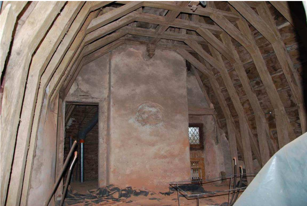
Fig. 78 : Vue de la charpente du comble de l'extension.
