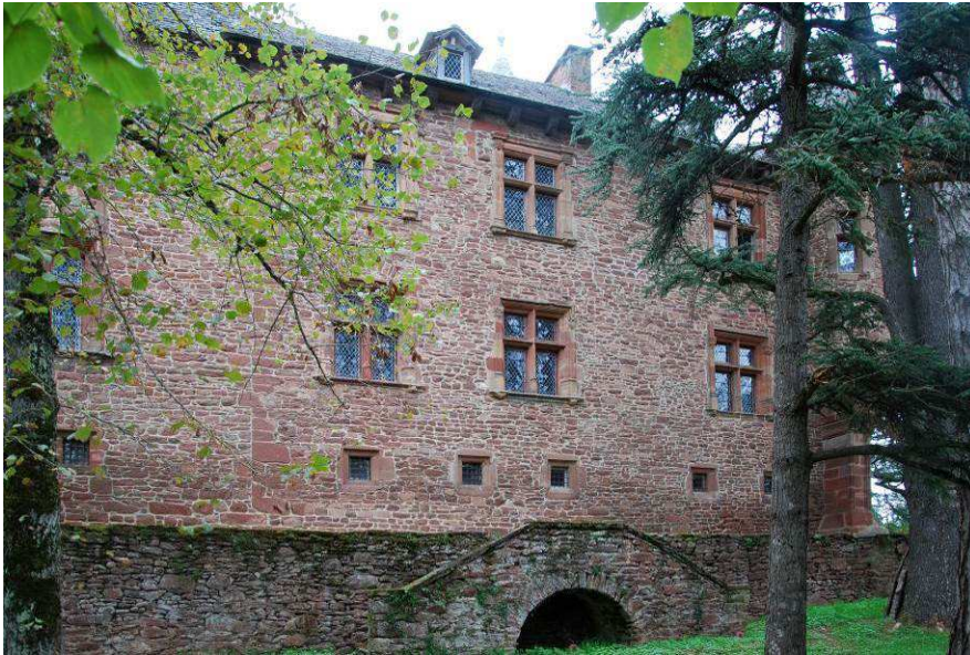
Fig. 20 : Façade sud-est, vue générale.
