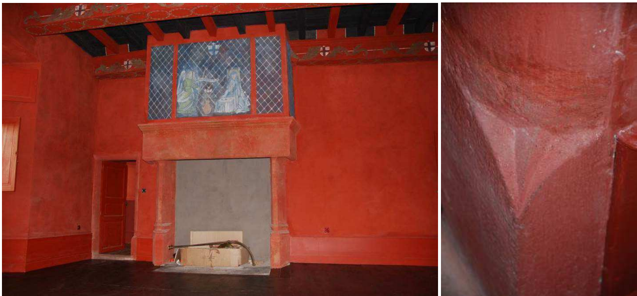
Fig. 73 : 1 er étage, chambre B, cheminée ; Fig. 74 : 1 er étage, porte d'accès à la chambre D, détail du congé en bec.
