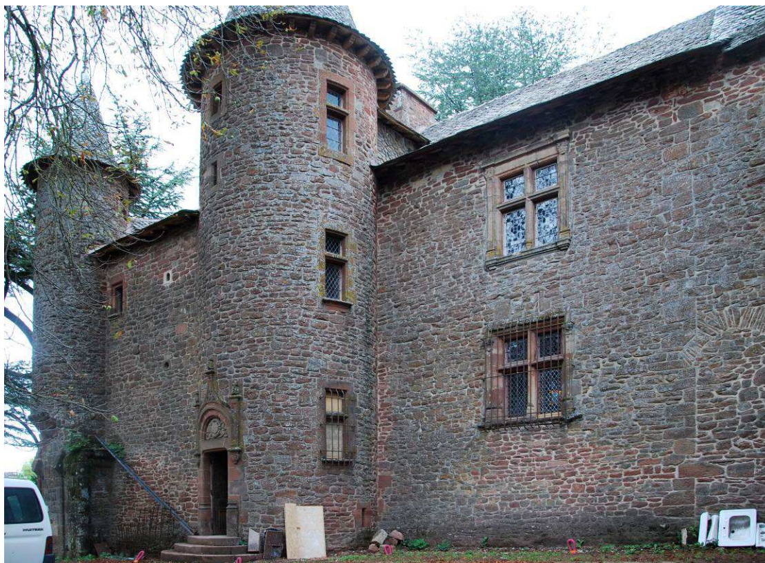
Fig. 41 : Façade nord-ouest, vue générale depuis l'ouest.
