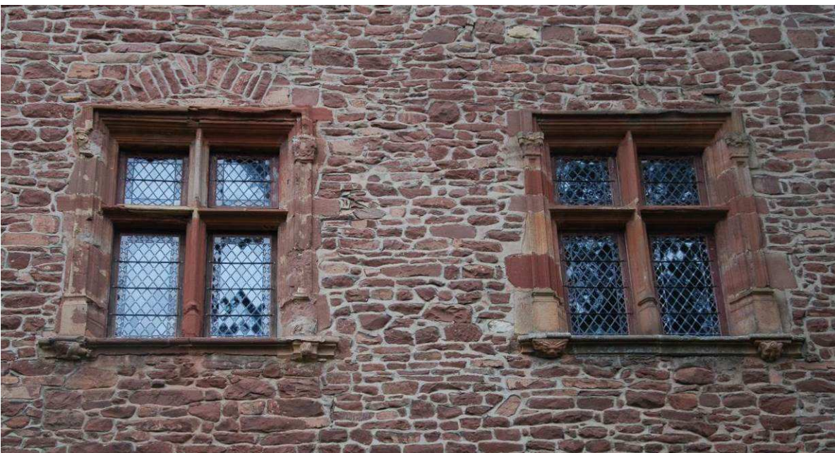
Fig. 23 : Façade sud-est, rez-de-chaussée surélevé, détail des croisées centrales.
