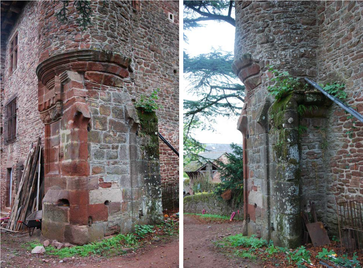
Fig. 4 : Base de l'échauguette nord, vestige de l'ancien portail et du chemin de ronde.
