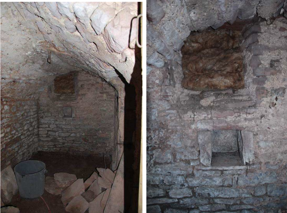
Fig. 49 : Sous-sol, pièce voûtée basse : vue générale et détail du mur nord-est.
