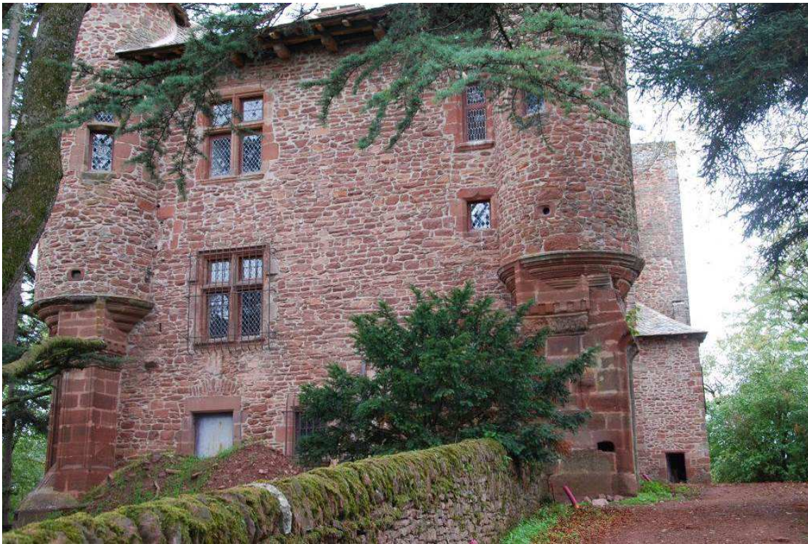
Fig. 12 : Vue de la façade nord-est.
