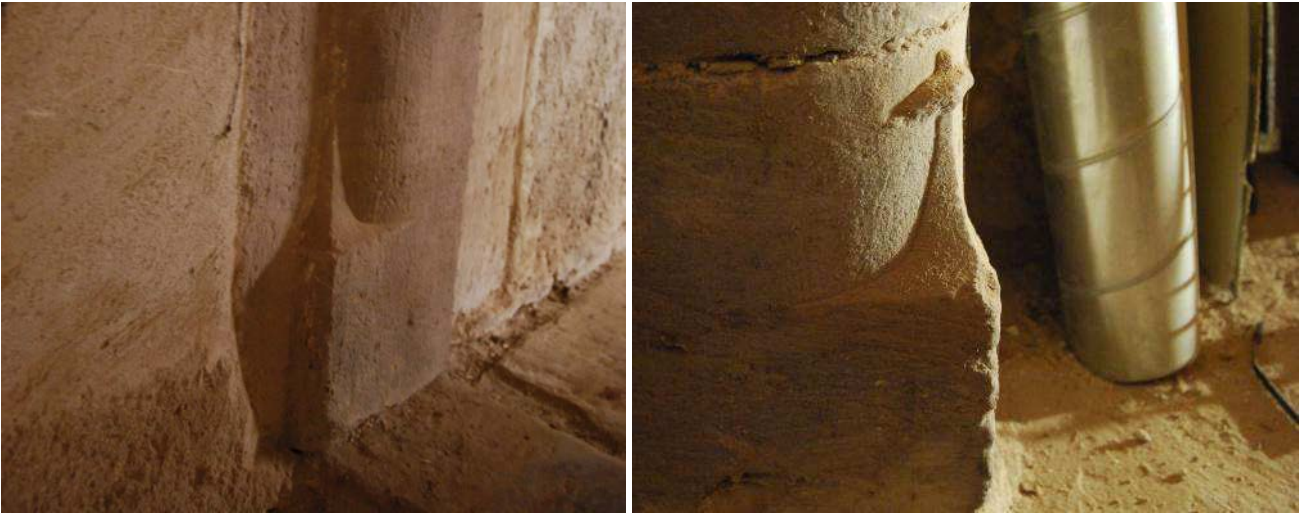
Fig. 54 : Sous-sol, porte du mur 2, détail des congés.
