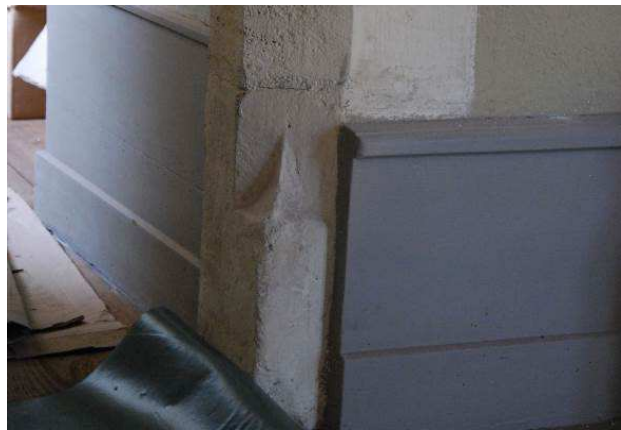
Fig. 67 : Rez-de-chaussée surélevé, chambre (C), détail de la marguerite de la cheminée ; Fig. 68 : Porte, congé à pyramidion.
