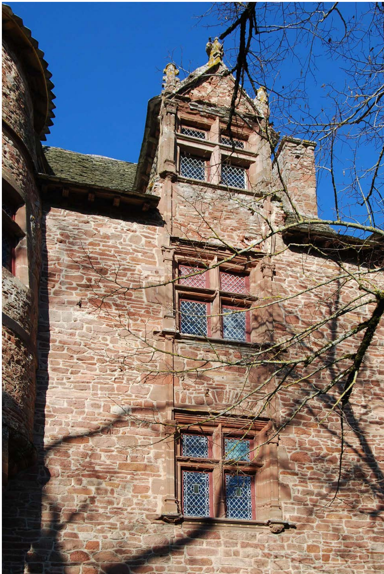
Fig. 29 : Façade sud-est, détail de la 1 ère travée.
