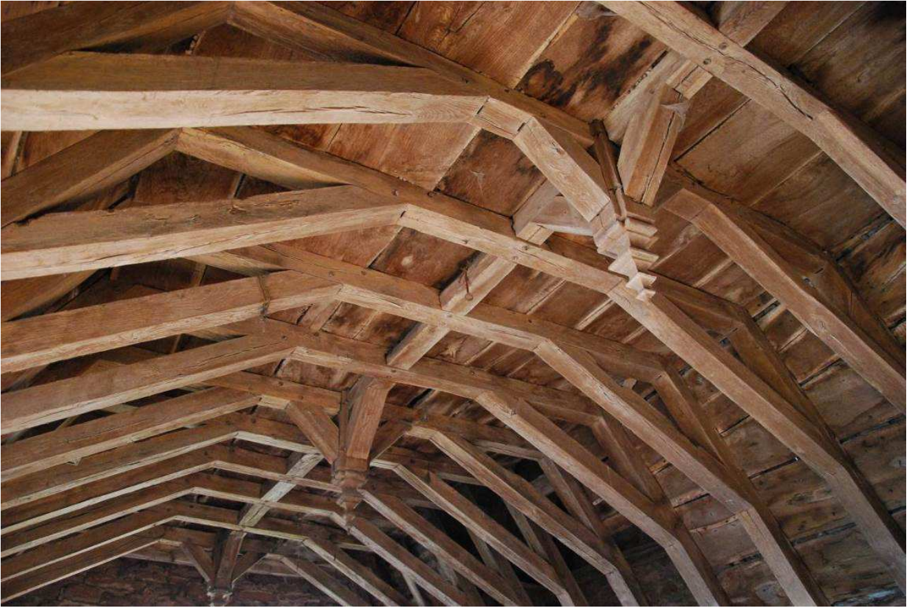
Fig. 79 : Détail de la charpente du comble de l'extension.
