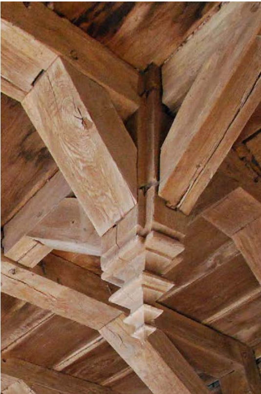
Fig. 80 : Charpente du comble de l'extension, détail d'une clé pendante.
