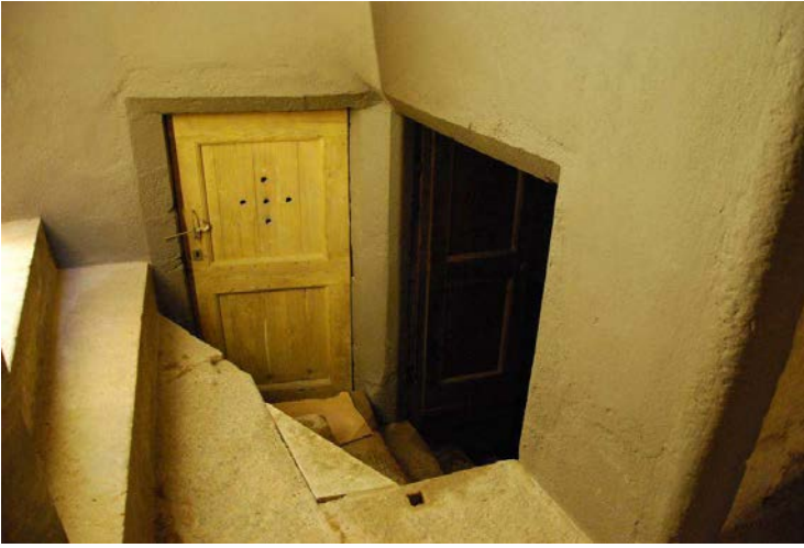
Fig. 48 : Accès au sous-sol depuis l'escalier.
