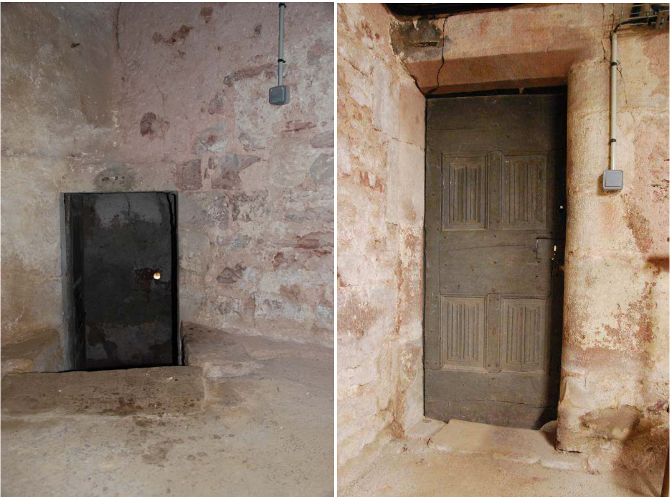
Fig. 55 : Sous-sol, accès à la casemate sud ; Fig. 56 : Sous-sol, mur 3, porte.
