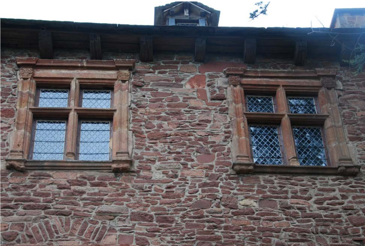
Fig. 26 : Façade sud-est, croisées centrales du 1 er étage et vestige d'une fenêtre.
