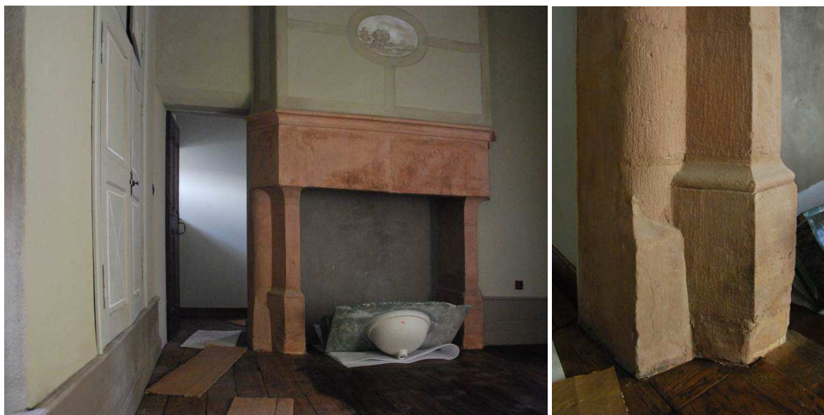
Fig. 69 : Rez-de-chaussée surélevé, pièce D, cheminée et détail d'un piédroit.
