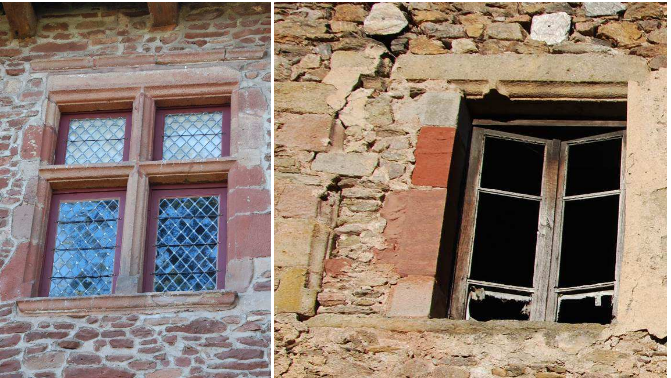
Fig. 17 : Façade nord-est, croisée du 1 er étage ; Fig. 18 : Maison rue de la Briane, le Monastère, détail d'une croisée.
