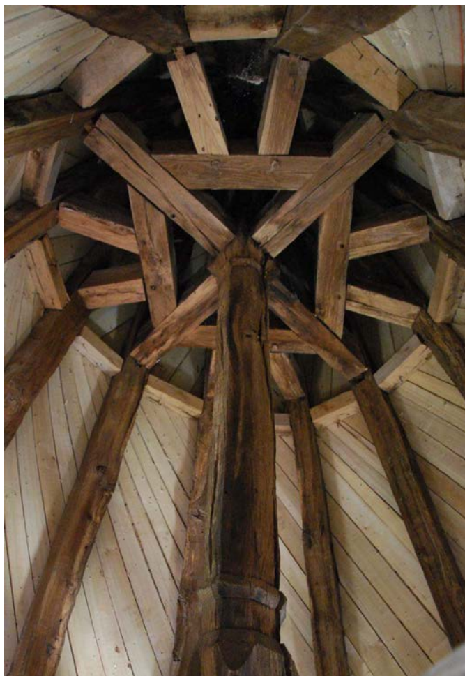
Fig. 81 : Charpente de l'échauguette sud, poinçon et enrayure ; Fig. 82 : Charpente de l'échauguette ouest, détail du poinçon.
