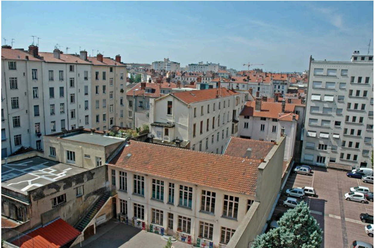
Coeur d'îlot ancien à la hauteur du 103-107 Grande rue de la Guillotière entre les immeubles XXe de la rue de Créqui et 99 Grande rue de la Guillotière
