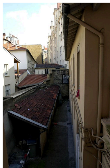
Intérieur du coeur d'îlot grande rue de la Guillotière - Sébastien- Gryphe - Gambetta - Jean-Jaurès depuis le sud : façades postérieures et cour côté avenue Jean-Jaurès Phot. Maryannick Chalabi IVR82_20046904621NUCA
