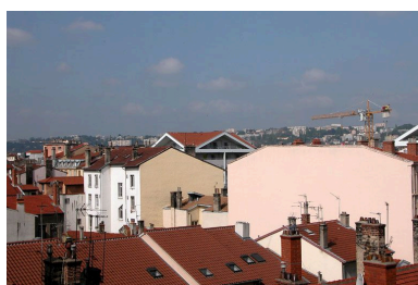
Intérieur du coeur d'îlot remanié Grande rue de la Guillotière - Chalopin - Saint-Michel - Sébastien-Gryphe ; élévations postérieures rue Sébastien-Gryphe depuis un immeuble avenue Jean-Jaurès au nord-est Phot. Maryannick Chalabi IVR82_20046904579NUCA
