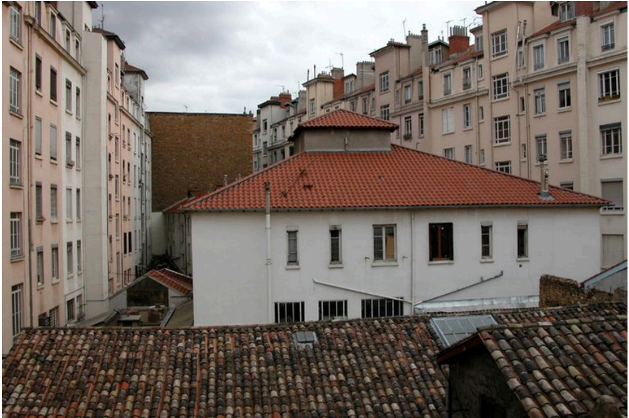
Intérieur de l'îlot grande rue de la Guillotière - rue Sébastien-Gryphe - cours Gambetta - avenue Jean-Jaurès
