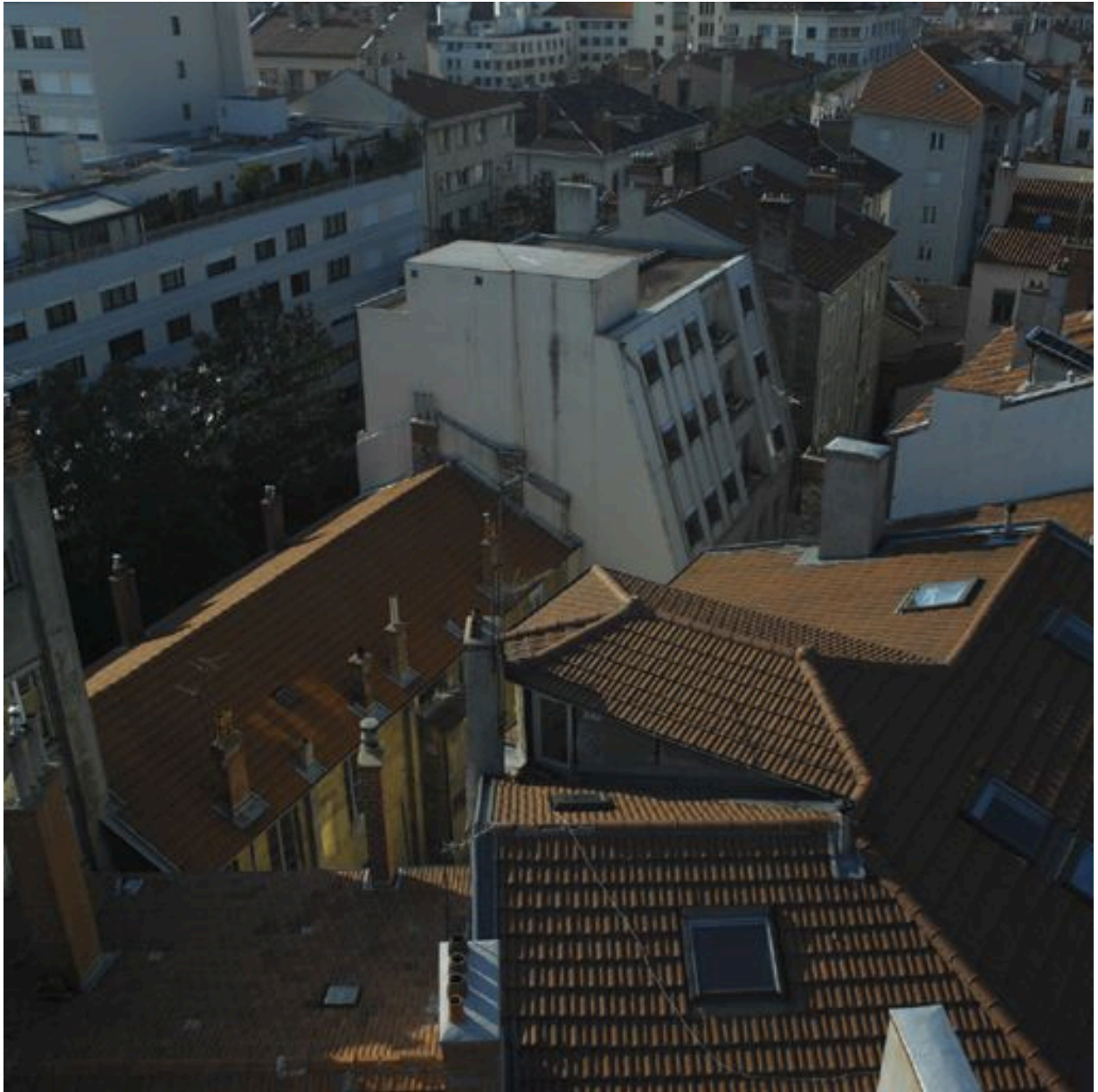
Vue du coeur de l'îlot à l'ouest de la rue de la Madeleine
