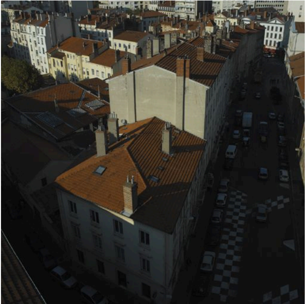
Vue d'ensemble de l'îlot Madeleine-Montesquieu-Saint-Michel depuis le sud
