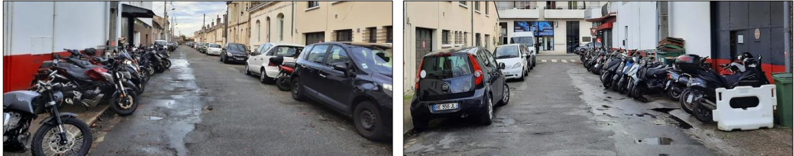
La rue n'est pas en bon état. Le trottoir est très encombré par les motos du garage situé à l'angle (photo CE)
