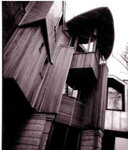
Fig.9 Maison Herbecq, façade à rue, rue des Anglais, architecte Bernard Herbecq, Liège, 1991. © Jean-Jacques Symul.
