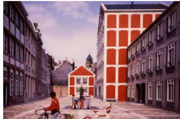
Fig. 5 Cour Saint-Antoine, architecte Charles Vandenhove, Liège, 1984. © Y. Futagawa
