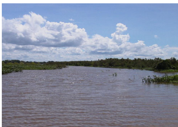
Parte de la carretera inundada (Cerca de Puerto Ganadero)
