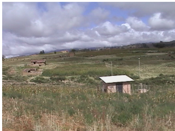
Cuarto de bomba-administrado por un grupo de residentes (suburbios de Sucre)
