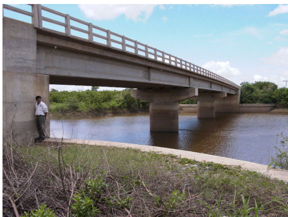
Sitio en construcción 1 (Puente Okinawa Payrón. Sin problemas funcionales las marcas de inundaciones son menores que lo planeado en el HWL)
