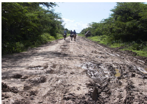
Superficie de la carretera actual (en época de lluvias)
