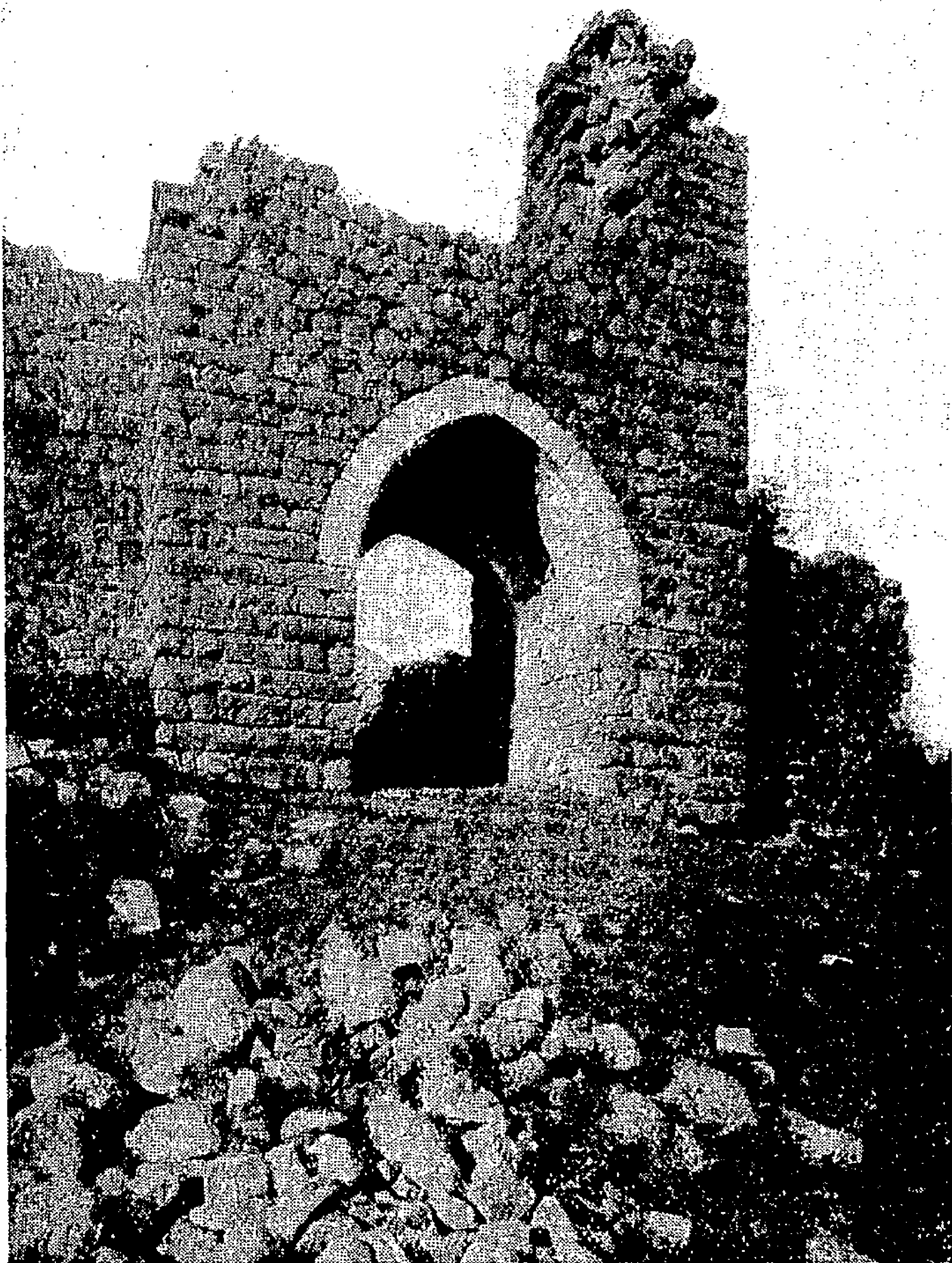
Ce qui reste de la porte principale du Château de Chapeuil-en-Velay .
