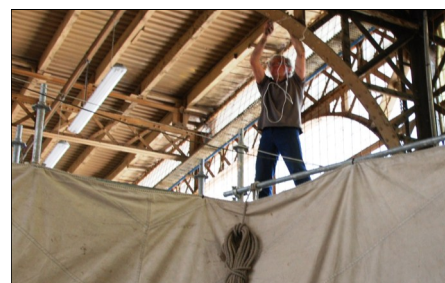
Gilbert fixe le foc à la charpente
