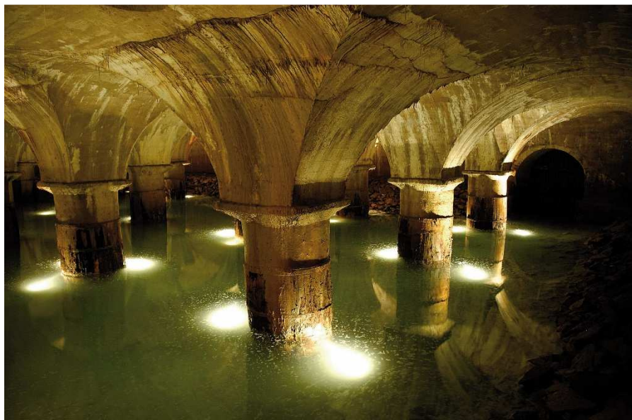
[Photo 66/Bassin filtrant de l'usine de Saint-Clair. Cliché « Eau à Lyon »]
