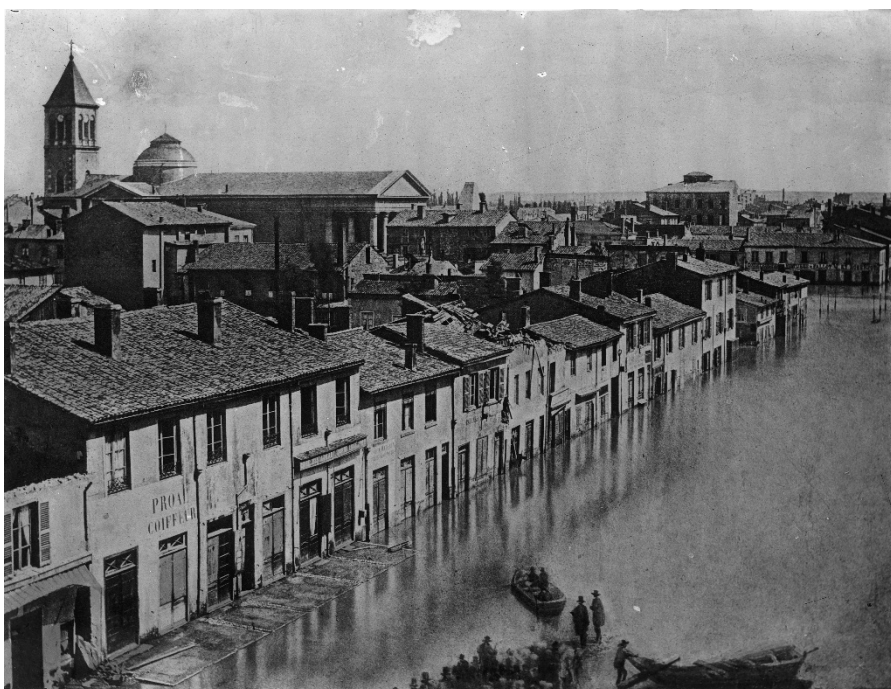
[Photo 64/Inondation de 1856, avenue de Saxe, par Louis Froissart © AC Lyon, 3PH00597],
