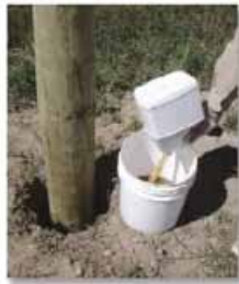
Pour Part B container into Part A container
