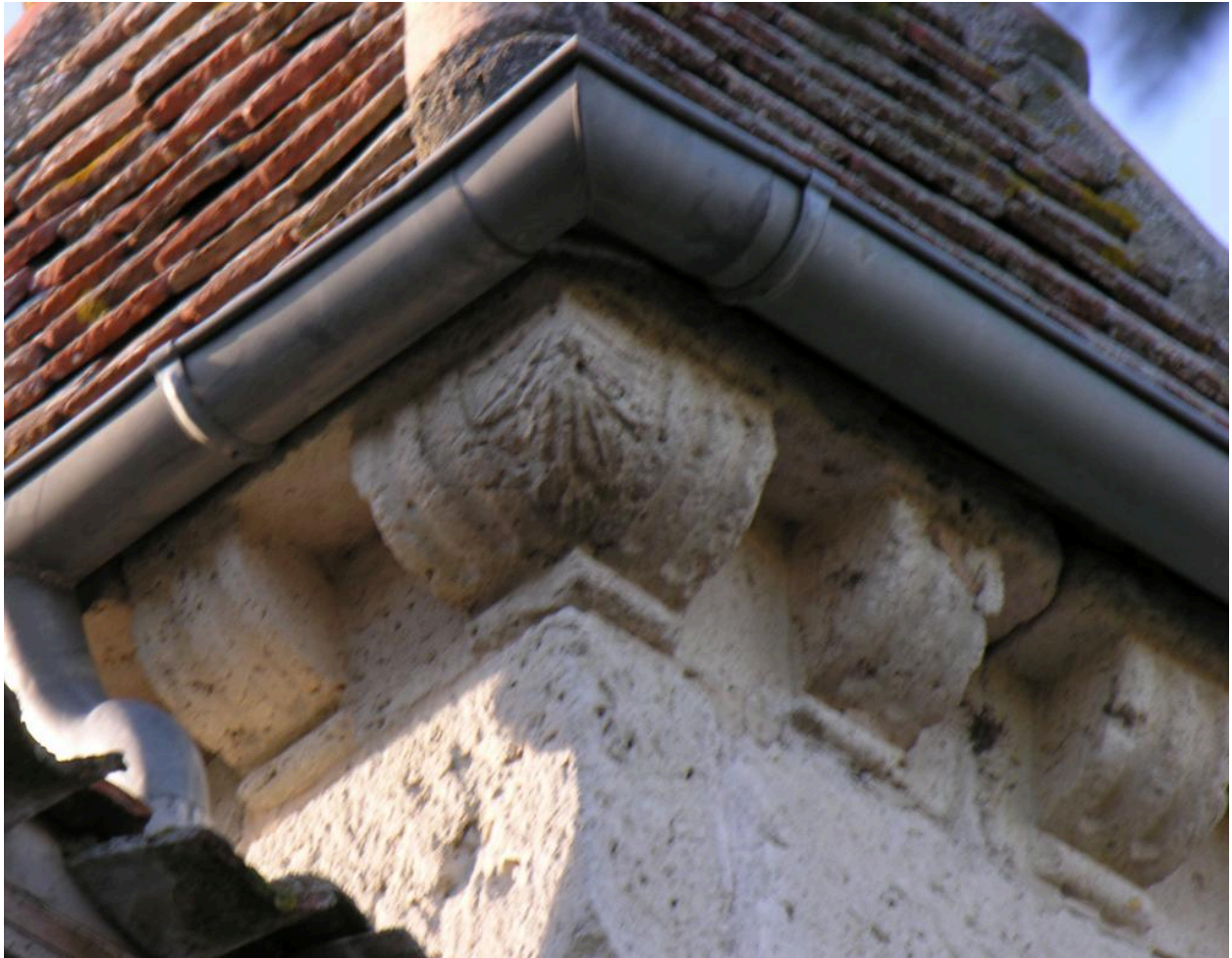
Logis : corniche de la tourelle d'angle.
