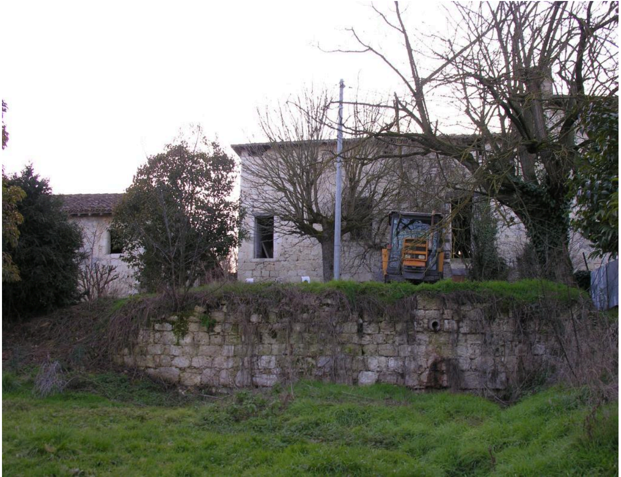
Vestiges du côté Est de l'enceinte.
