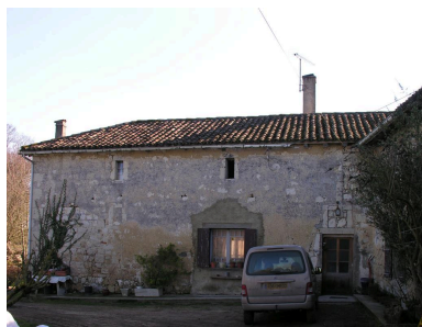
Bâtiment sud (vue nord de l'aile sud). Phot. Gaëlle Prost IVC32208_20103200526NUCA
