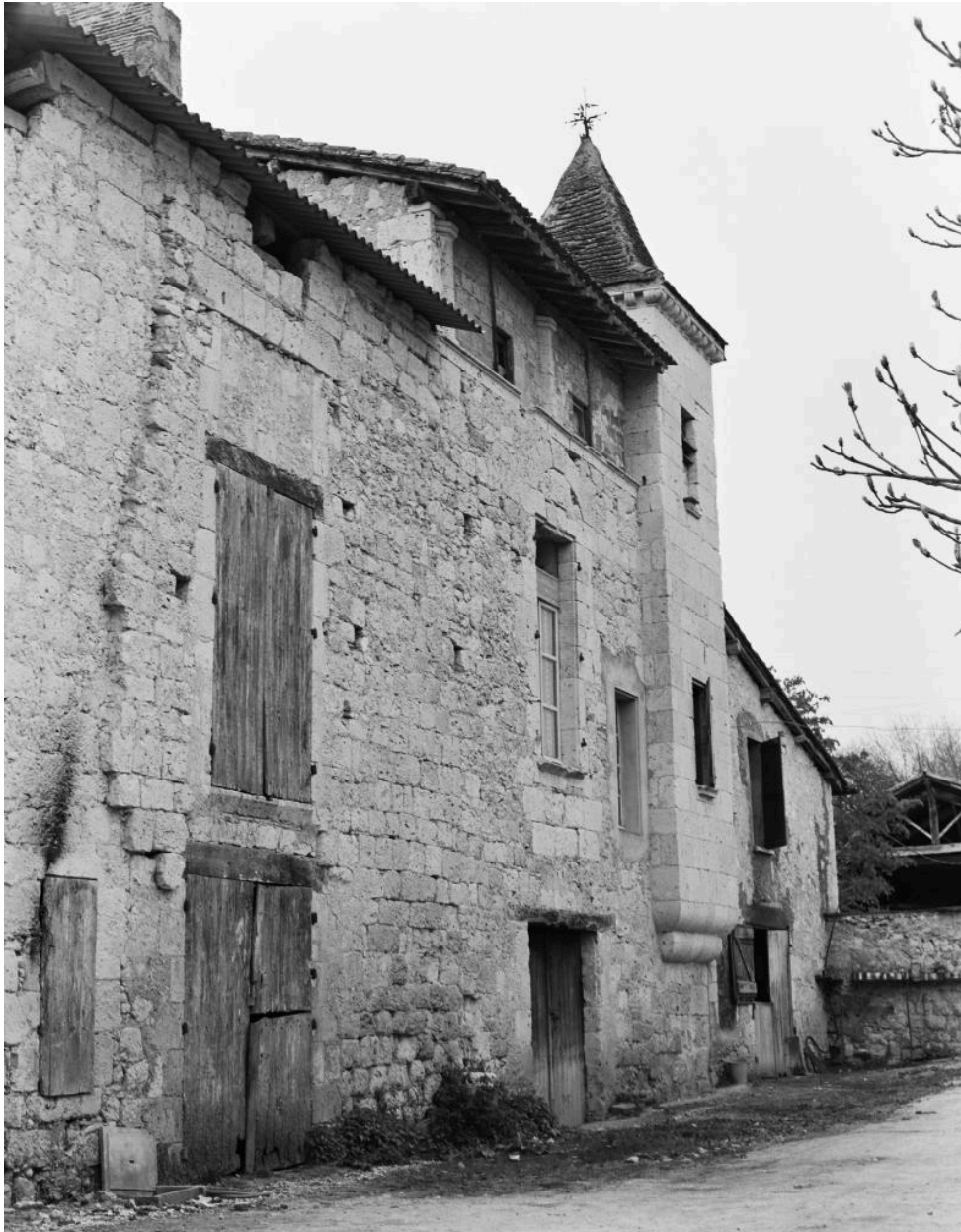
Elévation antérieure de 3/4 gauche.
