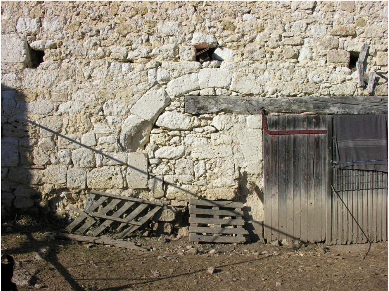
Logis : détail de la porte du mur sud.
