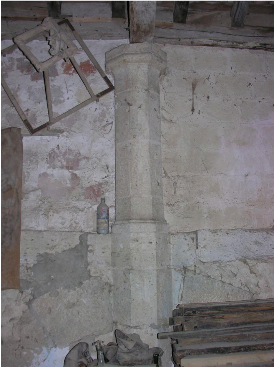
Un pilier de la galerie, vu de l'intérieur.
