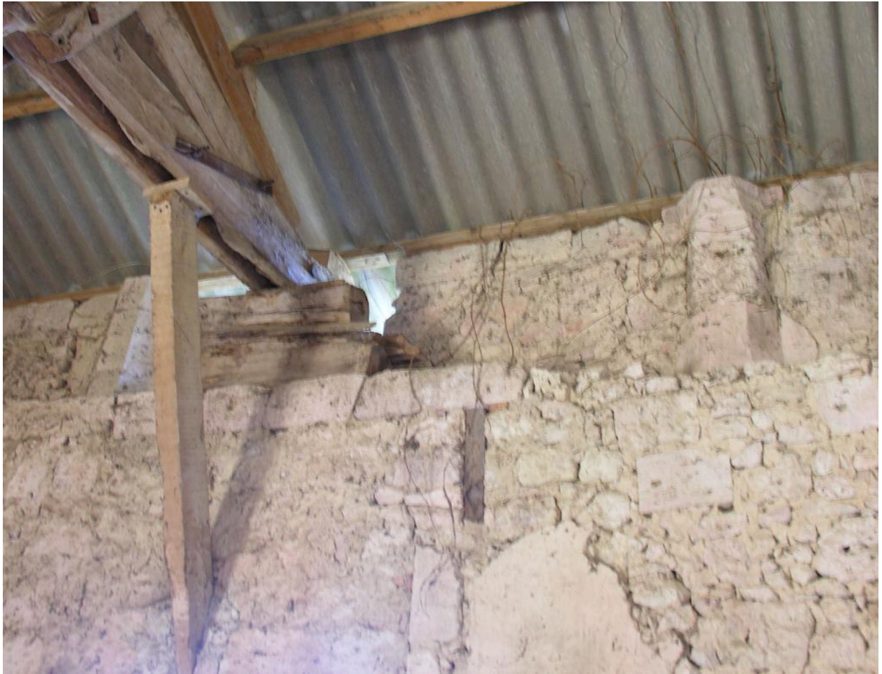
Logis : les deux piliers tronqués de la galerie vus de l'intérieur.
