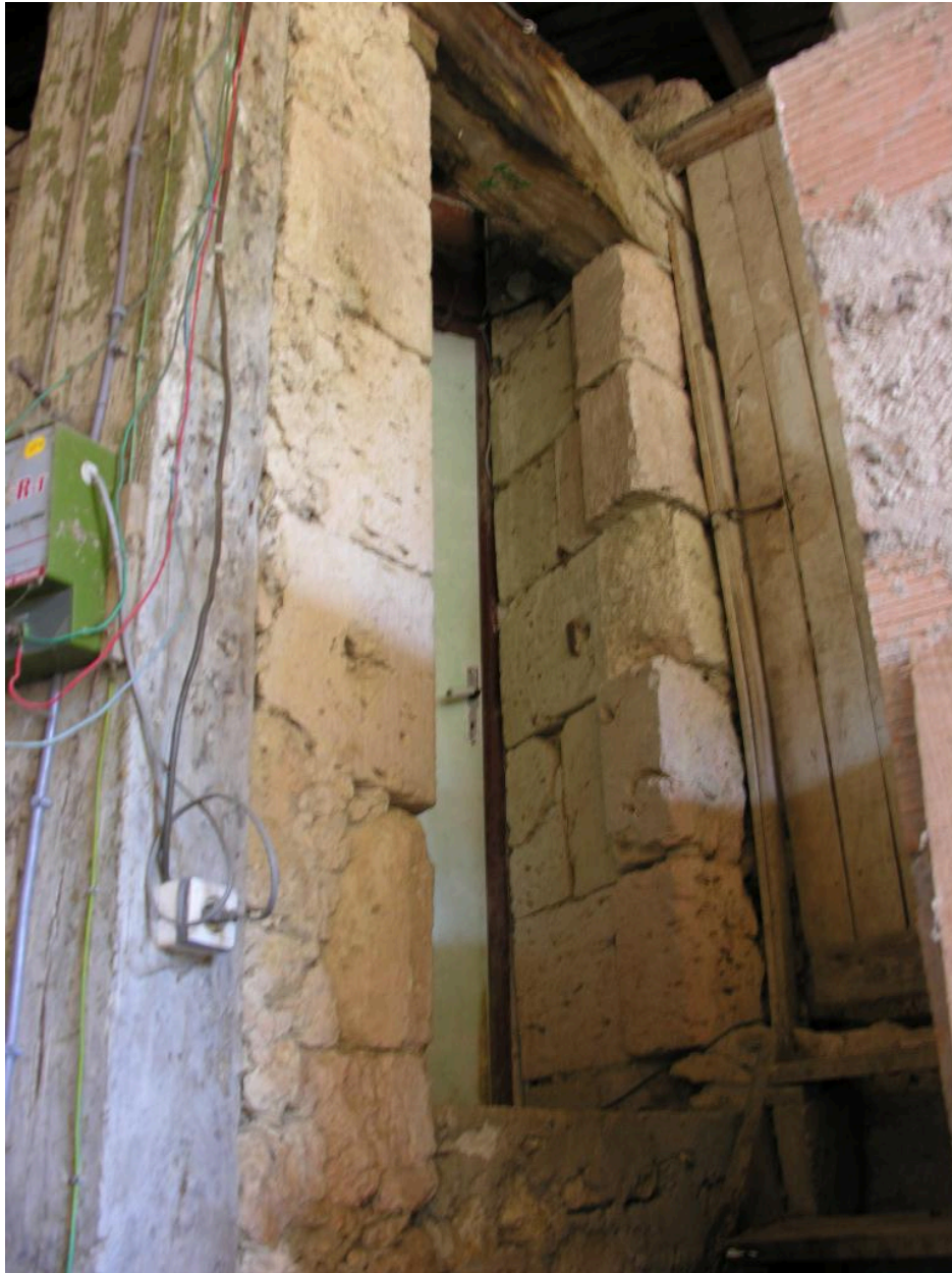
Bâtiment sud : porte sud de l'aile nord.
