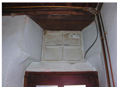
Bâtiment sud : porte de l'aile sud (intérieur). Phot. Gaëlle Prost IVC32208_20103200551NUCA
