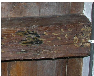
Bâtiment sud : solive peinte. Phot. Gaëlle Prost IVC32208_20103200537NUCA
