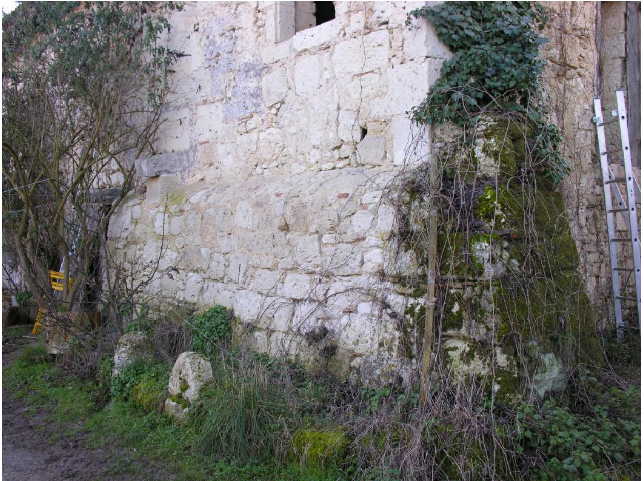
Bâtiment sud : angle nord-est de l'aile nord.
