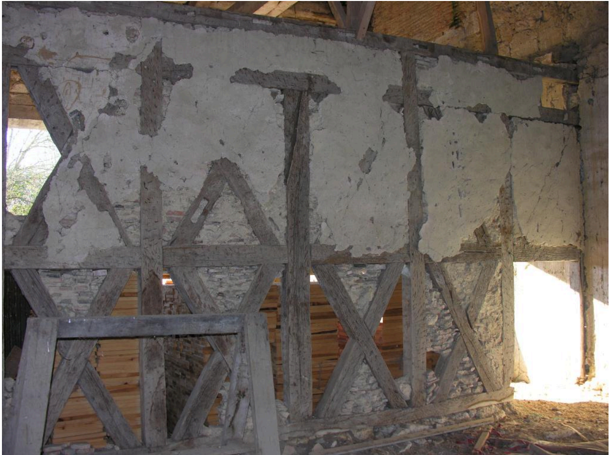
Logis : cloison de l'étage.
