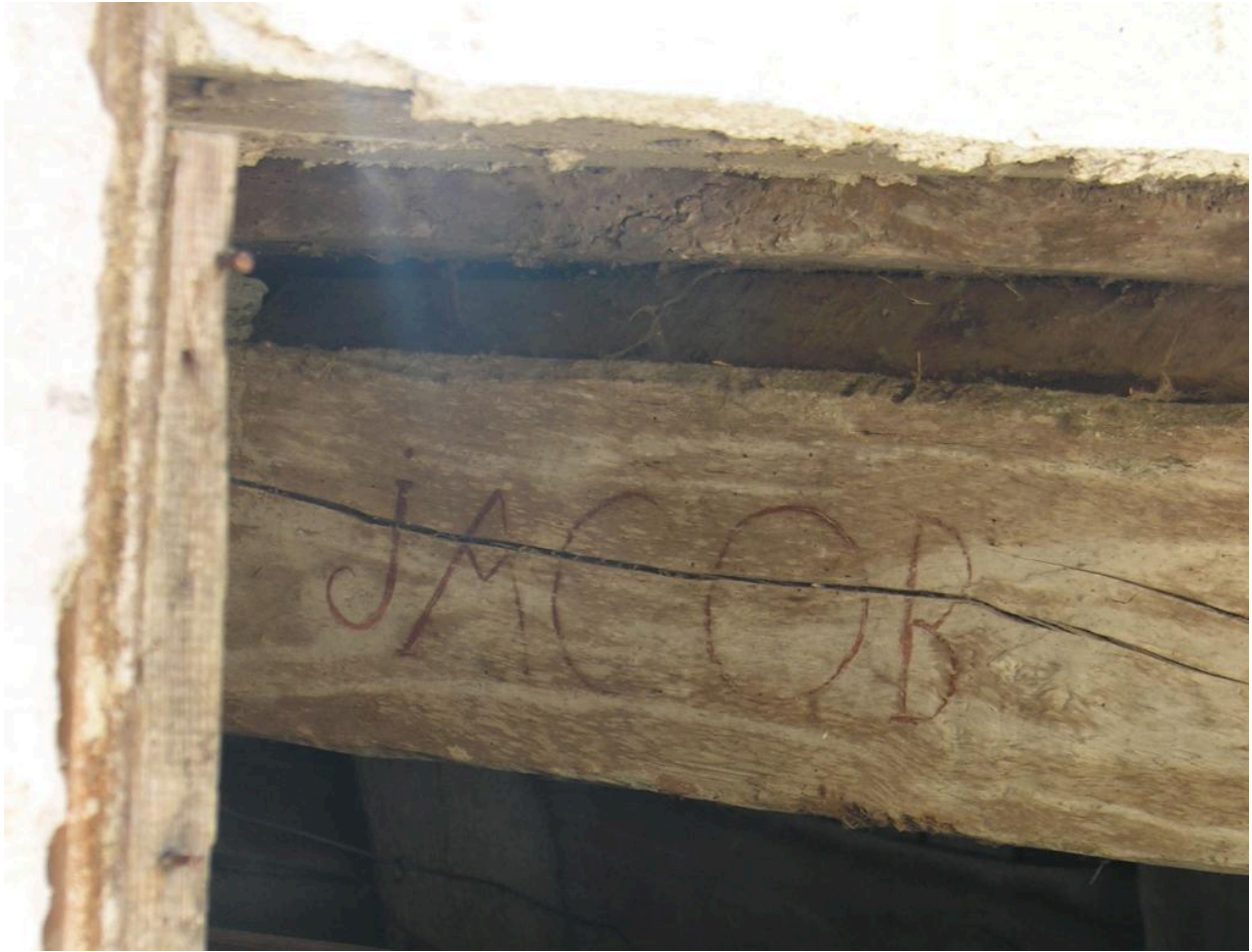
Bâtiment sud : poutre de l'extension de 1775 portant l'inscription « JACOB ».
