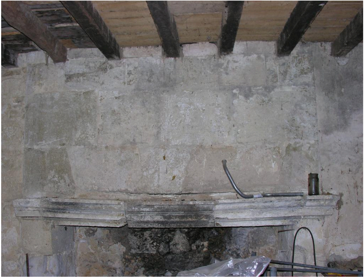
Logis : cheminée du quart sud-est du rez-de-chaussée.
