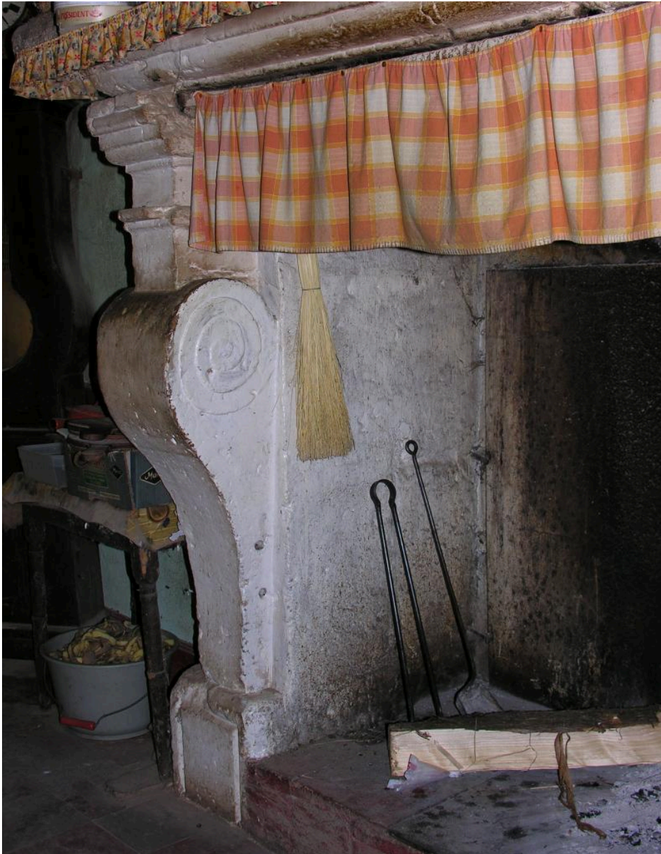
Logis : cheminée nord de l'étage.
