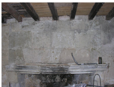
Logis : cheminée du quart sud-est du rez-de-chaussée. Phot. Gaëlle Prost IVC32208_20103200548NUCA
