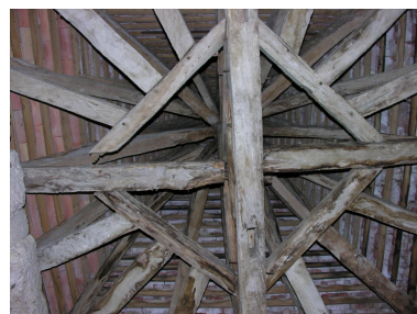
Logis : enrayure de la tour d'angle nord-est. Phot. Gaëlle Prost IVC32208_20103200535NUCA
