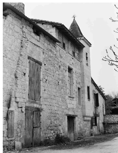
Elévation antérieure de 3/4 gauche. Phot. Bernard Loncan IVR73_19793200066X
