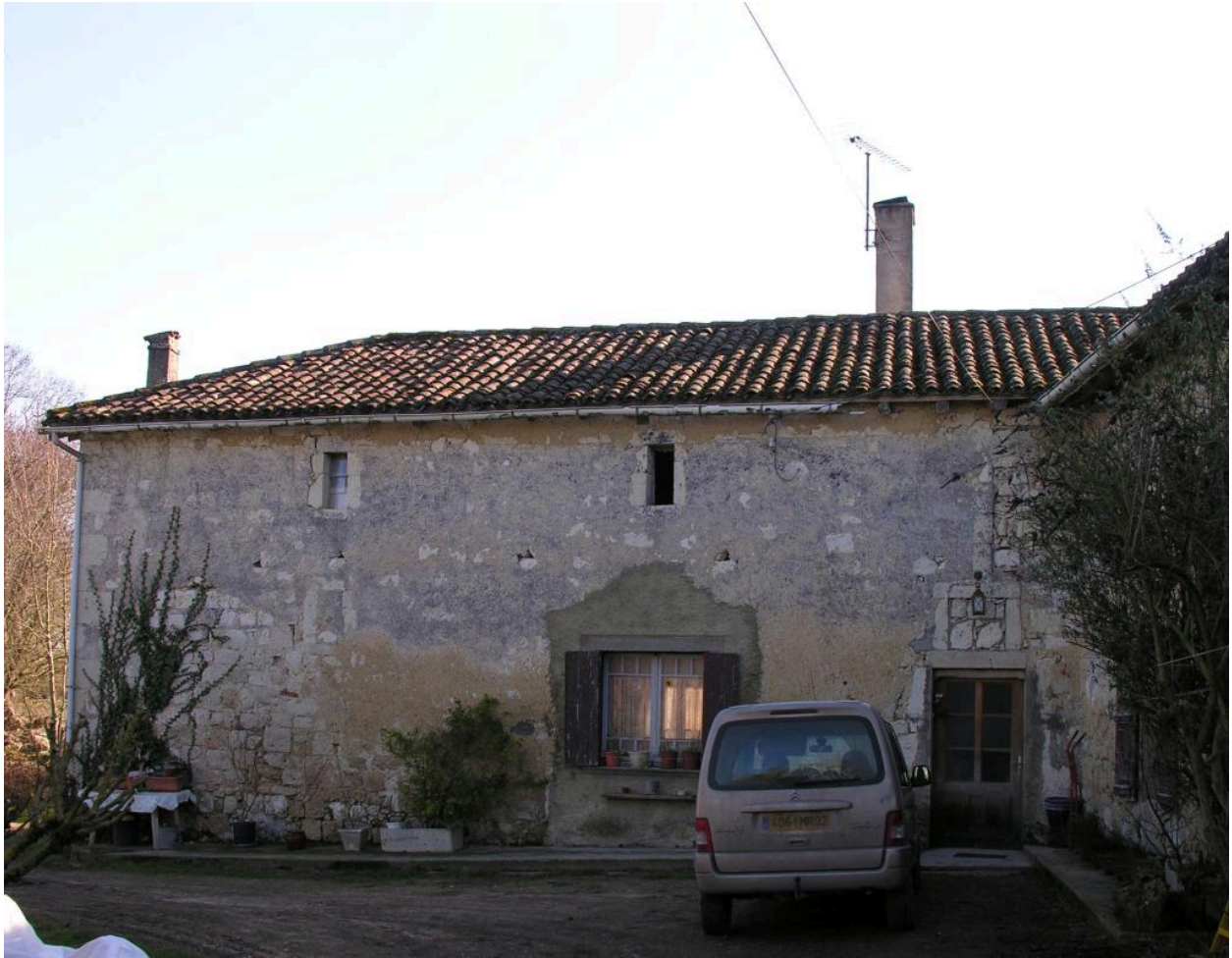
Bâtiment sud (vue nord de l'aile sud).
