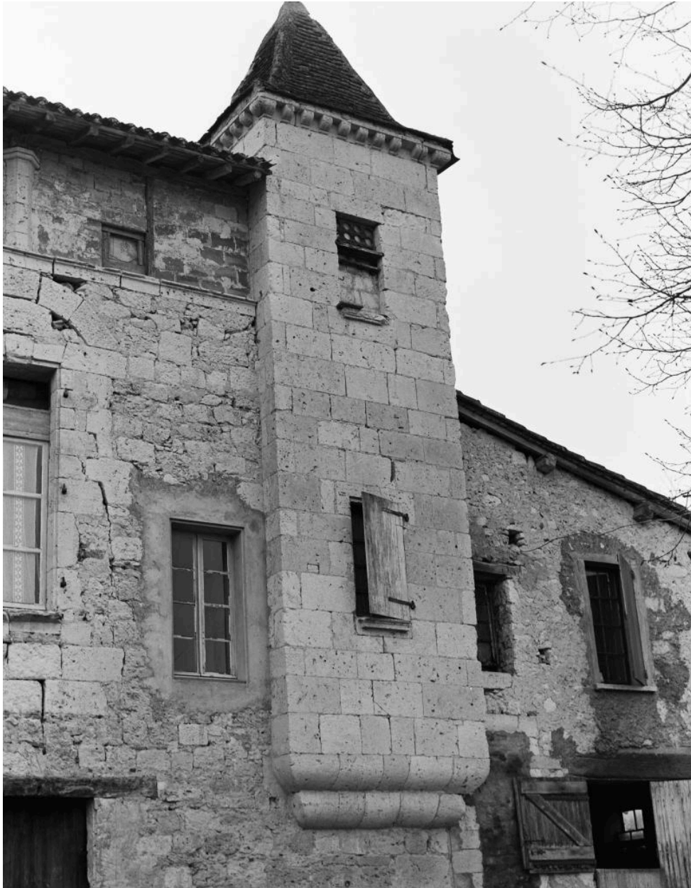
Elévation antérieure, détail : échauguette.
