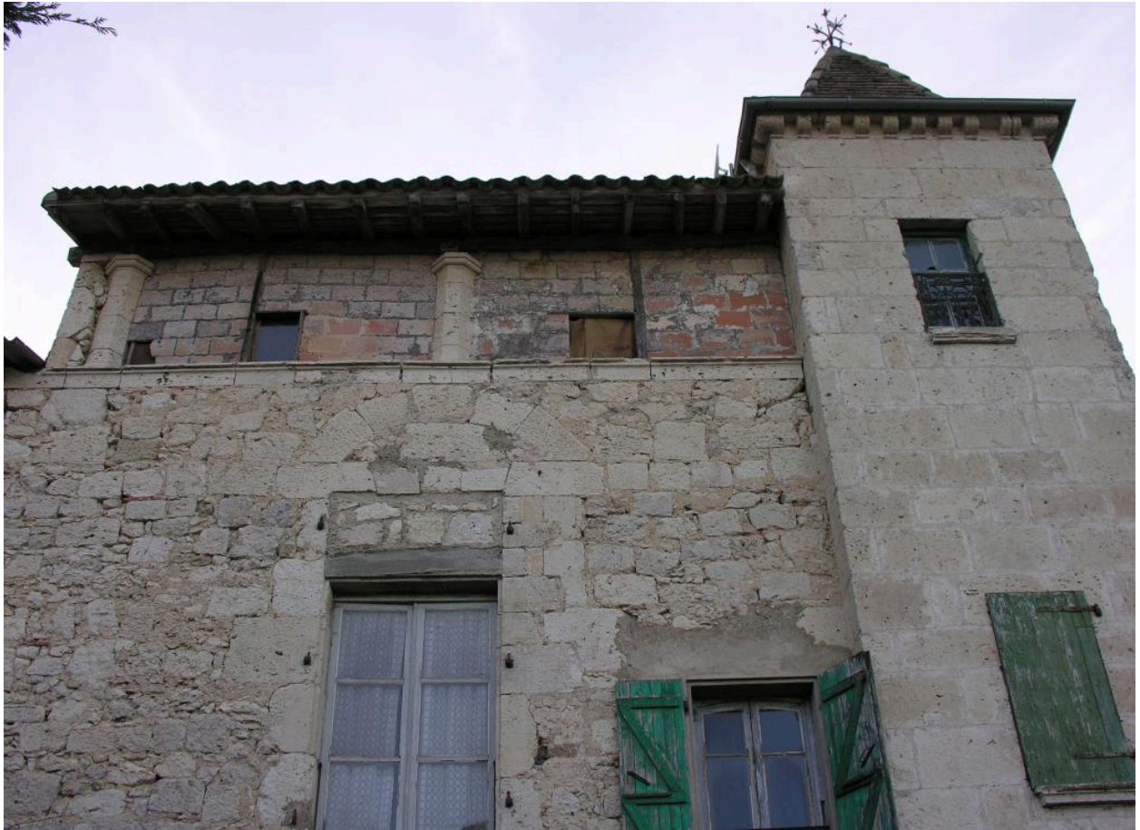
Façade du logis (moitié nord).
