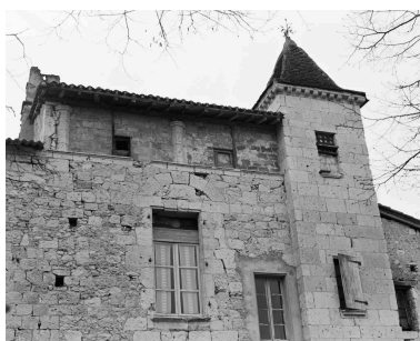
Élévation antérieure, partie supérieure. Phot. Bernard Loncan IVR73_19793200068X
