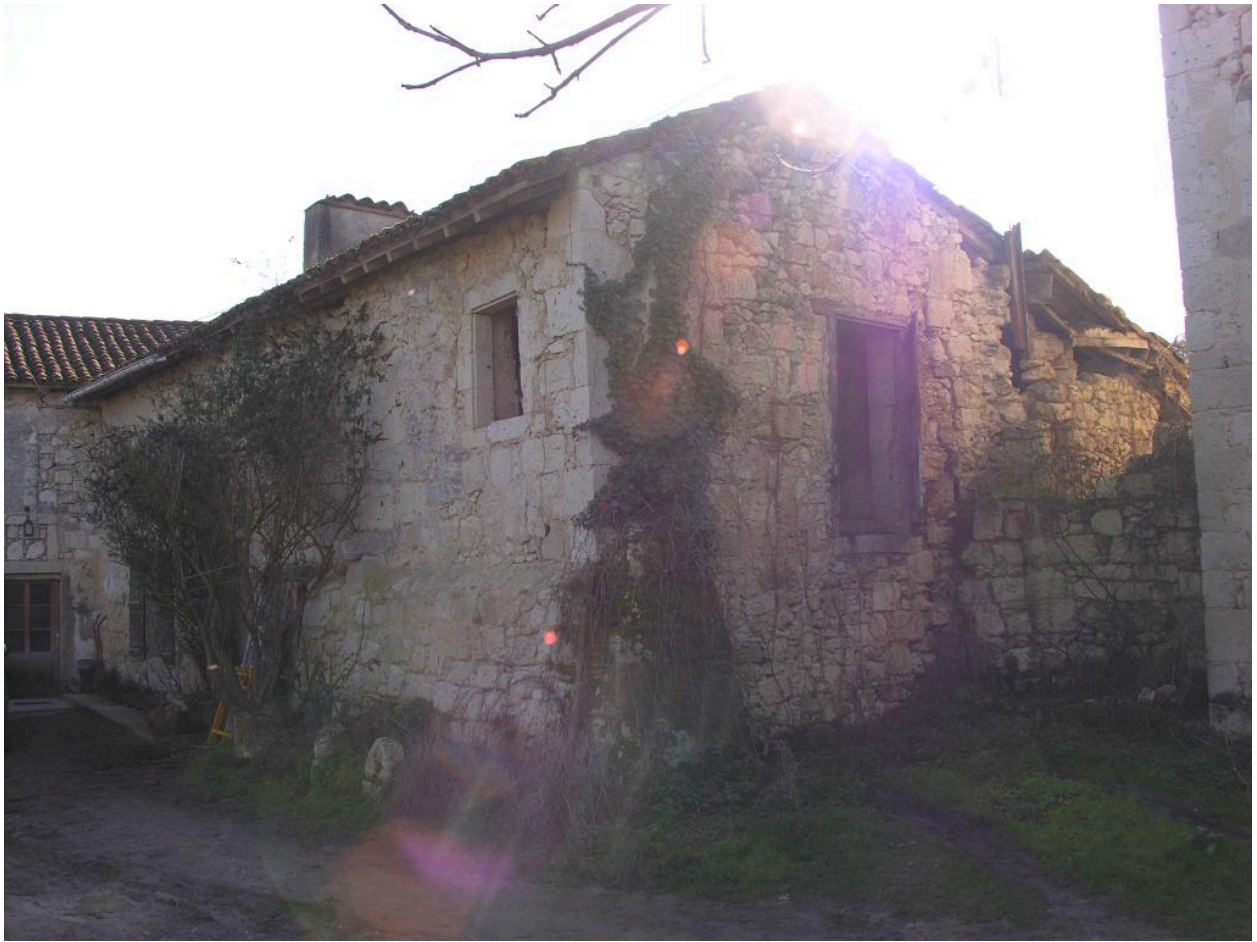
Bâtiment sud (vue nord-est de l'aile nord).
