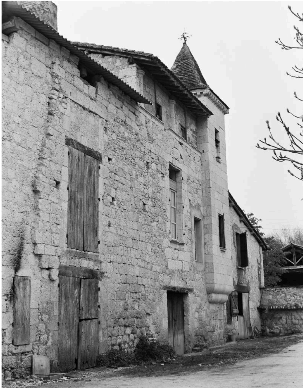
Elévation antérieure de 3/4 gauche.
