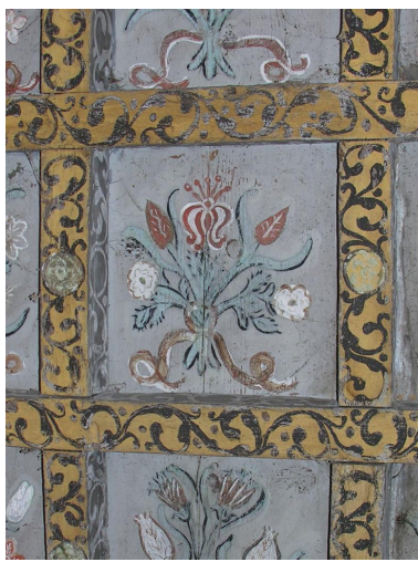
Logis : détail du plafond à caissons de la tourelle d'angle. Phot. Gaëlle Prost IVC32208_20103200543NUCA
