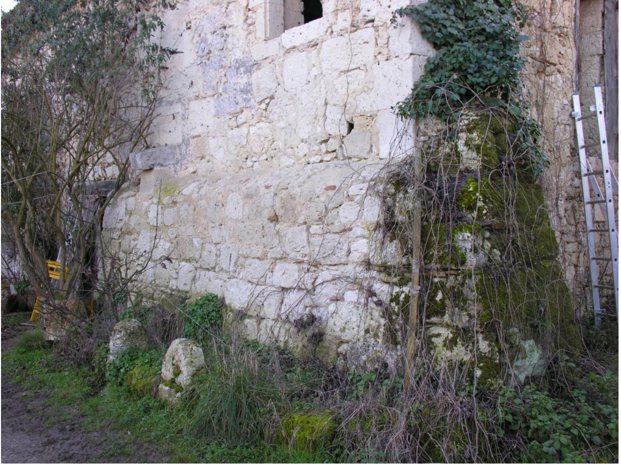
Bâtiment sud : angle nord-est de l'aile nord.
