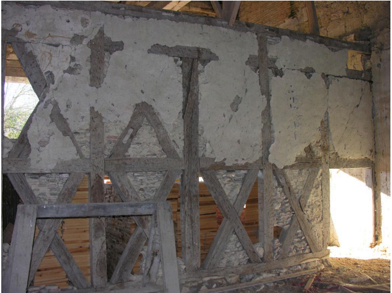
Logis : cloison de l'étage.
