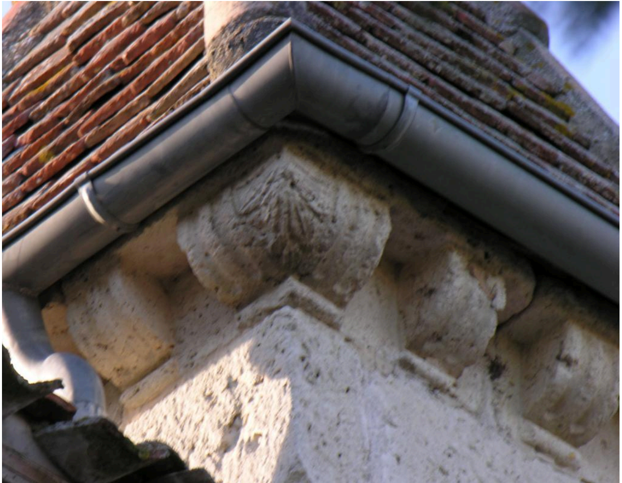
Logis : corniche de la tourelle d'angle.
