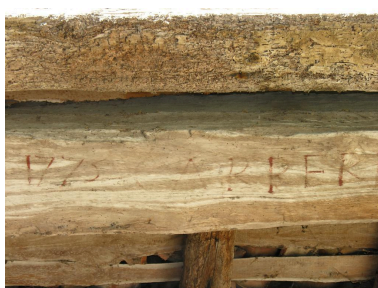
Bâtiment sud : poutre de l'extension de 1775 portant l'inscription « 1775 CARPERI ». Phot. Gaëlle Prost IVC32208_20103200556NUCA
