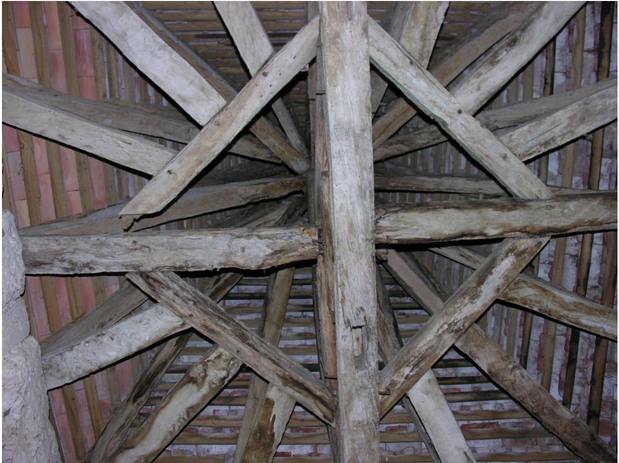
Logis : enrayure de la tour d'angle nord-est.
