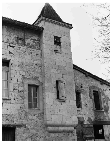
Elévation antérieure, détail : échauguette. Phot. Bernard Loncan IVR73_19793200067X
