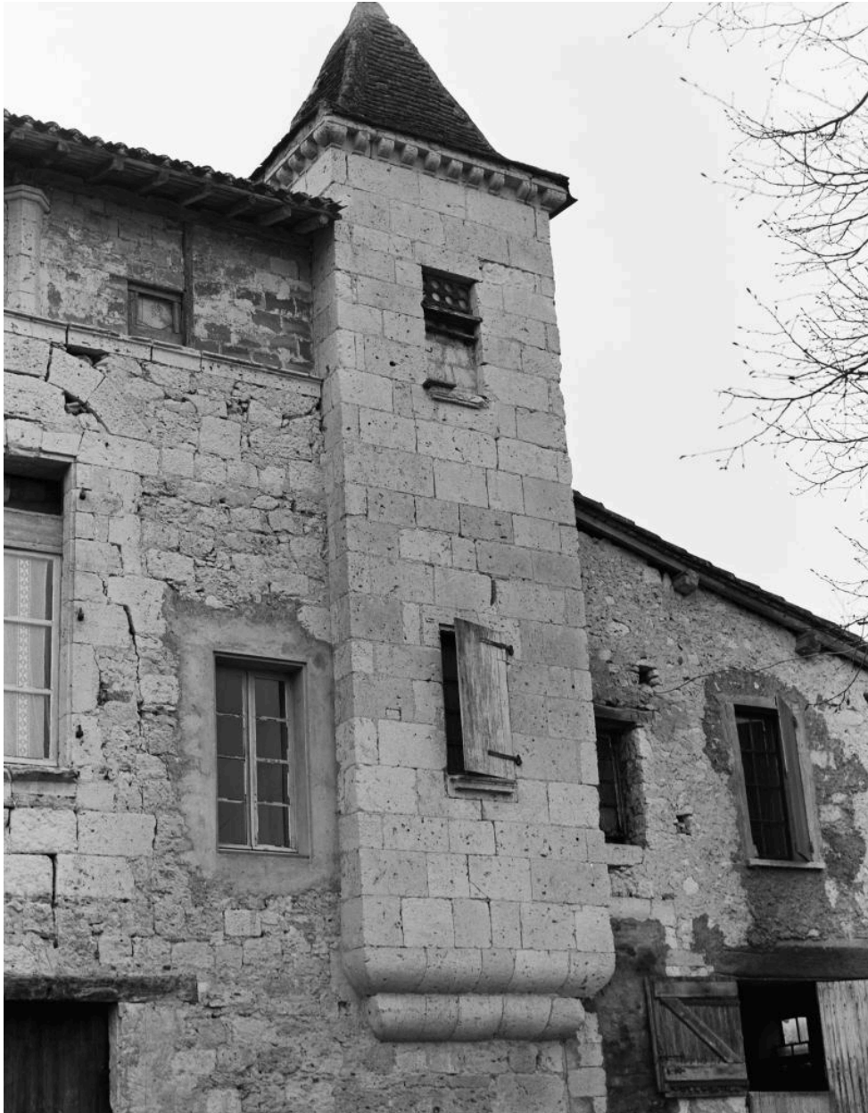
Elévation antérieure, détail : échauguette.
