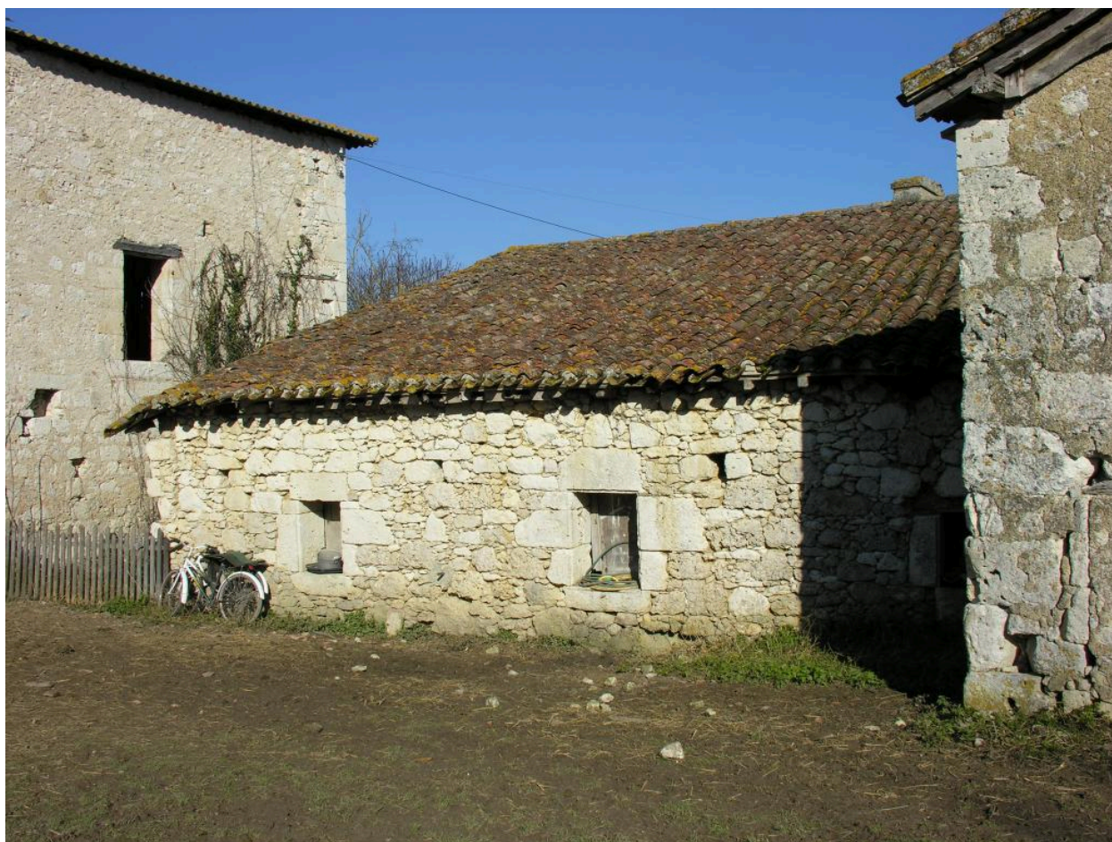
Bâtiment sud : extension de l'aile nord renfermant un four.
