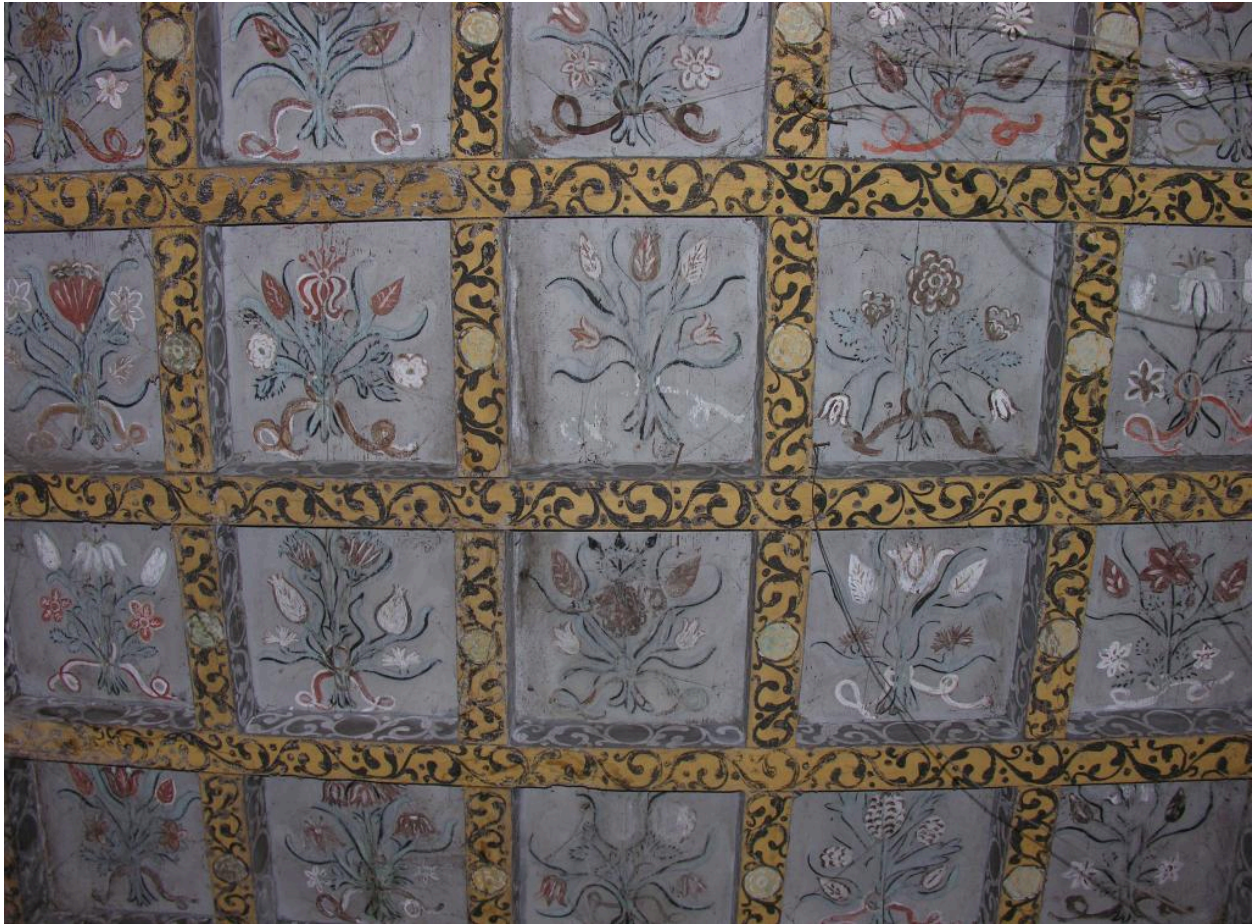
Logis : plafond peint de la tour d'angle nord-est.
