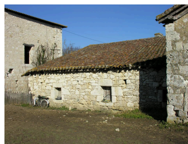
Bâtiment sud : extension de l'aile nord renfermant un four. Phot. Gaëlle Prost IVC32208_20103200557NUCA
