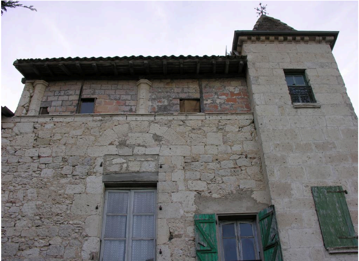
Façade du logis (moitié nord).
