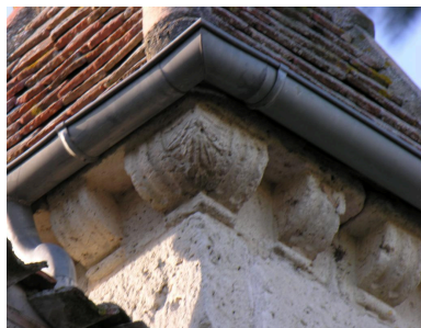
Logis : corniche de la tourelle d'angle. Phot. Gaëlle Prost IVC32208_20103200542NUCA
