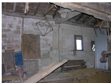
Logis : galerie vue de l'intérieur. Phot. Gaëlle Prost IVC32208_20103200544NUCA
