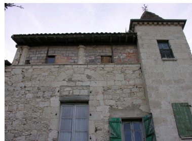
Façade du logis (moitié nord). Phot. Gaëlle Prost IVC32208_20103200528NUCA
