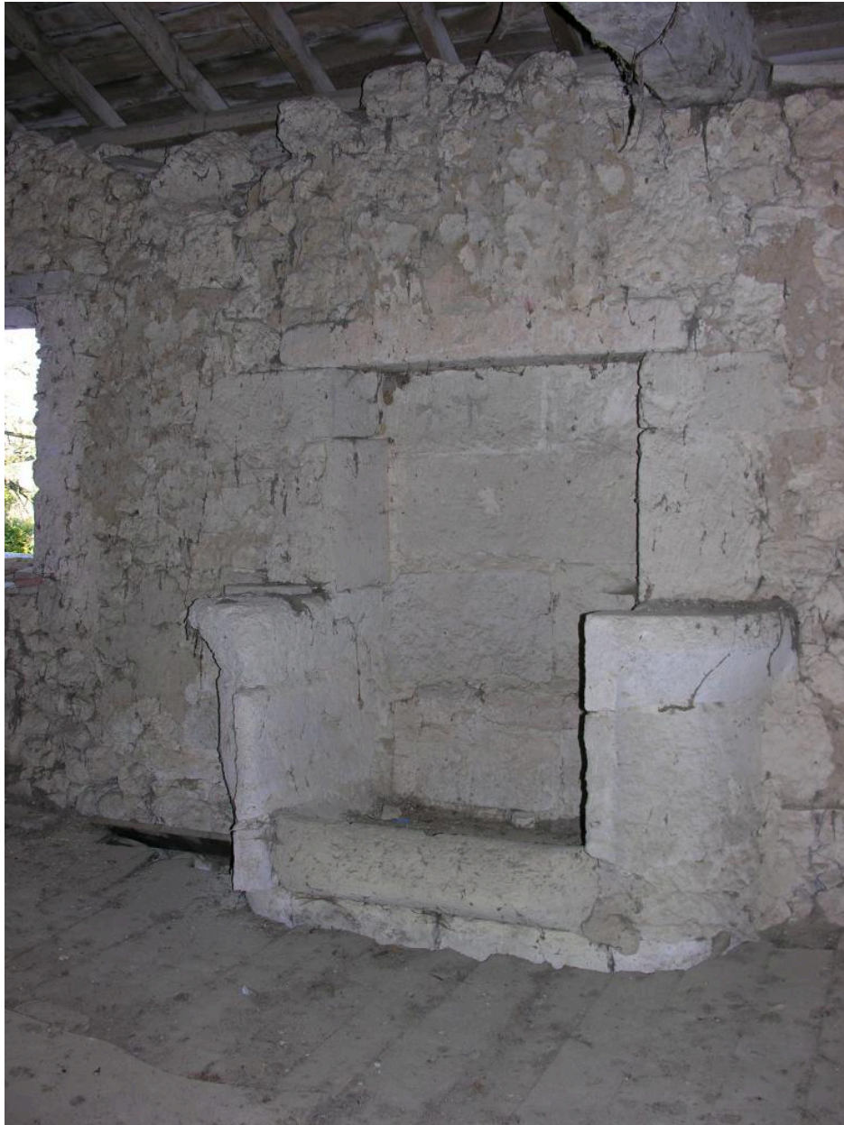
Bâtiment sud : évier de l'étage.
