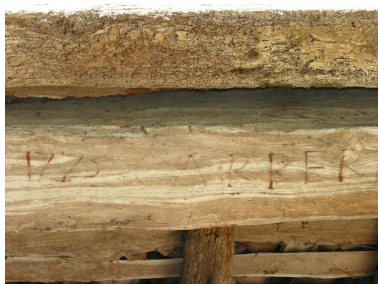
Bâtiment sud : poutre de l'extension de 1775 portant l'inscription « 1775 CARPERI ». Phot. Gaëlle Prost IVC32208_20103200556NUCA
