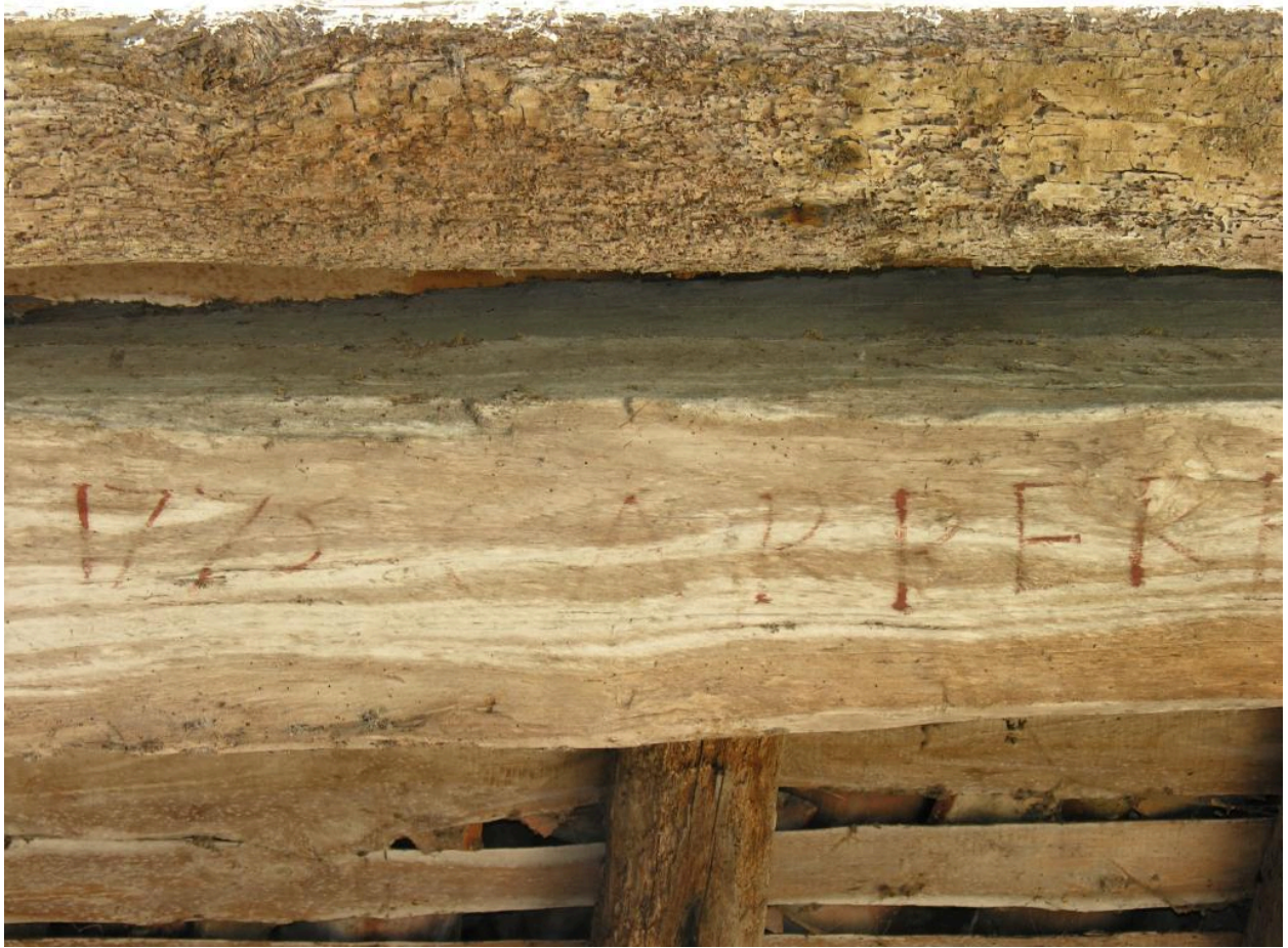
Bâtiment sud : poutre de l'extension de 1775 portant l'inscription « 1775 CARPERI ».
