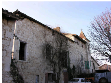
Façade du logis (vue sud-est). Phot. Gaëlle Prost IVC32208_20103200523NUCA
