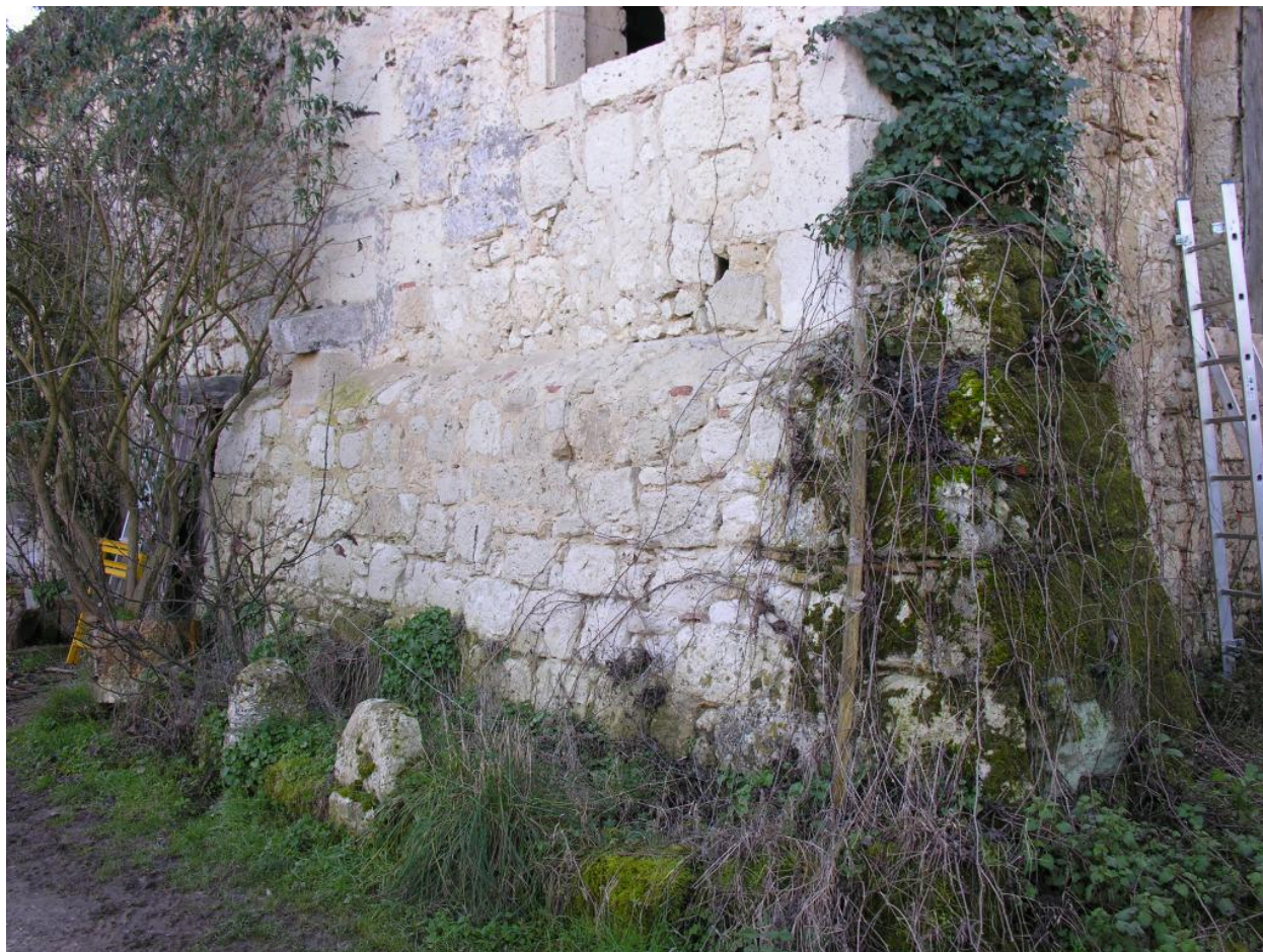
Bâtiment sud : angle nord-est de l'aile nord.
