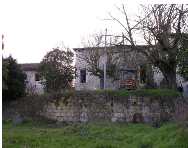
Vestiges du côté Est de l'enceinte. Phot. Gaëlle Prost IVC32208_20103200527NUCA
