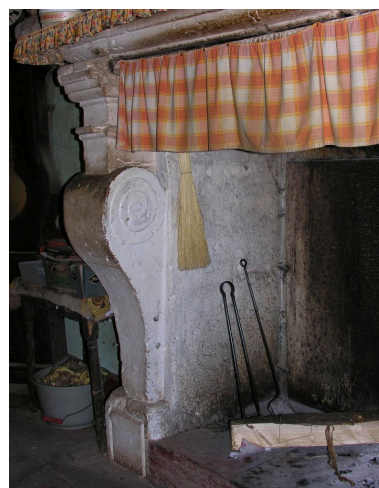
Logis : cheminée nord de l'étage. Phot. Gaëlle Prost IVC32208_20103200532NUCA
