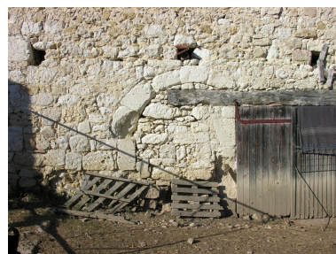
Logis : détail de la porte du mur sud. Phot. Gaëlle Prost IVC32208_20103200546NUCA
