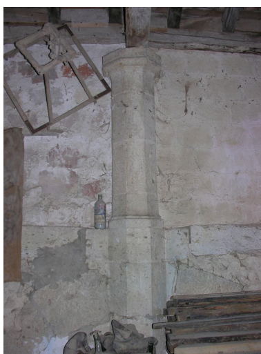
Un pilier de la galerie, vu de l'intérieur. Phot. Gaëlle Prost IVC32208_20103200529NUCA
