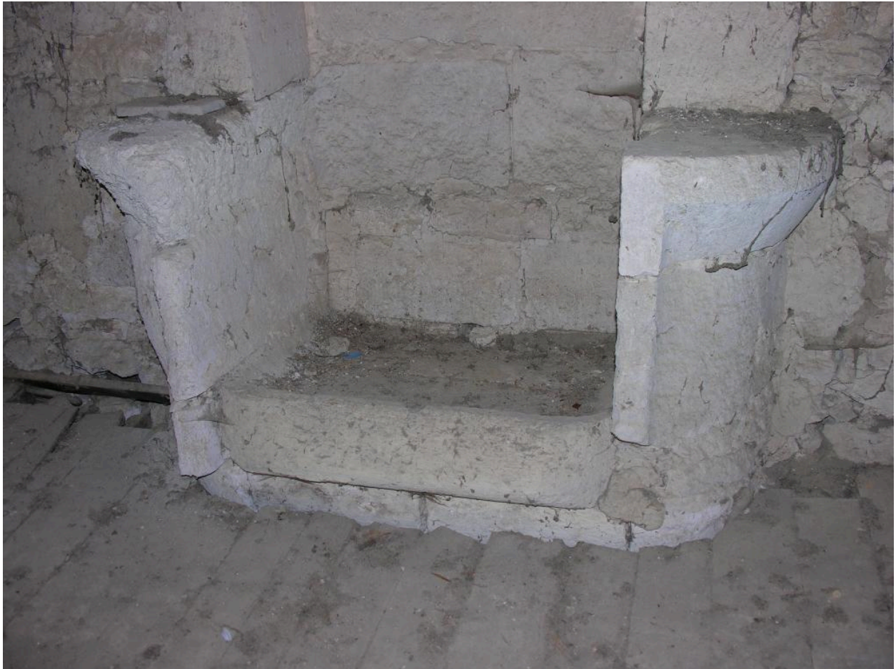
Bâtiment sud : évier de l'étage.
