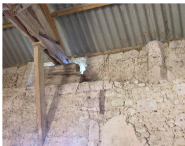
Logis : les deux piliers tronqués de la galerie vus de l'intérieur. Phot. Gaëlle Prost IVC32208_20103200545NUCA
