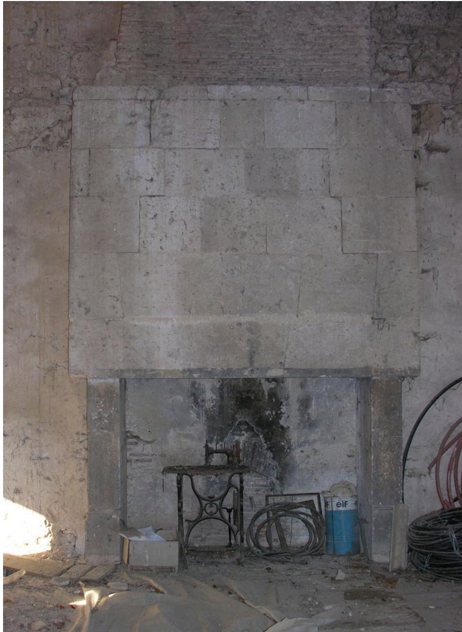
Logis : cheminée sud de l'étage.
