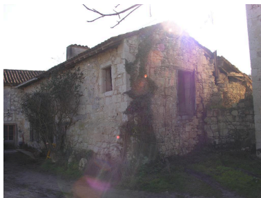
Bâtiment sud (vue nord-est de l'aile nord). Phot. Gaëlle Prost IVC32208_20103200525NUCA
