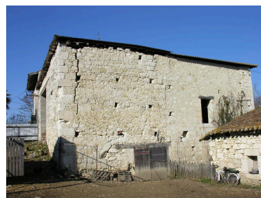
Logis : élévation sud. Phot. Gaëlle Prost IVC32208_20103200524NUCA
