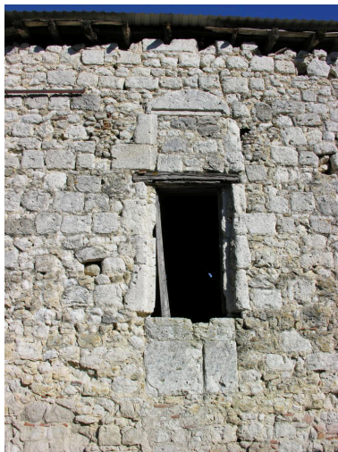
Logis : demi-croisée du mur ouest. Phot. Gaëlle Prost IVC32208_20103200547NUCA
