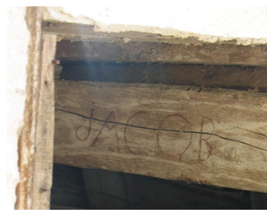
Bâtiment sud : poutre de l'extension de 1775 portant l'inscription « JACOB ». Phot. Gaëlle Prost IVC32208_20103200555NUCA
