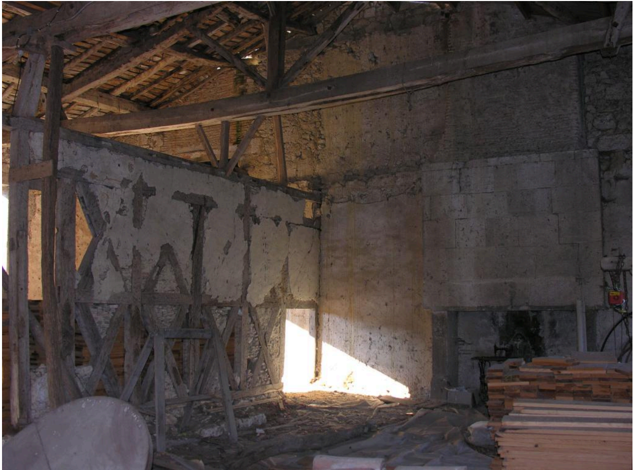
Logis : salle sud-est de l'étage.
