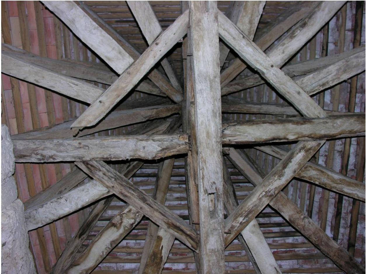
Logis : enrayure de la tour d'angle nord-est.
