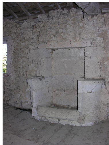
Bâtiment sud : évier de l'étage. Phot. Gaëlle Prost IVC32208_20103200538NUCA
