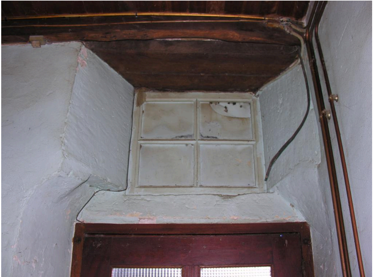
Bâtiment sud : porte de l'aile sud (intérieur).
