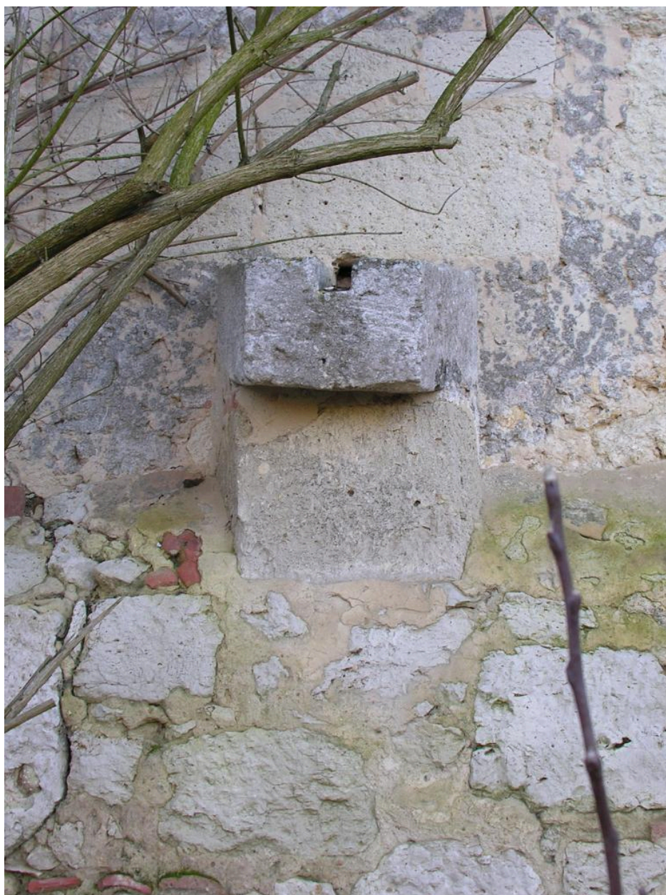
Bâtiment sud : écoulement de l'évier de l'étage.
