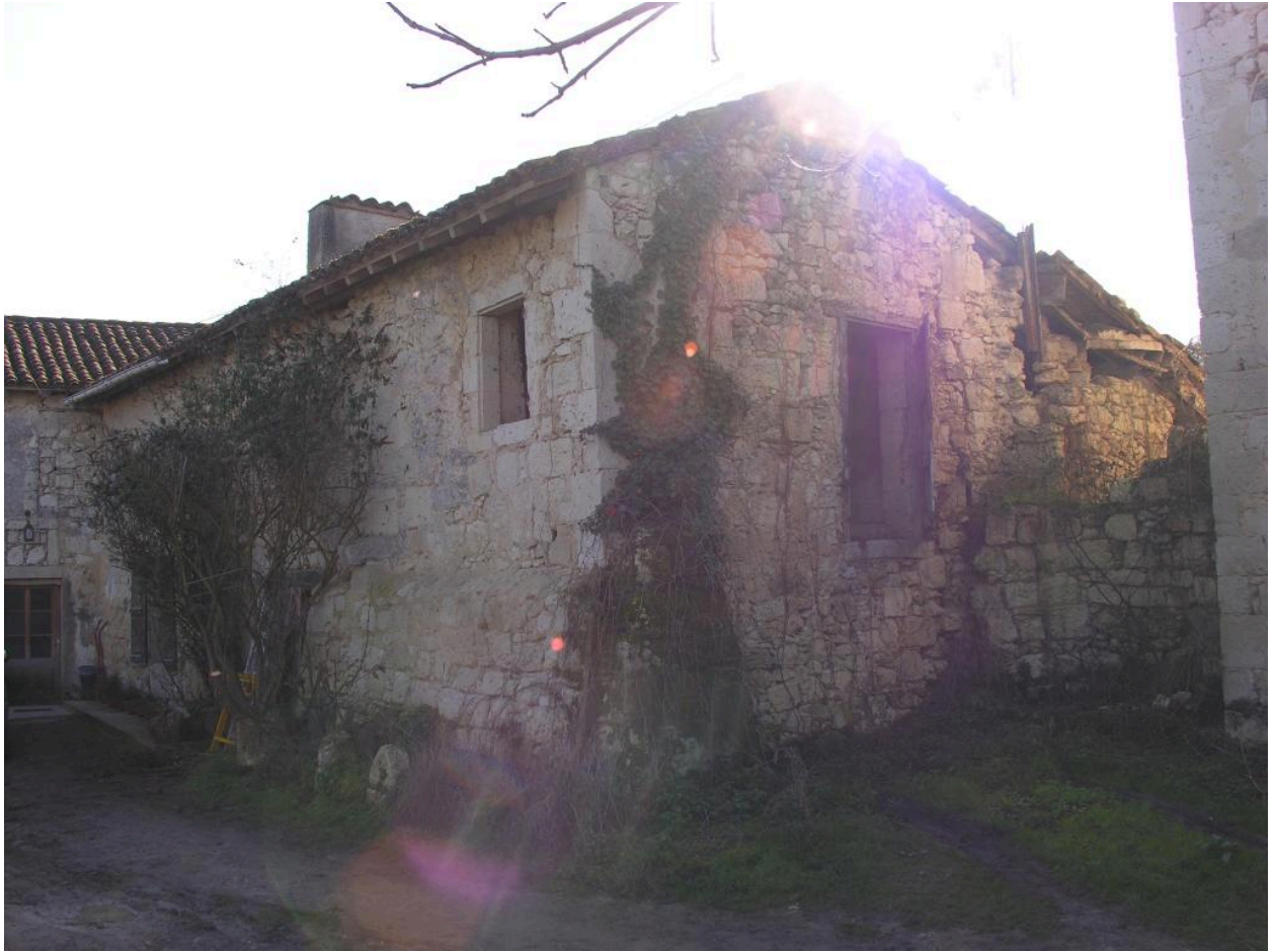
Bâtiment sud (vue nord-est de l'aile nord).
