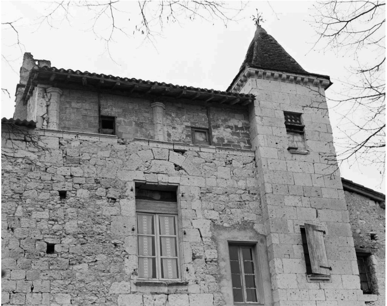
Elévation antérieure, partie supérieure.
