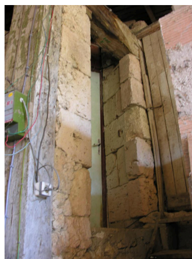
Bâtiment sud : porte sud de l'aile nord. Phot. Gaëlle Prost IVC32208_20103200552NUCA
