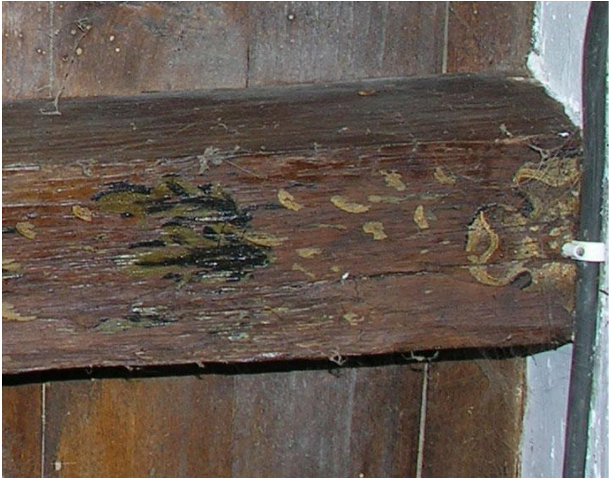
Bâtiment sud : solive peinte.
