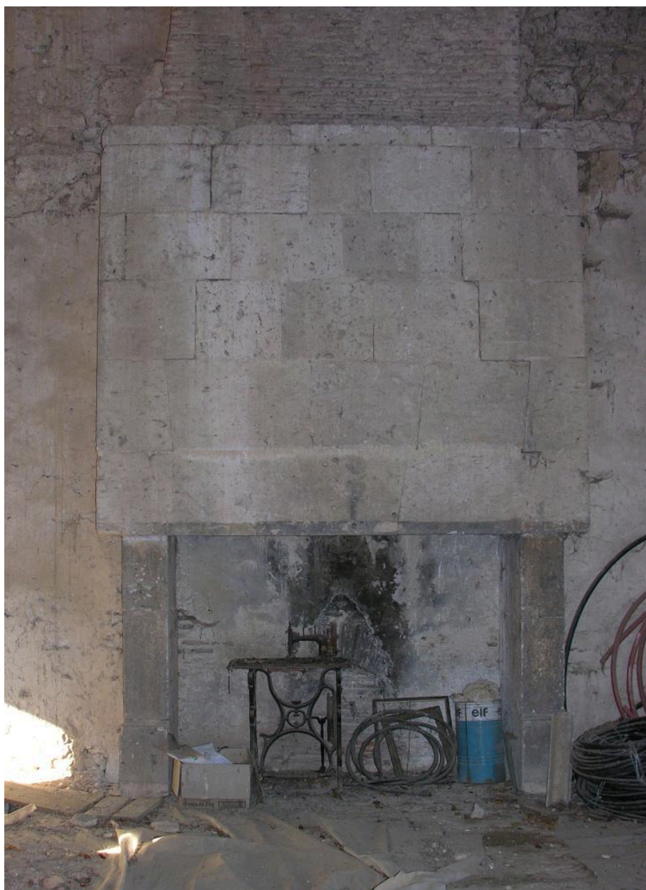
Logis : cheminée sud de l'étage.
