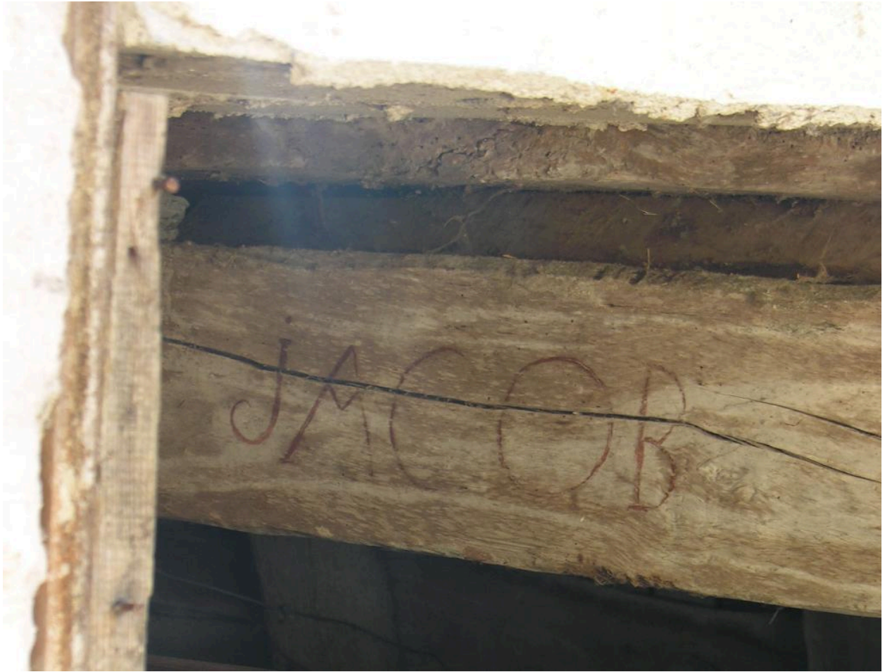
Bâtiment sud : poutre de l'extension de 1775 portant l'inscription « JACOB ».
