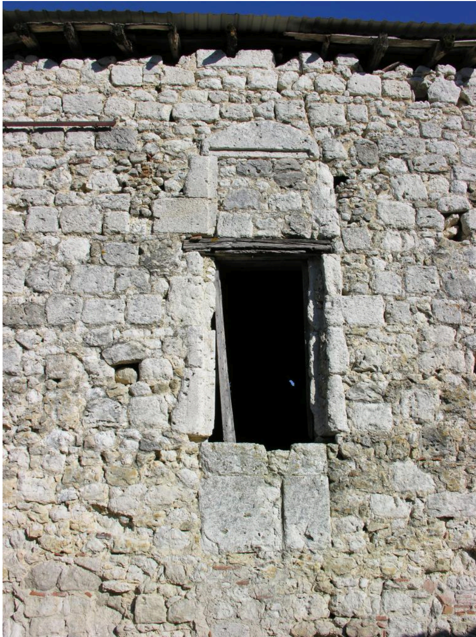
Logis : demi-croisée du mur ouest.
