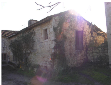
Bâtiment sud (vue nord-est de l'aile nord). Phot. Gaëlle Prost IVC32208_20103200525NUCA
