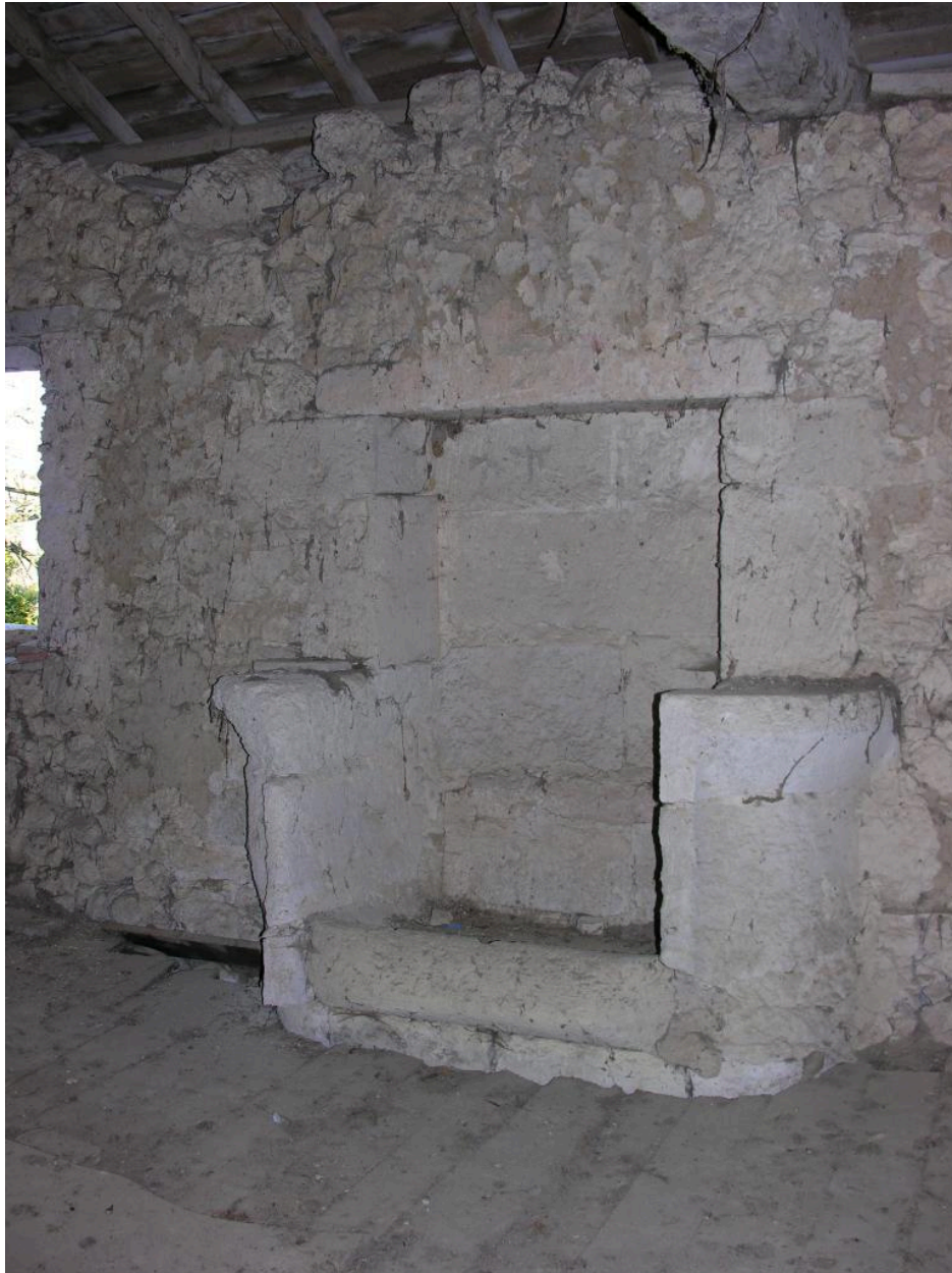
Bâtiment sud : évier de l'étage.
