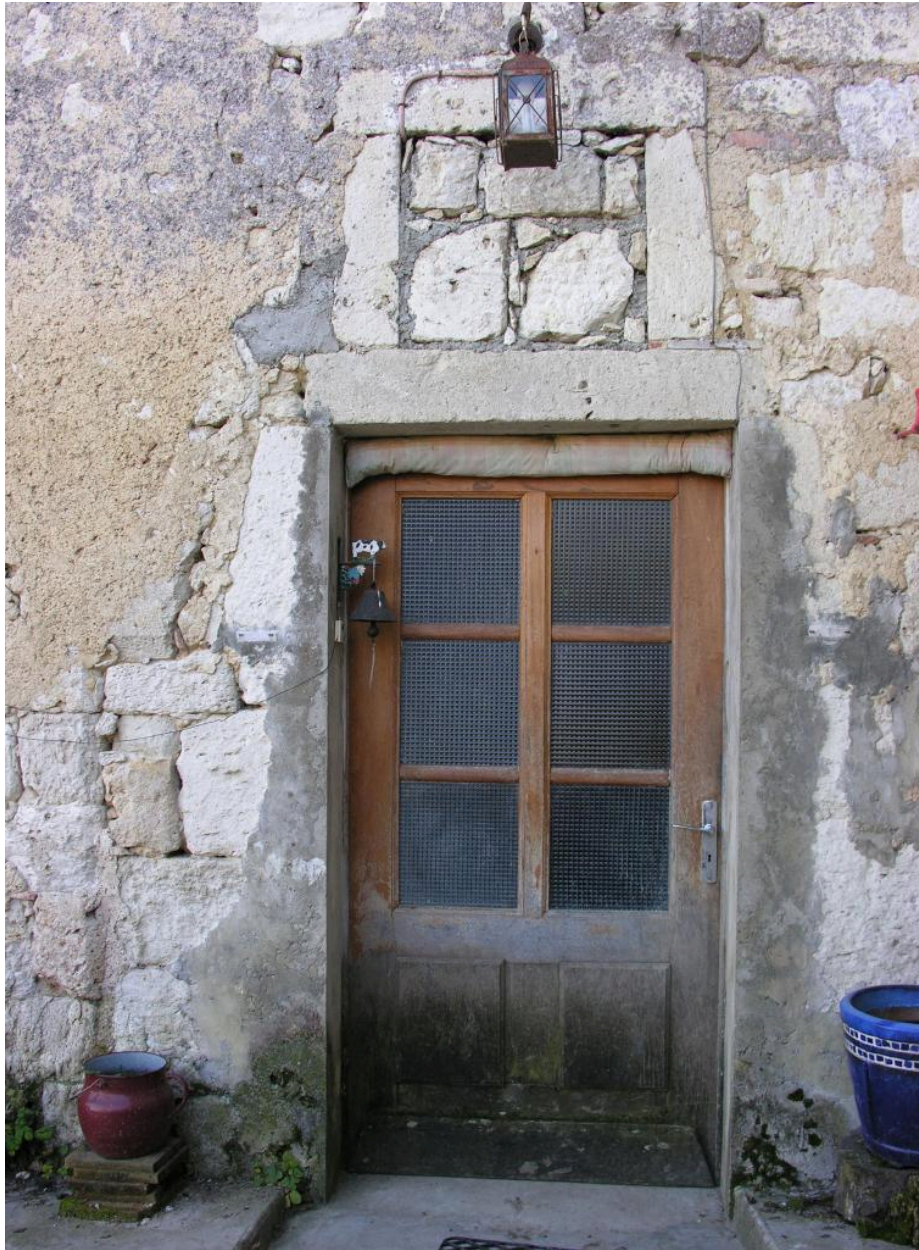
Bâtiment sud : porte de l'aile sud.
