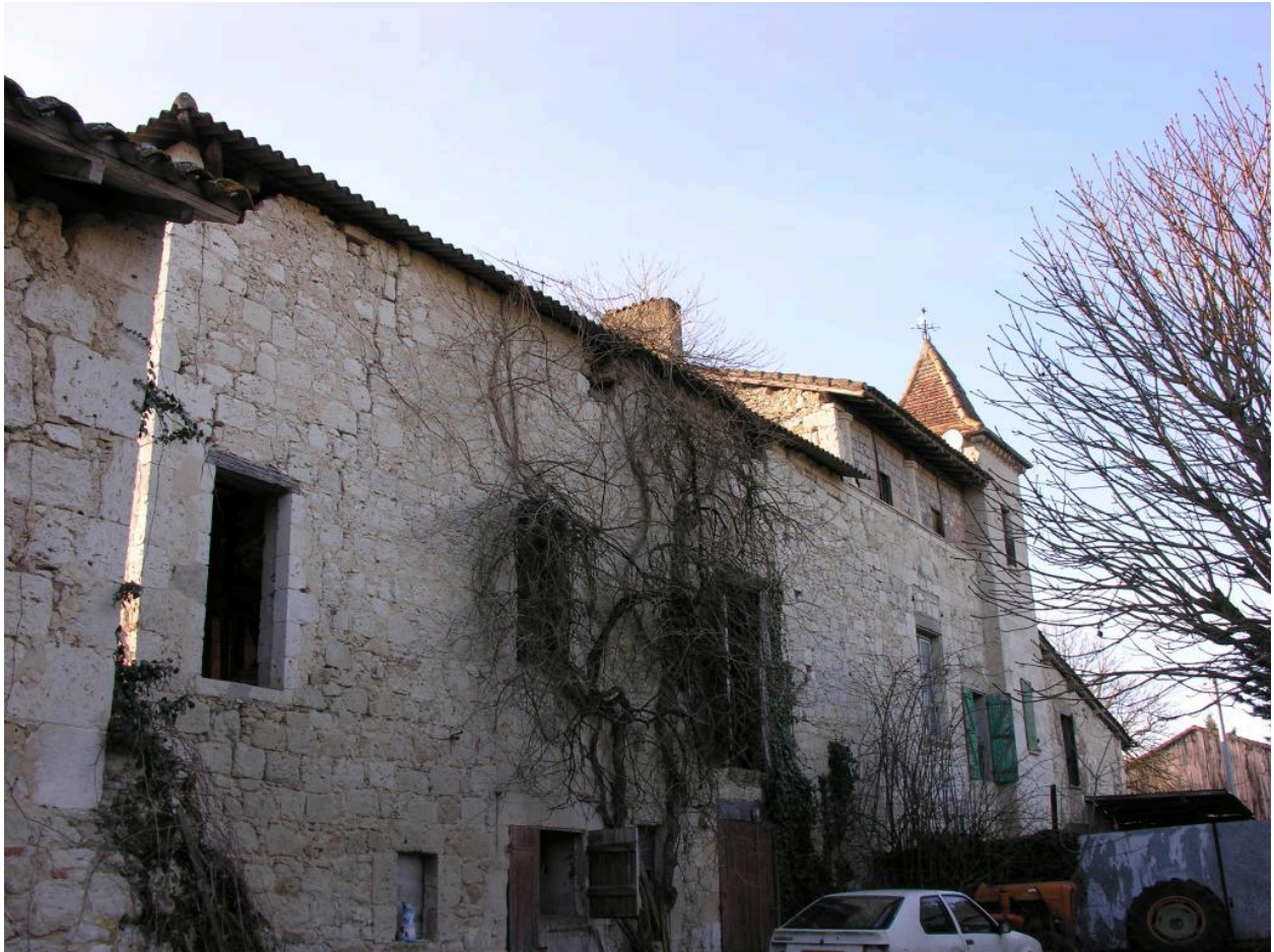
Façade du logis (vue sud-est).
