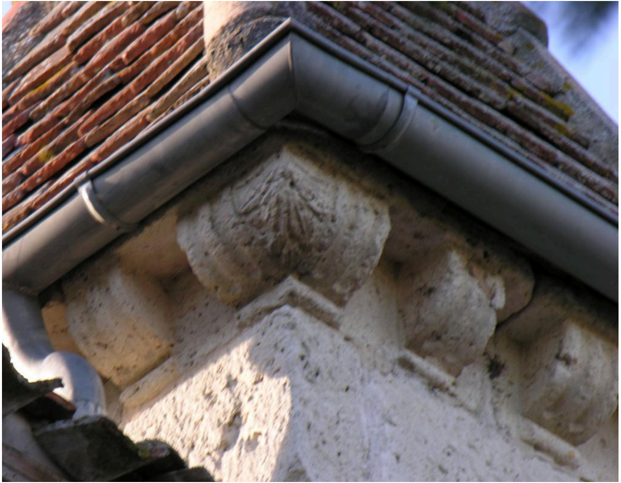
Logis : corniche de la tourelle d'angle.
