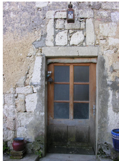
Bâtiment sud : porte de l'aile sud. Phot. Gaëlle Prost IVC32208_20103200550NUCA
