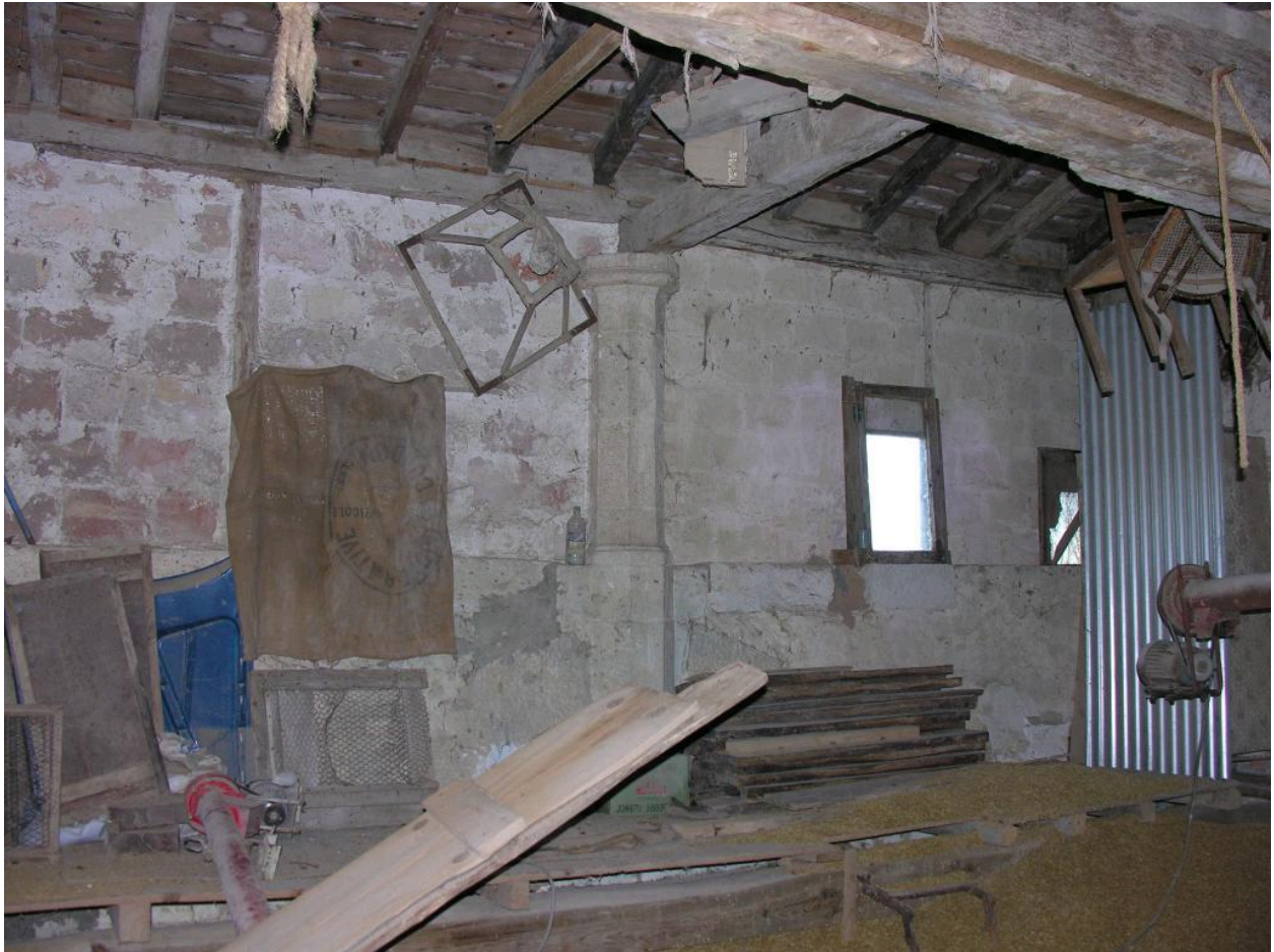
Logis : galerie vue de l'intérieur.
