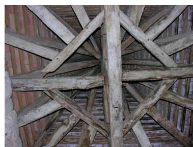
Logis : enrayure de la tour d'angle nord-est. Phot. Gaëlle Prost IVC32208_20103200535NUCA
