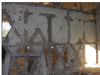
Logis : cloison de l'étage. Phot. Gaëlle Prost IVC32208_20103200533NUCA
