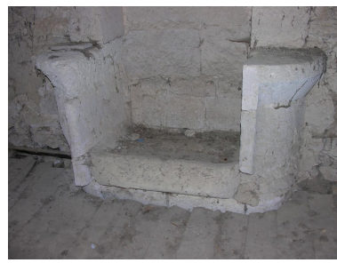
Bâtiment sud : évier de l'étage. Phot. Gaëlle Prost IVC32208_20103200553NUCA
