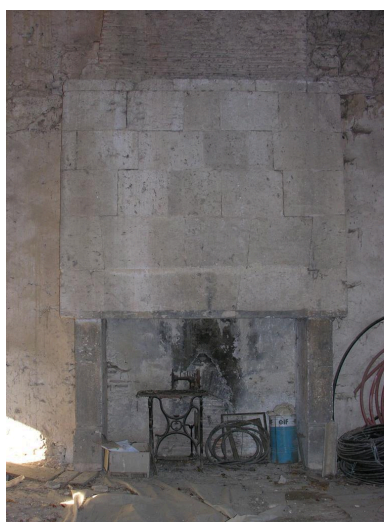
Logis : cheminée sud de l'étage. Phot. Gaëlle Prost IVC32208_20103200531NUCA
