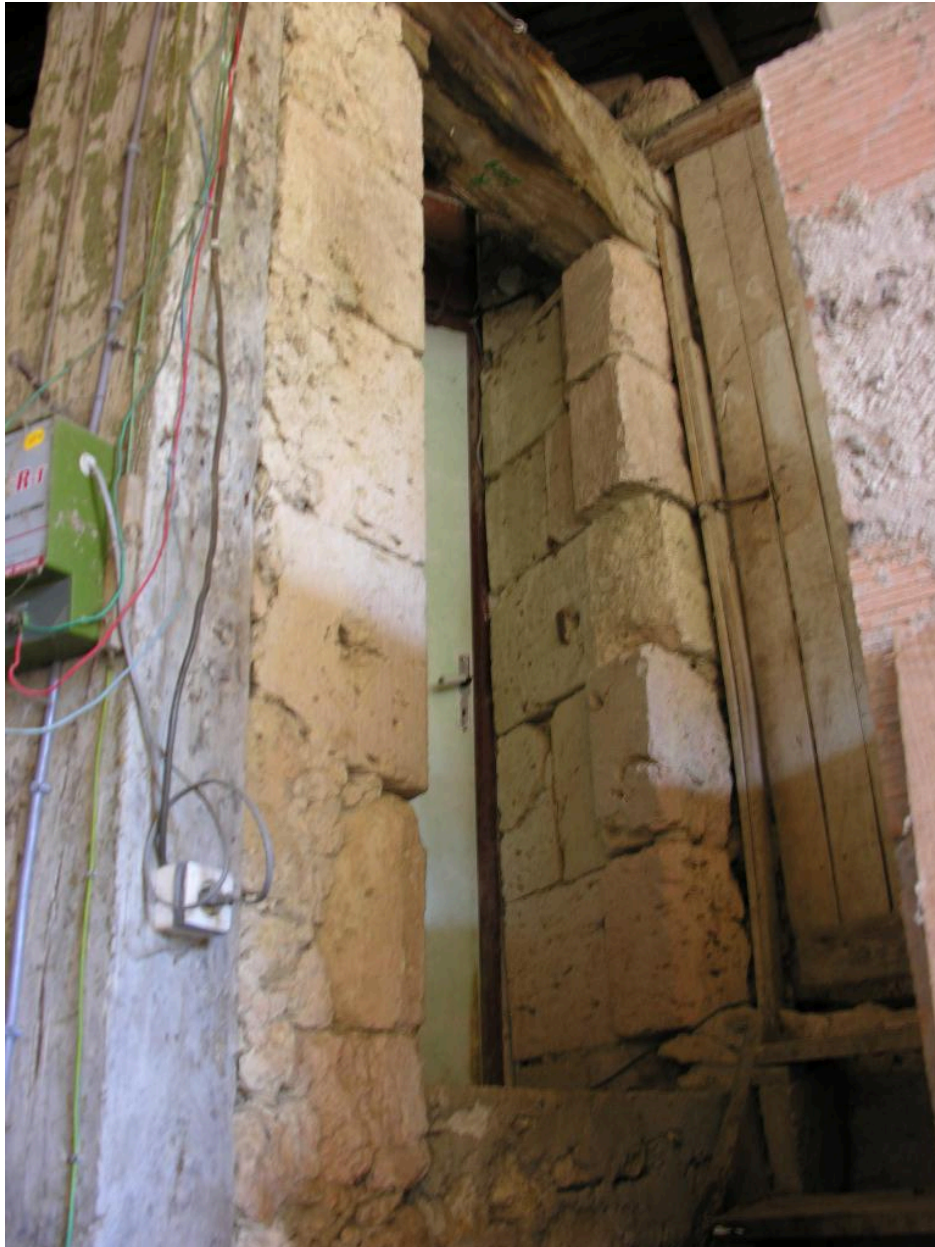
Bâtiment sud : porte sud de l'aile nord.
