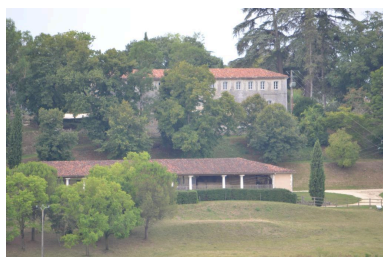
Communs, vue depuis le nord. Phot. Anaïs Comet IVC32013_20193201590NUCA
