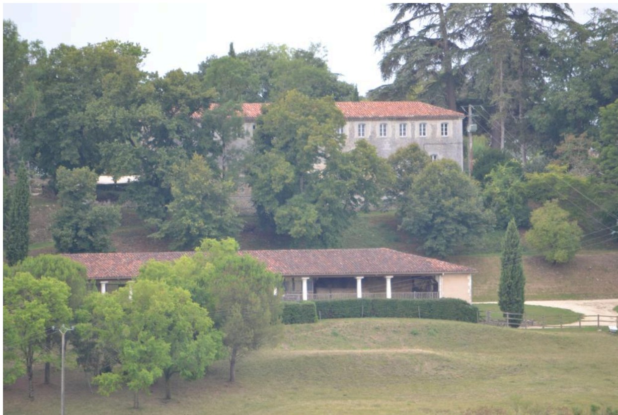
Communs, vue depuis le nord.
