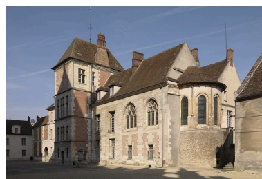
Façade sud (sur cour) : vue d'ensemble, depuis le sud-est. Au premier plan, la chapelle épiscopale avec son abside arrondie (XIIe siècle) et ses deux fenêtres flamboyantes. Phot. Stéphane Asseline IVR11_20097700170NUC4A
