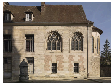
La chapelle des évêques : vue extérieure, depuis le sud. Phot. Stéphane Asseline IVR11_20097700175NUC4A
