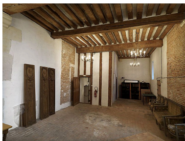
La salle en haut de l'escalier principal : vue intérieure, prise depuis le sud. La partie en pan-de-bois correspond à la cage de l'escalier en vis desservant ce niveau (cliché 20127700174NUC4A). Phot. Jean-Bernard Vialles IVR11_20127700173NUC4A
