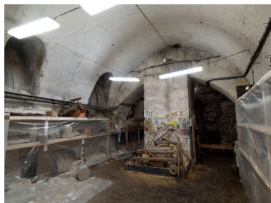
La grande cave occidentale : vue d'ensemble, depuis l'est. Phot. Jean-Bernard Vialles IVR11_20127700950NUC4A
