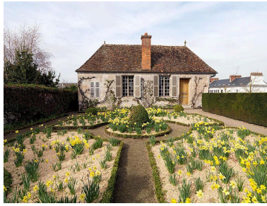
Le "pavillon de Bossuet", sur la terrasse des remparts : élévation orientale, vue de face. Phot. Jean-Bernard Vialles IVR11_20147700206NUC4A
