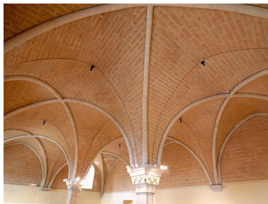
La salle basse orientale : vue d'ensemble du voûtement. Phot. Stéphane Asseline IVR11_20087700170NUC4A
