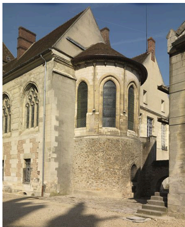
Vue des élévations orientales de l'ancien palais épiscopal, depuis la cour au nord de la cathédrale. La partie arrondie correspond à l'abside de la chapelle privée de l'évêque (XIIe siècle). Phot. Stéphane Asseline IVR11_20097700173NUC4A
