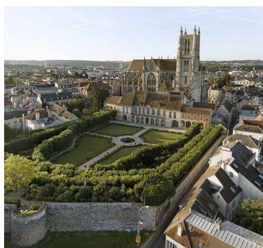
Vue panoramique, prise depuis un ballon captif : le palais épiscopal vu du nord, avec son jardin allant jusqu'au rempart du Bas Empire. Phot. delage.balloide-photo.com IVR11_20127701123NUC4A
