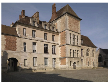
Façade sud (sur cour) : vue d'ensemble du corps principal, depuis le sud-ouest. Phot. Stéphane Asseline IVR11_20097700171NUC4A
