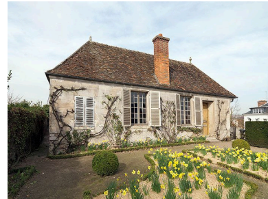
Le "pavillon de Bossuet", sur la terrasse des remparts : élévation orientale, vue du sud-est. Phot. Jean-Bernard Vialles IVR11_20147700207NUC4A
