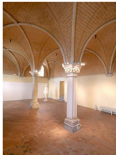
La salle basse orientale : vue d'ensemble (verticale), depuis le nord-ouest. Phot. Stéphane Asseline IVR11_20087700169NUC4A
