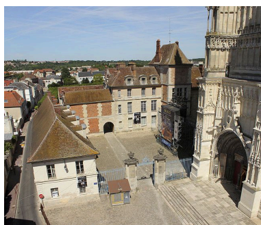
Vue panoramique, prise depuis un ballon captif : la cour d'honneur. Phot. delage.balloide-photo.com IVR11_20127701076NUC4A
