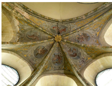
La chapelle haute du palais épiscopal : voûte d'ogives de l'abside. Phot. Stéphane Asseline IVR11_20087700157NUC4A
