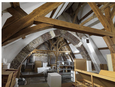
Vue des combles dans l'angle nord-est de l'édifice, prise depuis le mur pignon. Phot. Jean-Bernard Vialles IVR11_20127700176NUC4A
