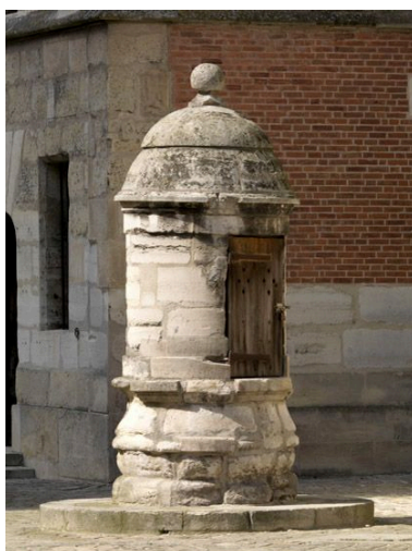
Le puits couvert, dans la cour devant l'ancien palais épiscopal. Phot. Stéphane Asseline IVR11_20087700248NUC4A
