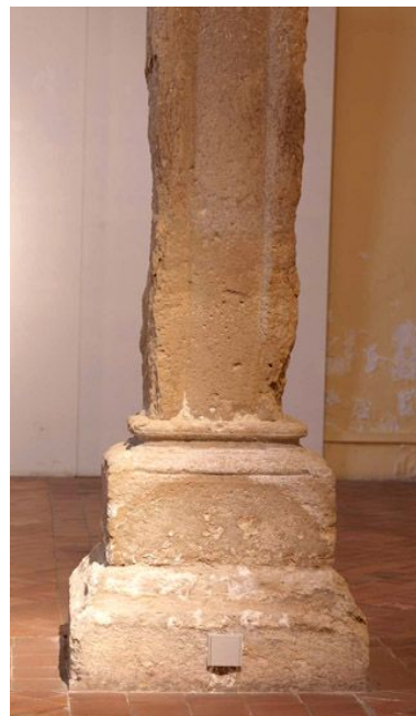
La salle basse occidentale : détail d'une base de pilier, très érodé. Phot. Stéphane Asseline IVR11_20087700181NUC4A
