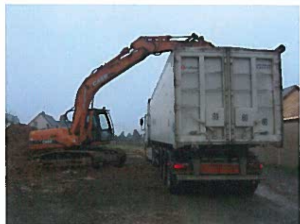
Chargement des terres
