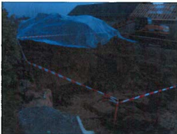
Stockage des terres
