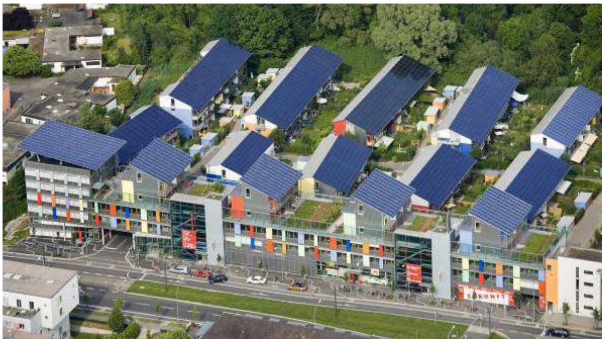
Fig. 3-13 “Solarsiedlung Am Schlierberg” project site
