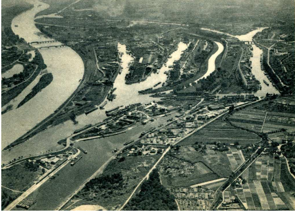
L'Île aux Epis lors de la construction du Port du Rhin
