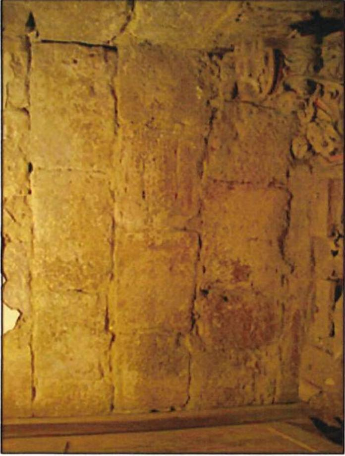
Fig. 181: MUR 15 chaîné avec le MUR 16
