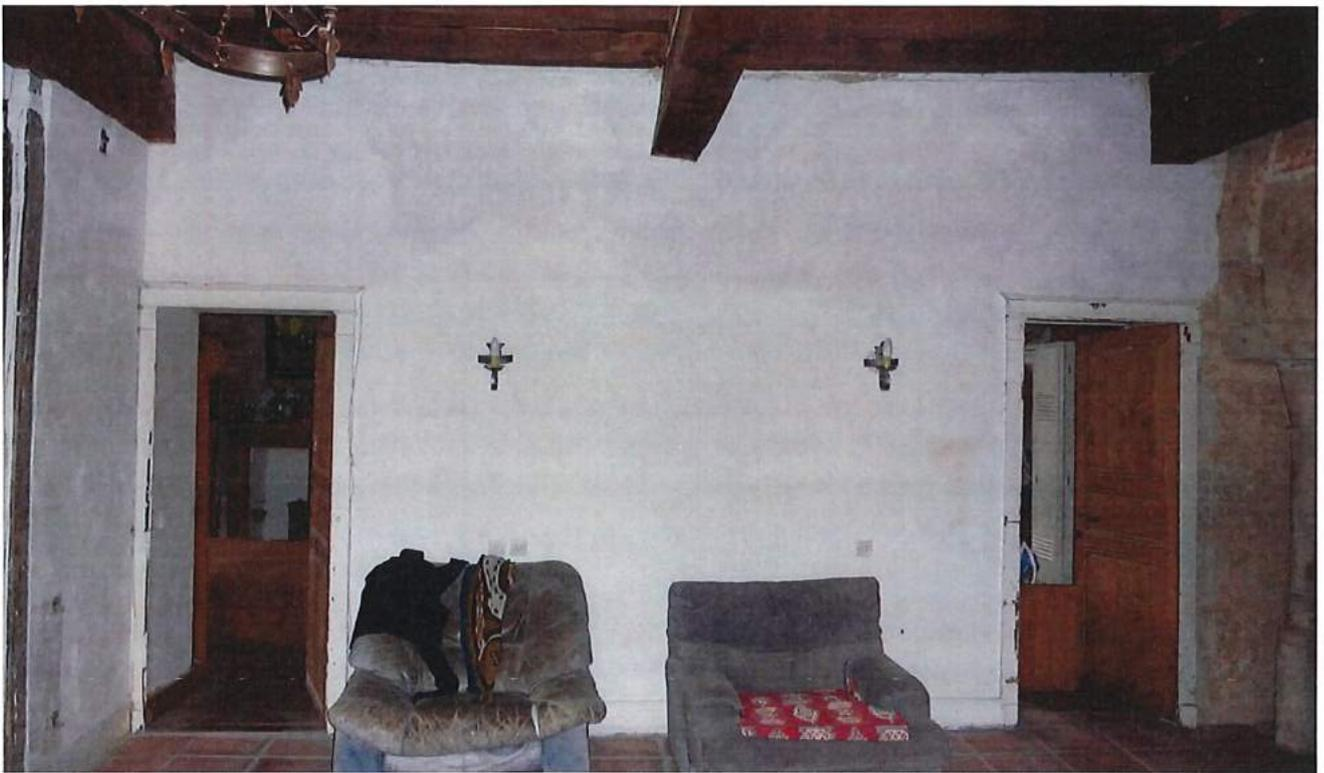
Fig. 79 : Cloison 2 séparant la pièce 3 des pièces 4 et 5
