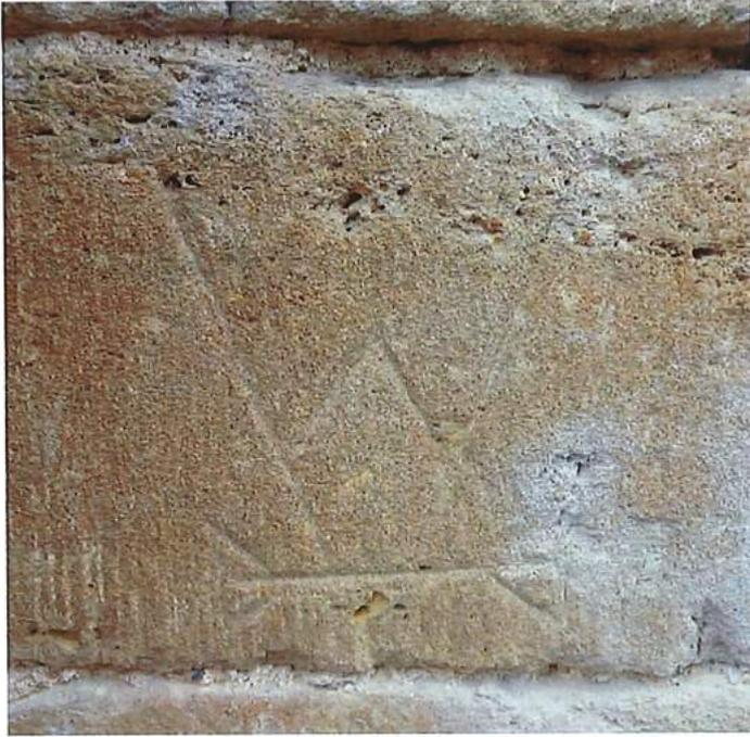
Fig. 53: Marques réalisées avant la pose
