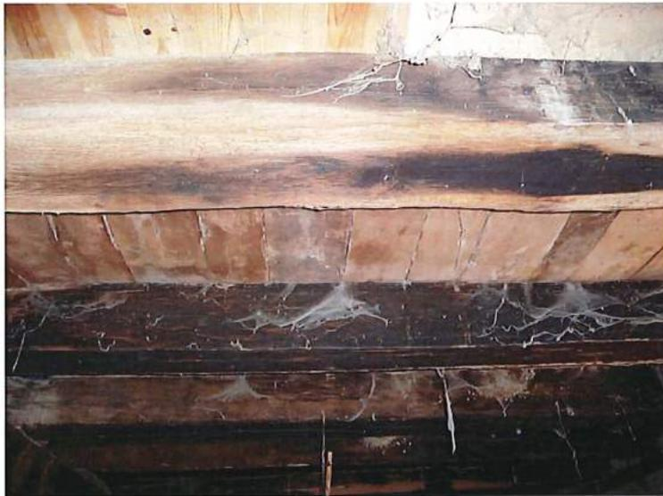
Fig. 119 : Traces de feu constatées sur les planchers et les poutres de la tour
