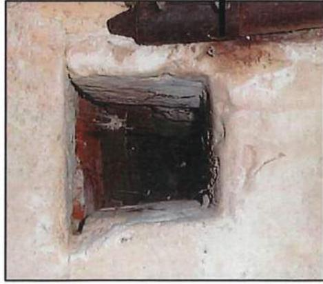
Système de fermeture: encoche pour glisser la poutre dans le mur
