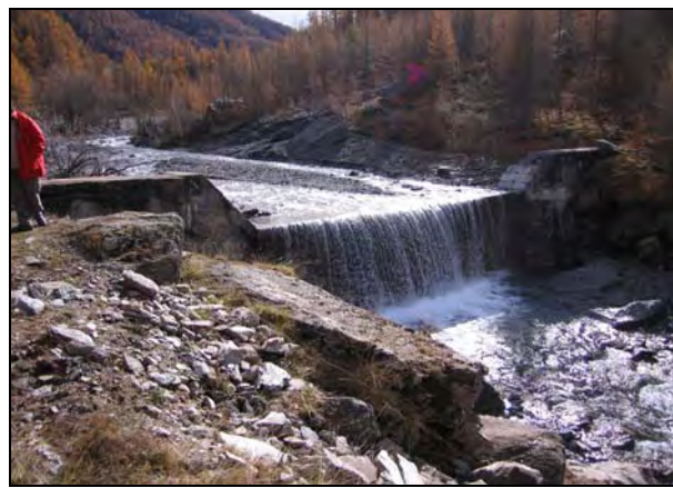
Fig. 3.37 - Briglia n. 2 nella situazione attuale (a sinistra) e simulazione dell'intervento previsto (a destra) mediante la realizzazione di una rampa di risalita per l'ittiofauna.
