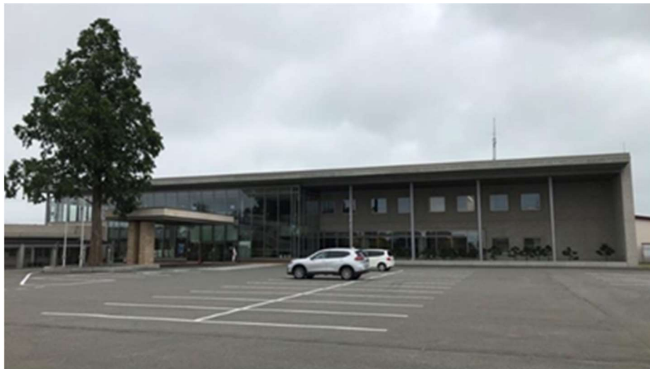
図 3.3.2 公共施設(北村支所)駐車場 実証環境 外観
