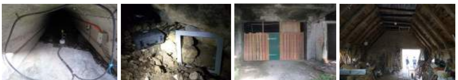
Figures ci-dessus : antennes installées (de gauche à droite) au Barrage de l'Aigle, au Gouffre de la Fage, à Dampniat et à Monceaux-sur-Dordogne
