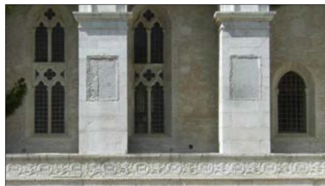
FIG. 2.41 Rimini, Temple de Malatesta, flanc Nord, en avant plan, les pilastres d'Alberti en Pierre d'Istrie et dans le fond l'architecture gothique de l'église San-Francesco (source : N. Detry, 2010)
