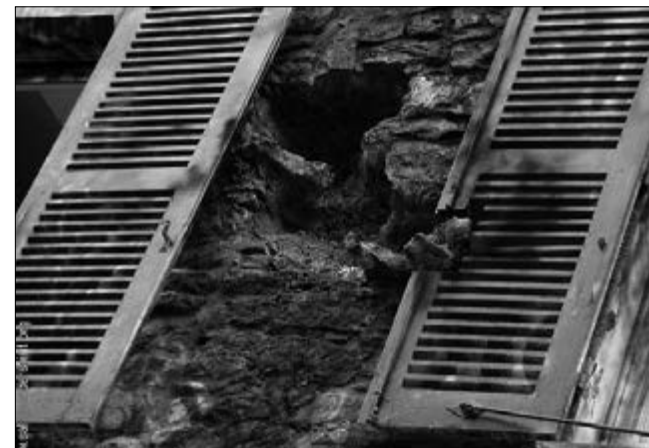
FIG. 2.26 Demeure du Chaos, détail d'une façade, principe de soustraction de matière, scarification, trace d'impact (source : Catalogue Raisonné, 2006).
