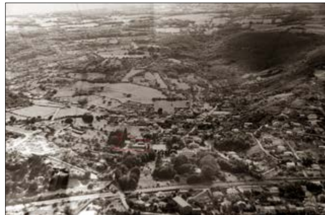
FIG. 1.12 Vue aérienne depuis Rochetaillée-sur-Saône, dans les années 1950, détail (AM Saint-Romain-au-Mont-d'Or)
