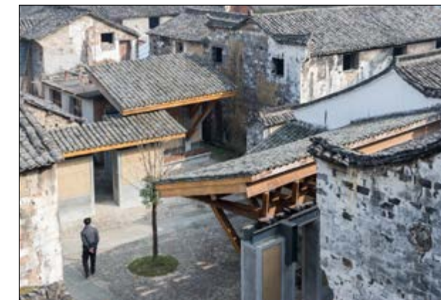
FIG. 2.42 Village de Wencun en Chine, mélange entre anciennes maisons restaurées, nouveaux éléments bâtis en partie avec des matériaux de réemploi et urbanisme inclusif; façon traditionnelle de bâtir les murs maçonnées, le wapan (source : Kenneth Frampton, 2016, On The Work of Wang Shu and Lu Wenyu ; exposition au Musée Louisiana Copenhagen)
