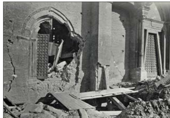
FIG. 2.25 Bologna, façade ouest de l'église du couvent de San Francesco, état vers 1945 (source : SBAP-bO. Fonds Alfredo Barbacci)
