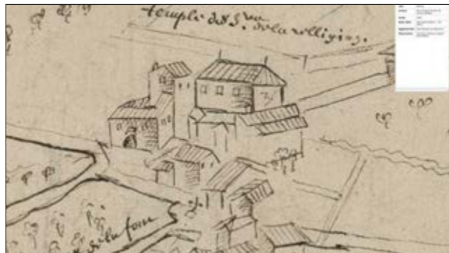
FIG. 1.15 Terrier du chapitre primatial de Lyon, après 1630. Détail sur le Temple Protestant de Saint-Romain-de-Couzon (AML. 3S0251)
