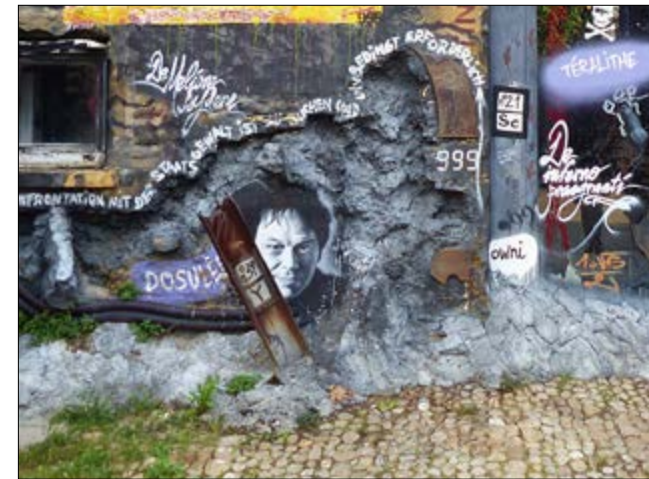
FIG. 2.24 Demeure du Chaos, façade ouest, bâtiment D, exemple d'addition et de soustraction de matières et d'éléments. La maçonnerie est comme scarifiée, un glacis irrégulier en béton marque le pied des murs. Le pavement extérieur en calade de galets (élément ancien et qualitatif) est conservé
