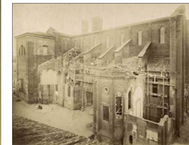
FIG. 2.22 Photo du chantier de restauration datée de 1884, la restauration passe par la démolition des éléments pochés en jaune ; ajouts jugés incompatibles par Alfonso Rubbiani. (source : SBAP-Bo)
