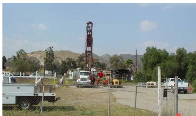
● Instalamos 6 Pozos de bombeo en la Zona 3.
