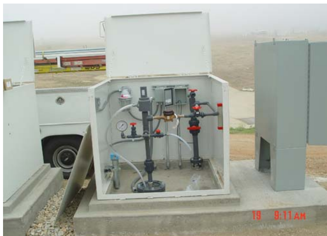
● Se agregaron 2 pozos a la zona 1 para remover contaminación.
