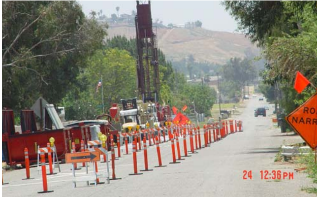
Instalamos 4 pozos (FC-1011rama) cerca de Jurupa Road y la Calle Agate en la zona 4, para investigar el agua subterránea.
