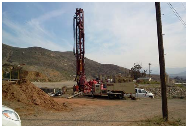
● Estudio piloto de fracturación se llevó a cabo para acelerar la remoción de la contaminación en zona 1B.
