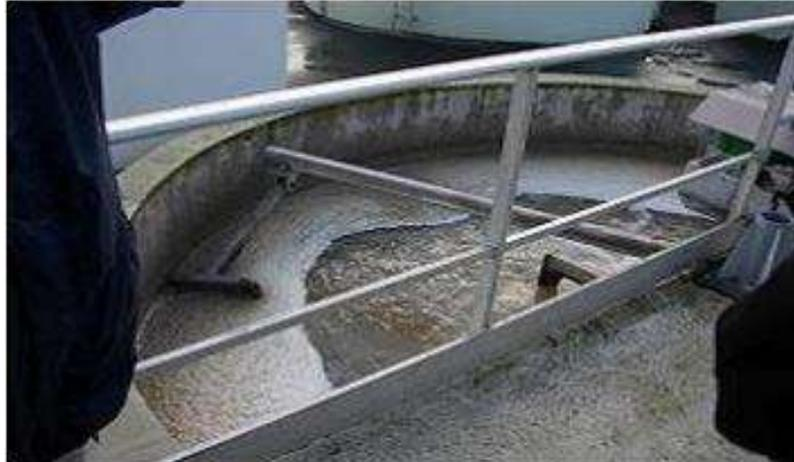
Figure I.5 : Le dégraissage déshuilage (Anonyme 2006).
