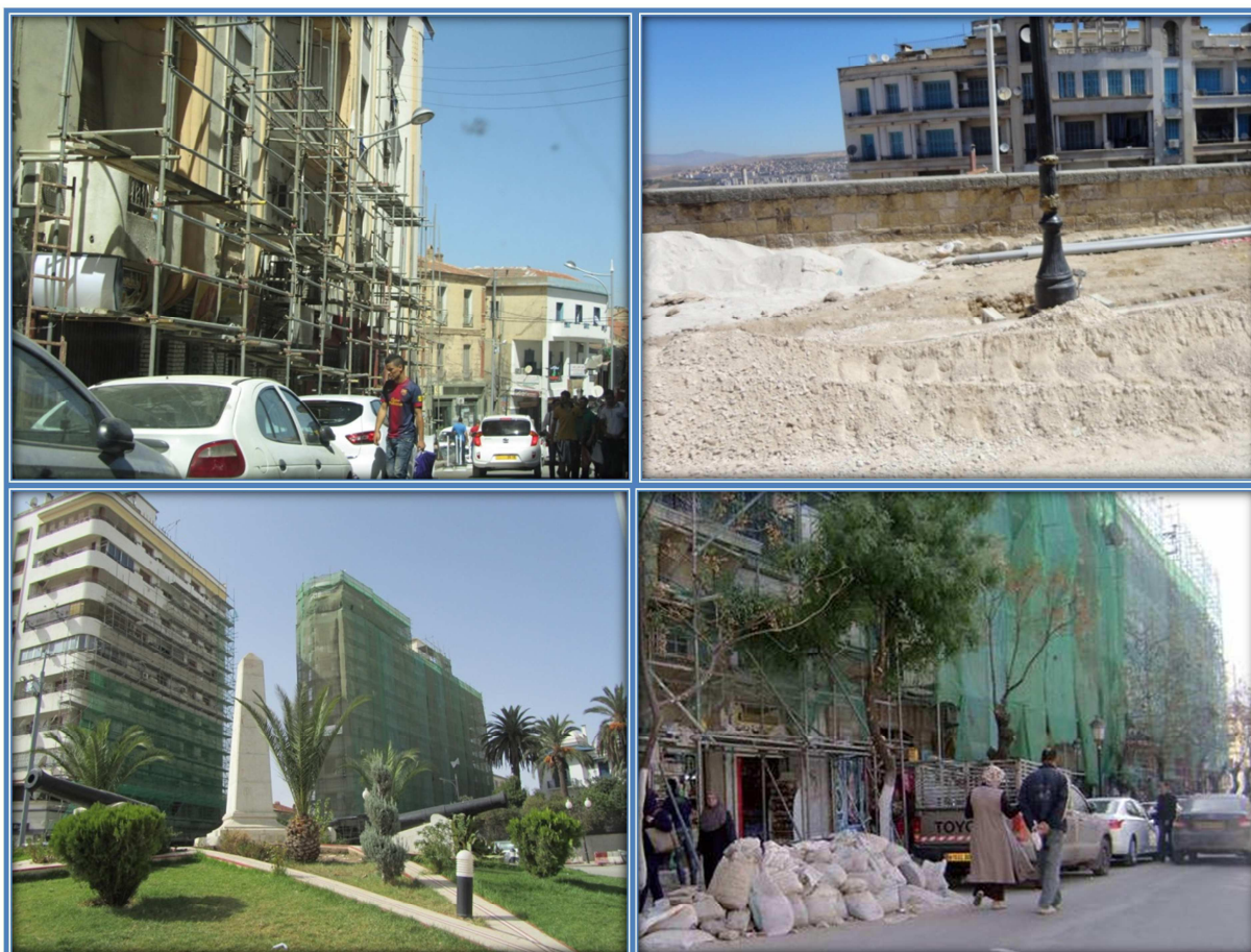
Image N°09 : travaux d'embellissement, Constantine, 2014-2015.
