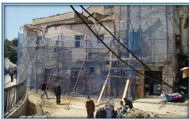
Image N°07 : Début de l'intervention sur les façades, dans le cadre de la réhabilitation de la Souika.
